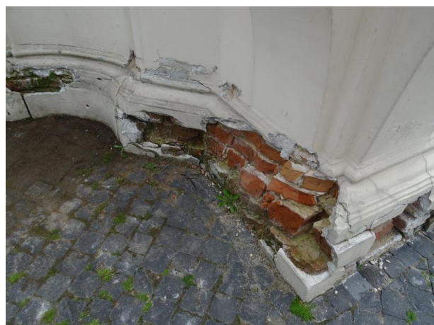
Fot. 15 Uszkodzenie cokołu w narożu południowo-zachodnim
