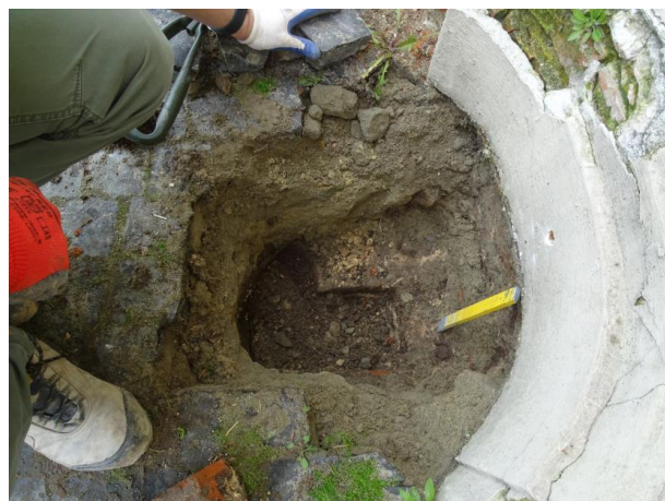
Fot. 7 Warstwy podsypki cementowo-piaskowej
