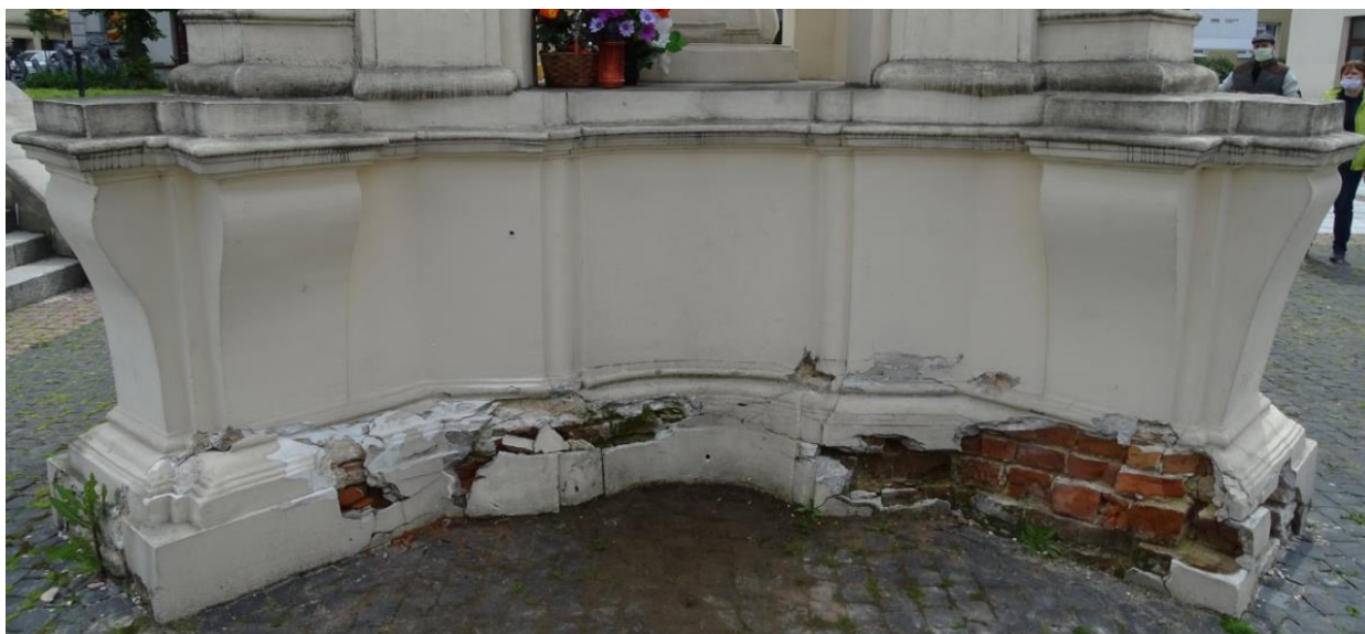
Fot. 13 Widok na uszkodzenia cokołu
