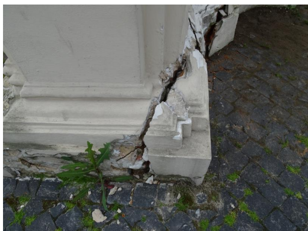
Fot. 14 Odspojenie fragmentu cokołu w narożu północno-zachodnim
