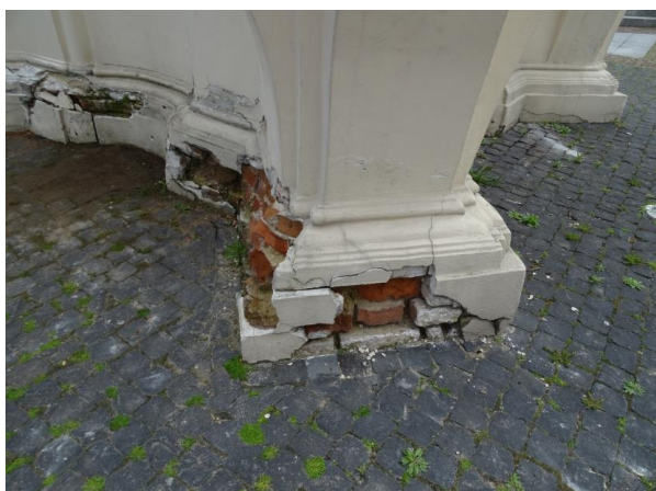
Fot. 16 Zniszczenie tynków i muru cokołu – naroże południowo-zachodnie
