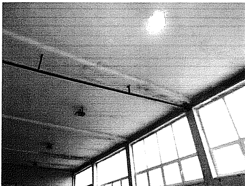
Fot.5. Grzyby-pleśnie na stropie i nadprożach okiennych.
