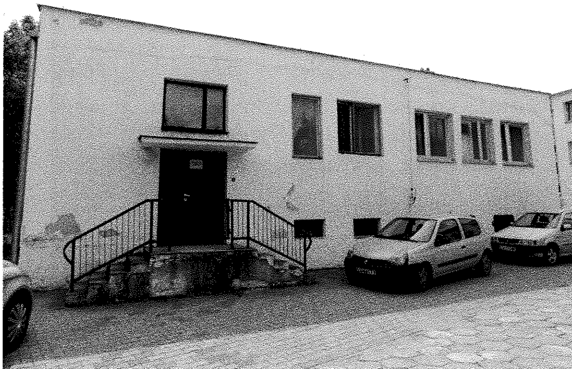
WIDOK NA ŚCIANĘ SZCZYTOWĄ ZAPLECZ KUCHNI. ZARYSOWANIE ATTYKI NA STYKU WIERZCHU STROPODACHU. WYKONAĆ NAPRAWĘ WG. PROJEKTU WYKONAWCZEGO. DASZEK ŻELBETOWY DO USUNIĘCIA I ZASTĄPIENIA NOWYM DASZKIEM W KONSTRUKCJI STAŁOWEJ Z ODCIĄGAMI.
