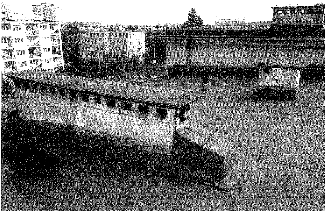
Fot. Wszystkie otwory w kominach są zabezpieczone i uniemożliwiają dostęp nietoperzom i ptakom.
