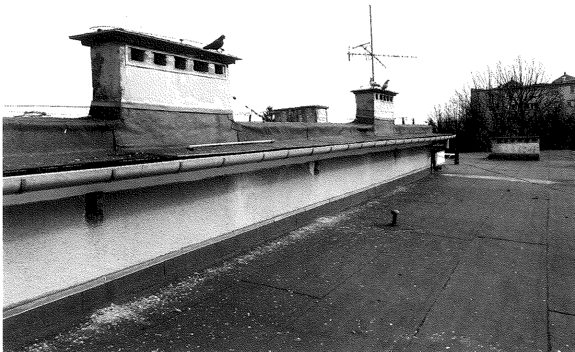
Fot. Dach i widoczne otwory wentylacyjne prowadzące do stropodachu z łęgami gołębi miejskich i kawek.
