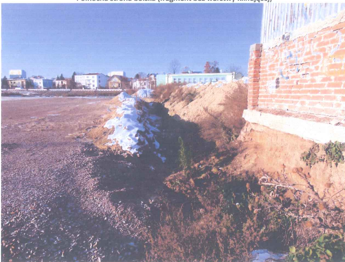
Północna strona boiska (wykop pod mur oporowy, hałdy ziemi)
