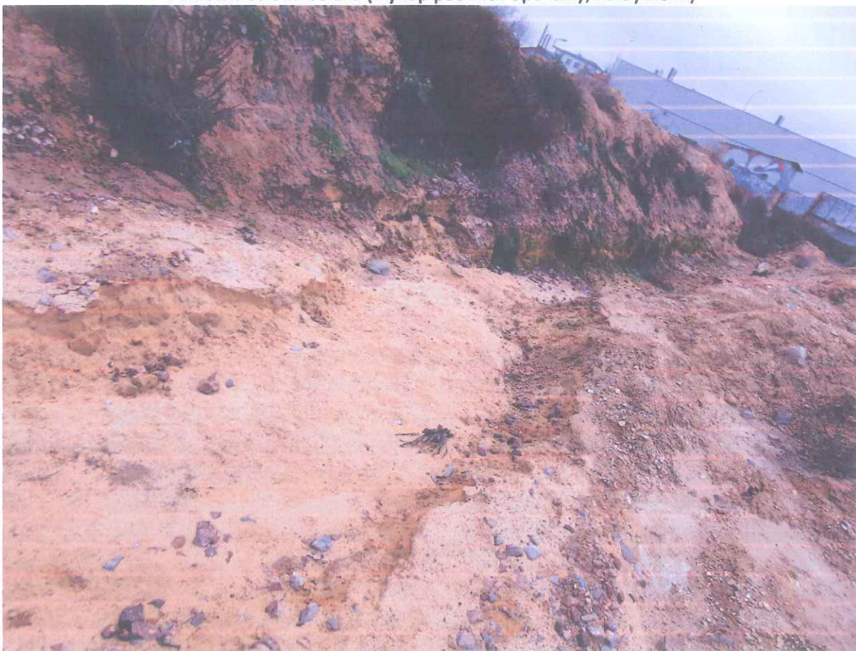
jw. - wykop pod mur oporowy
