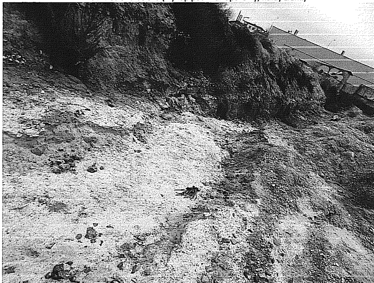
jw. - wykop pod mur oporowy
