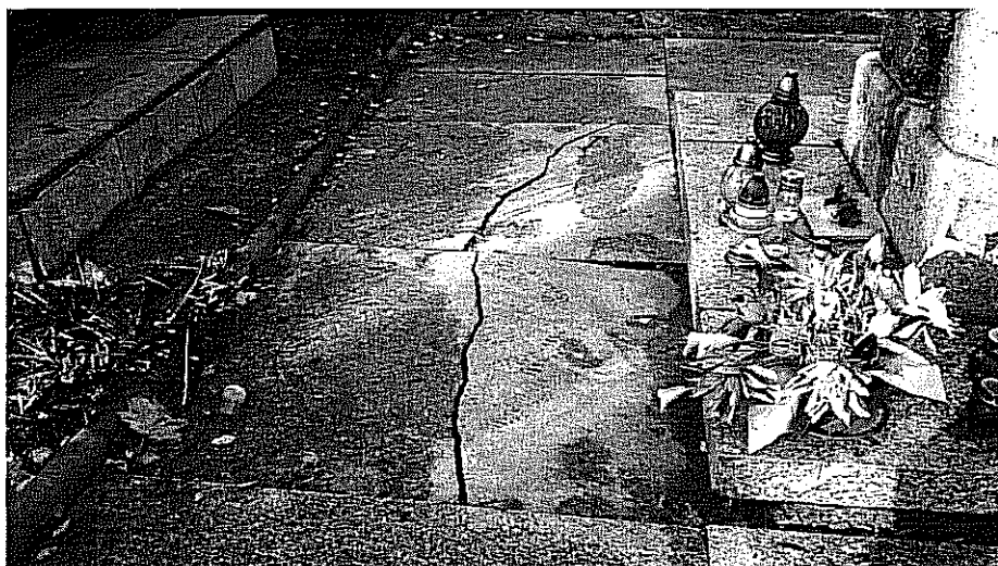
Fot.1.4 Zniszczona opaska granitowa wokół pomnika Matki Płaczącej.
