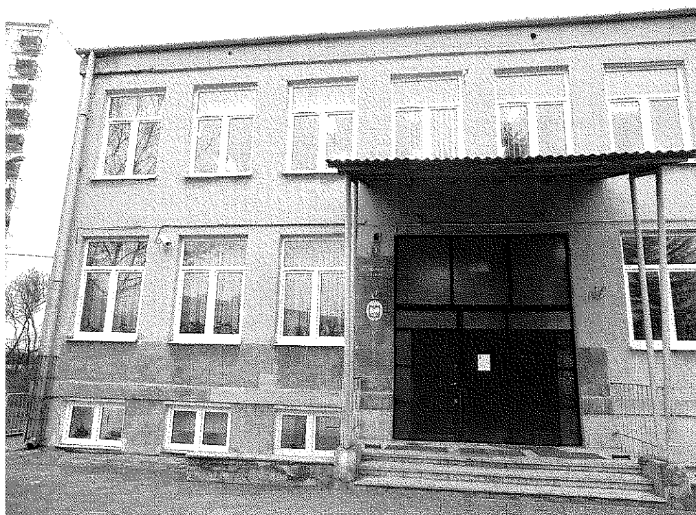
Fot. 1. Wejście do Szkoły Podstawowej nr 34 w lutym w 2012 r. – na górze niezabezpieczone otwory wlotowe na stropodach
