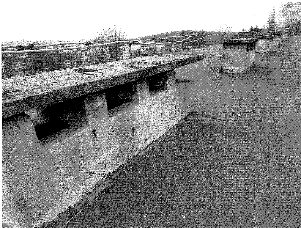
Fot. 2. Niezabezpieczone otwory wlotowe do kominów wentylacyjnych
