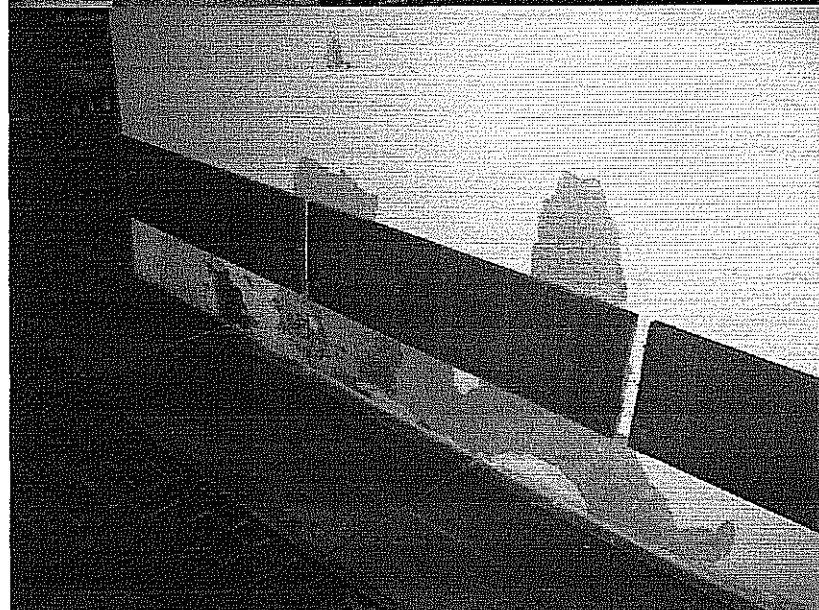
Fot.6. Wysolenia nad zabudową drewnianą
