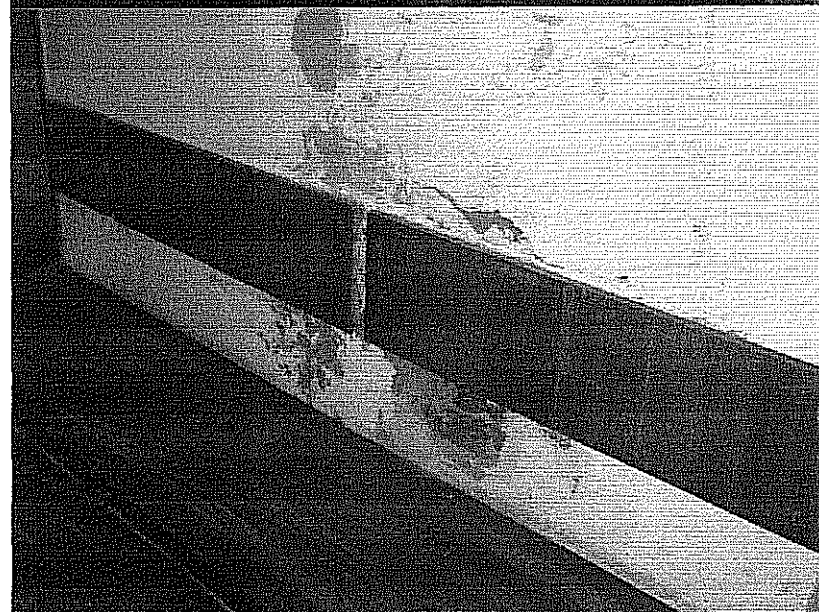
Fot.7. Wysolenia powodujące destrukcję muru – widoczne cegły.
