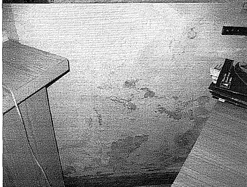
Fot. 11. Biblioteka – wysolenia na ścianie zewnętrznej
