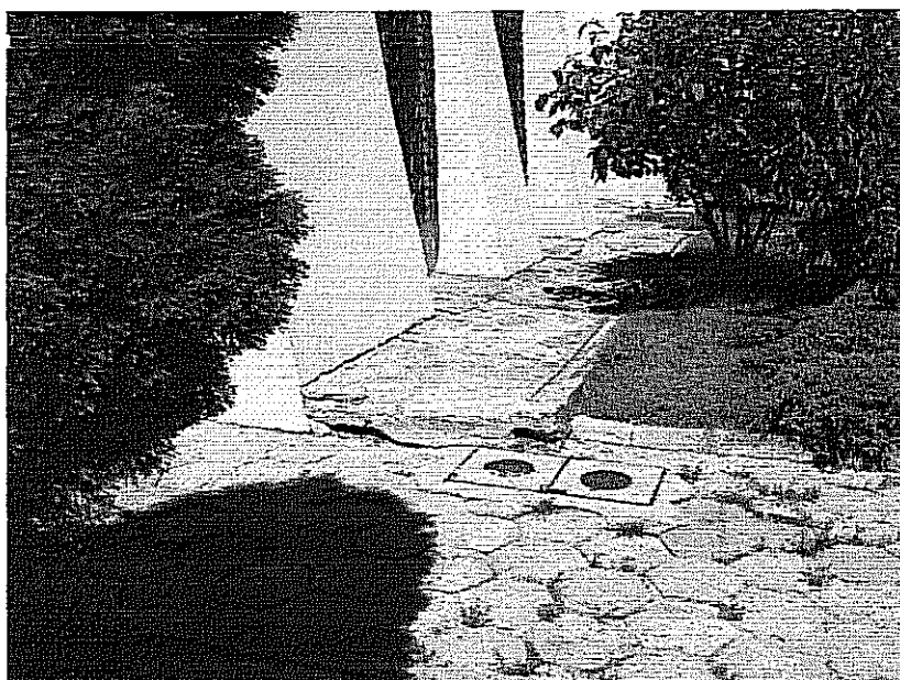
Fot.2. Zniszczona opaska odwadniająca i poprzeczne korytko zatrzymujące wody opadowe na opasce
