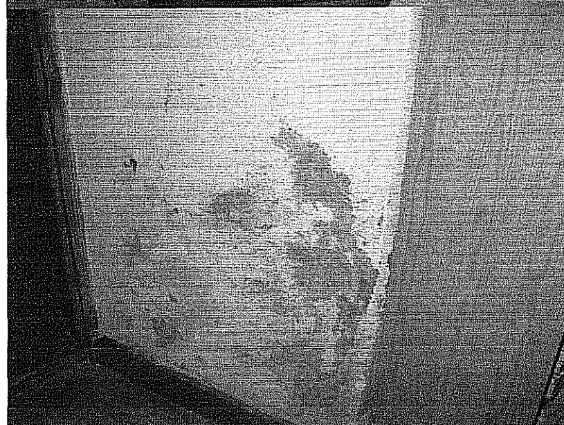
Fot. 12. Wysolenia na ścianie wewnętrznej - biblioteka
