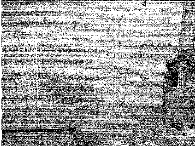
Fot. 9 Wysolenia i ogniska grzybów pleśni na ścianie w pomieszczeniu gospodarczym - piwnice
