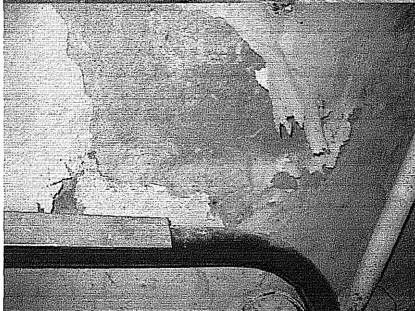
Fot. 10 Odspojone w wyniku wysoleń warstwy farby.
