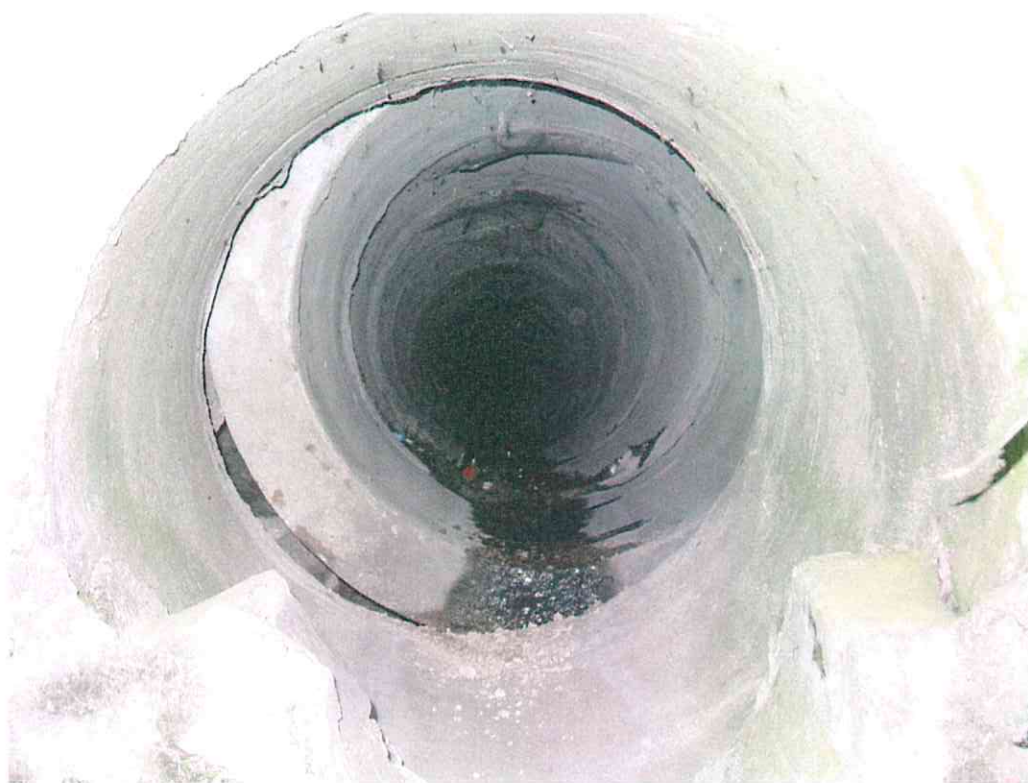
Zdjęcie nr 3 – rozsunięcie ostatniego odcinka sieci
