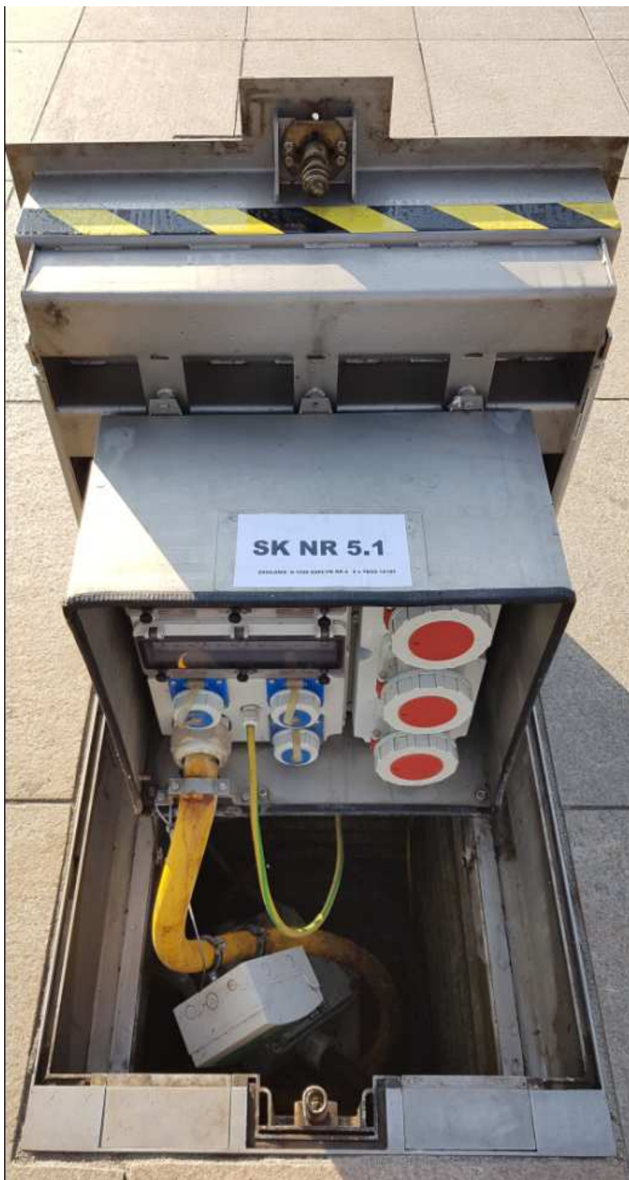
Załącznik nr 9 do OPZ Studnia z gniazdami elektrycznymi na pl. Litewskim
