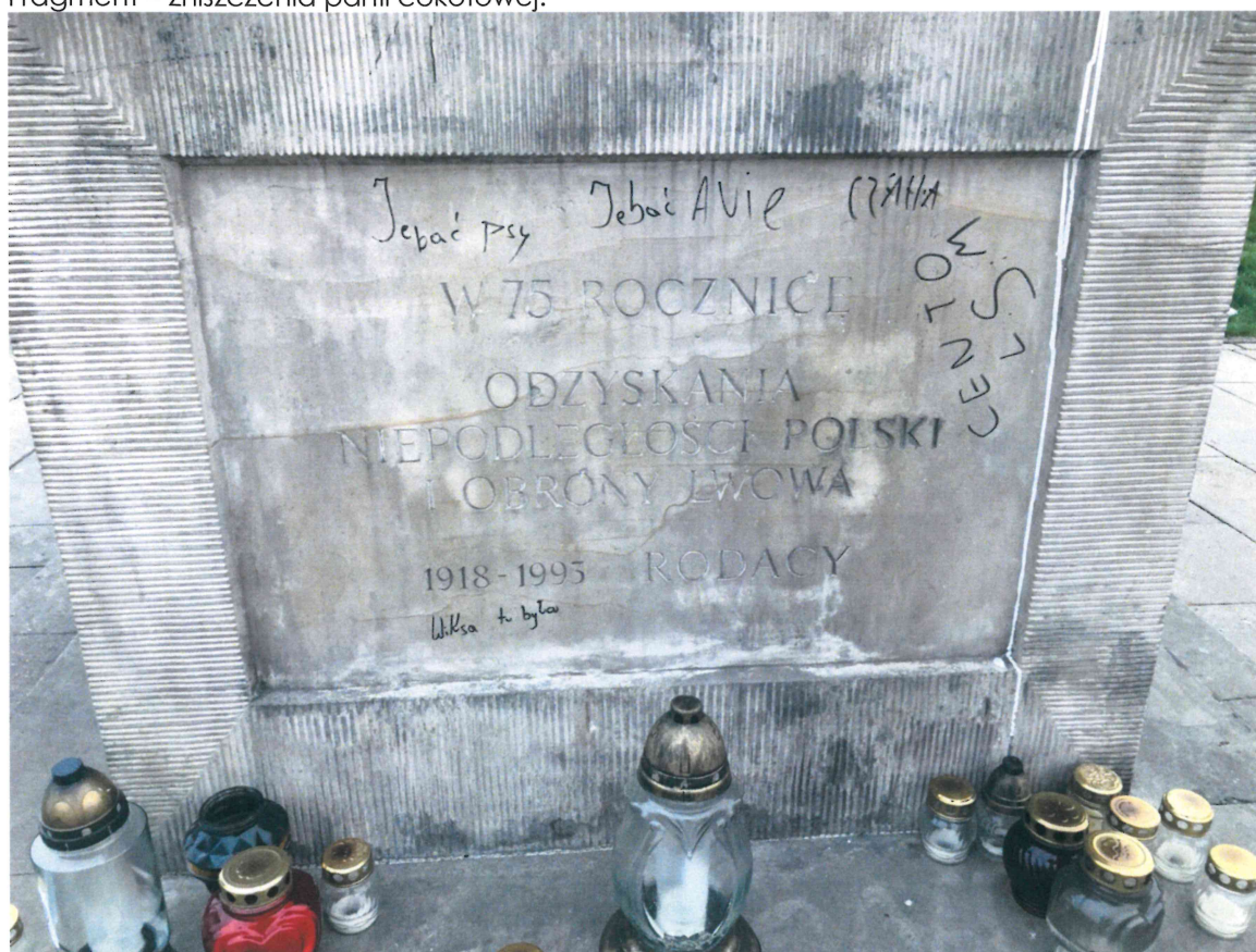
Fot. nr 18– Lew – symbol Lwowa . Pomnik na wzgórzu zamkowym w Lublinie, ul Zamkowa 9. Fragment – zniszczenia tablicy frontowej.
