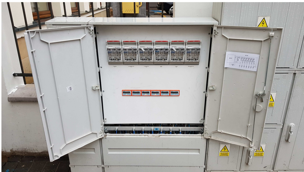
Załącznik nr 12 do OPZ Złącze kablowe do zasilania imprez masowych ZK-IM
