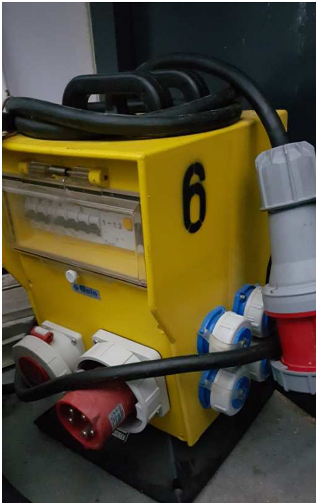
Załącznik nr 11 do OPZ Rozdzielnica przenośna z licznikiem
