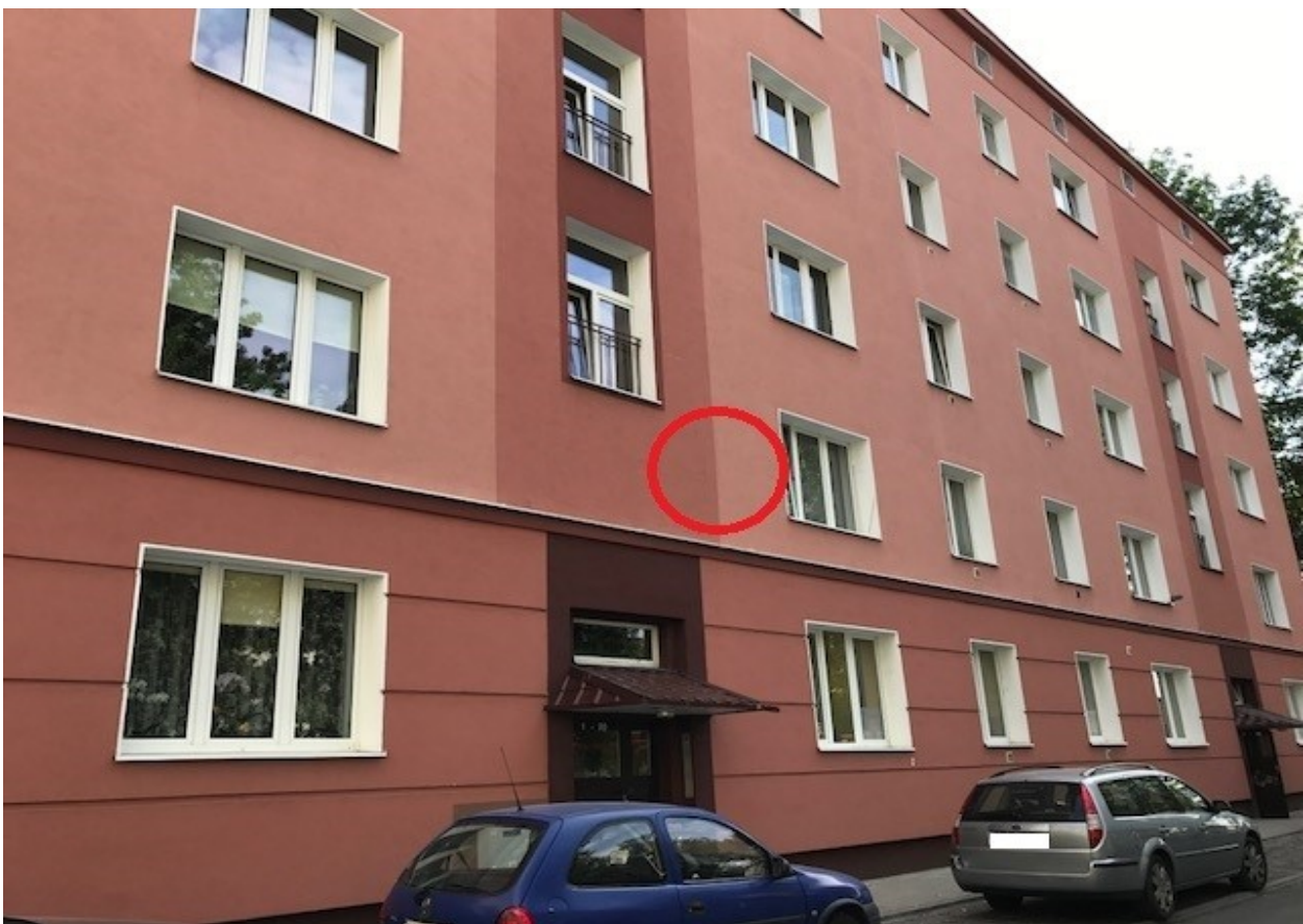
Ilustracja 10: Raławickie 22b - elewacja budynku
