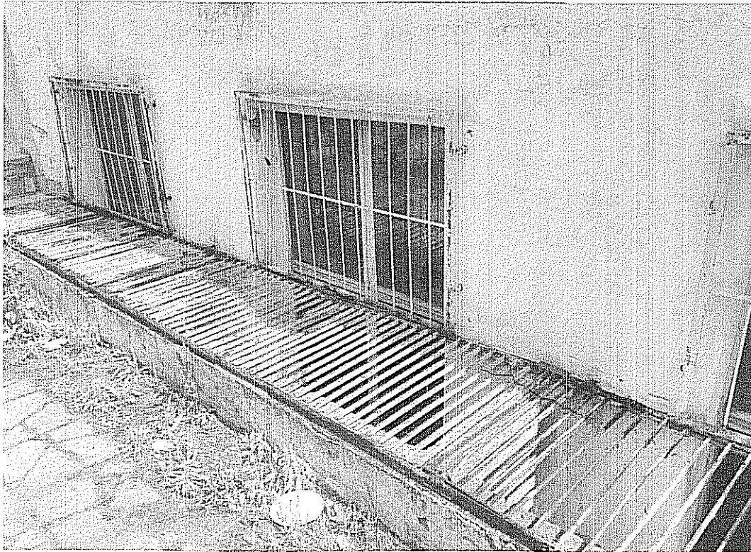
Studzienki okienne na elewacji południowo-zachodniej
