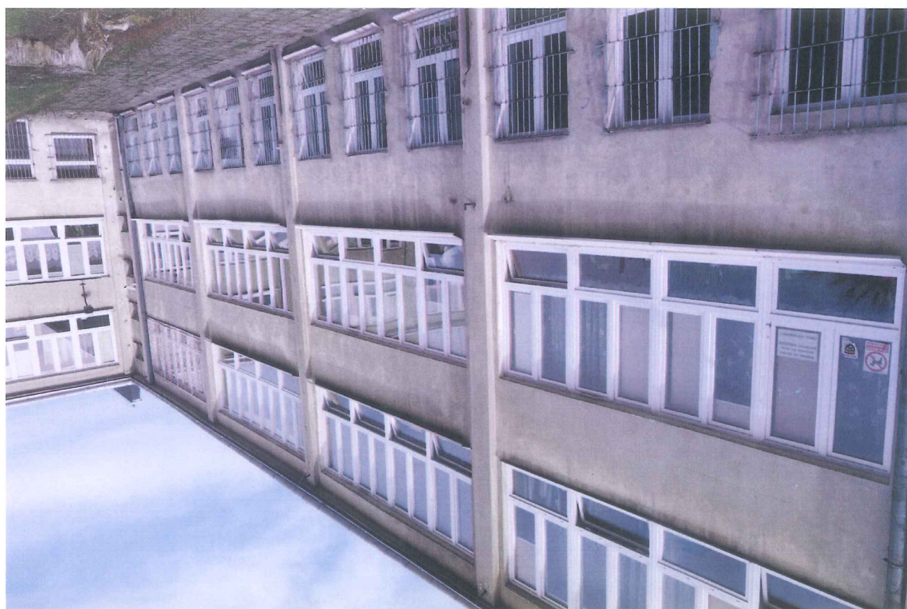
Fot. Widok od południa na południowo-wschodnią ścianę.
