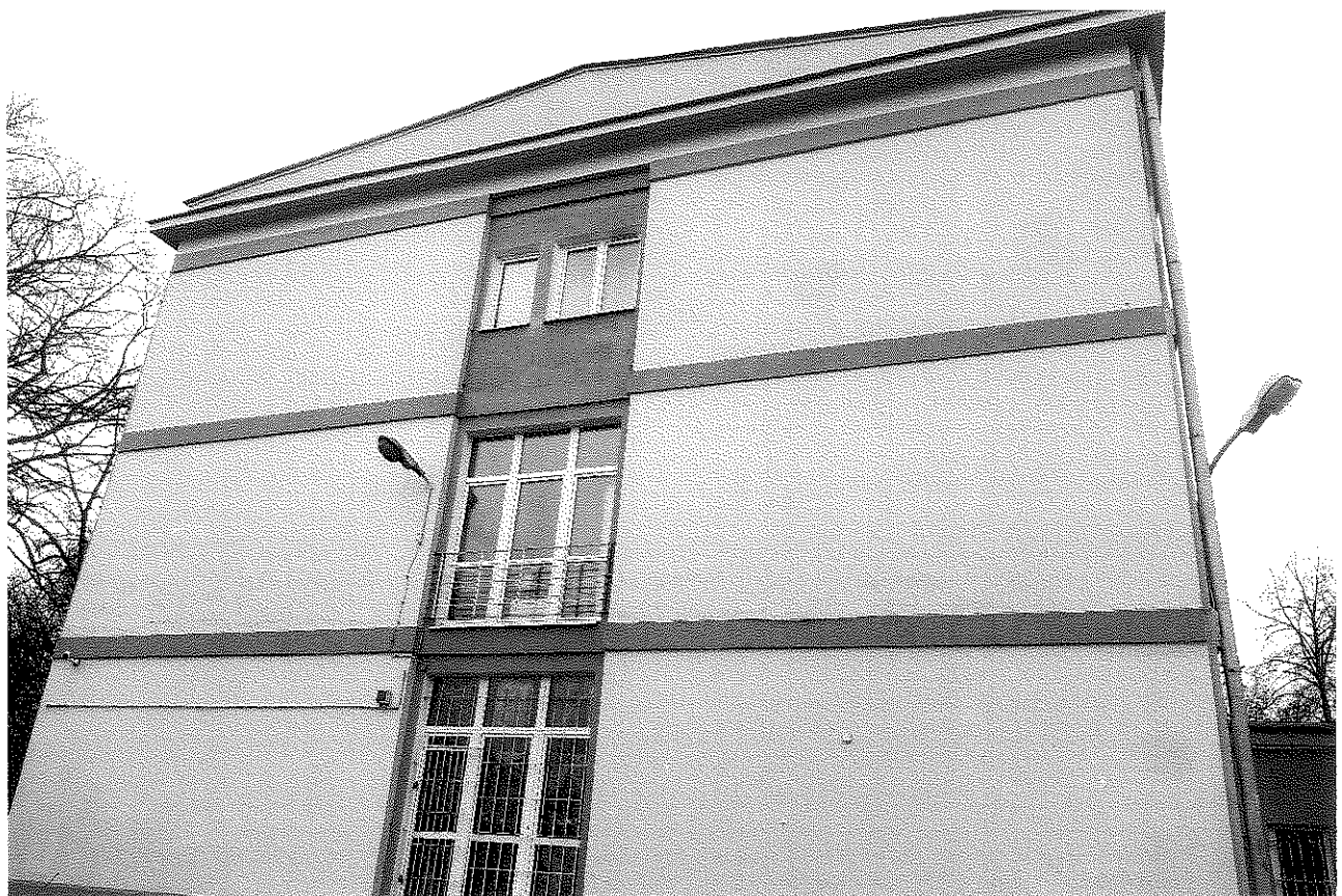
Fot. Północna strona budynku.
