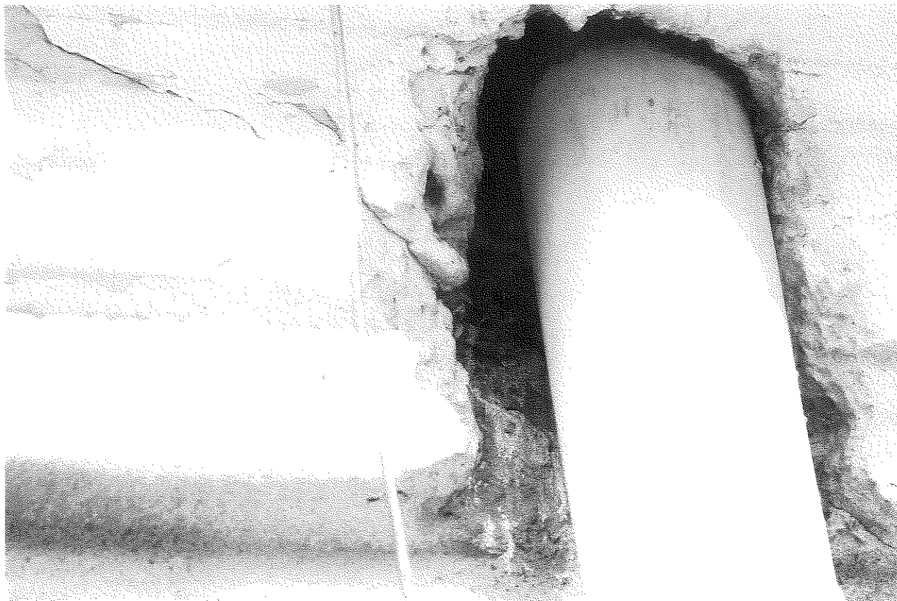
Fot. Gniazdo wróbla za rurą spustową.
