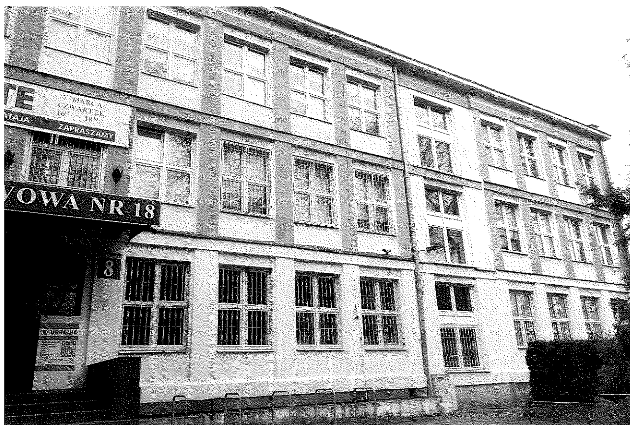
Fot. Część „główna” - wschodnia elewacja budynku.
