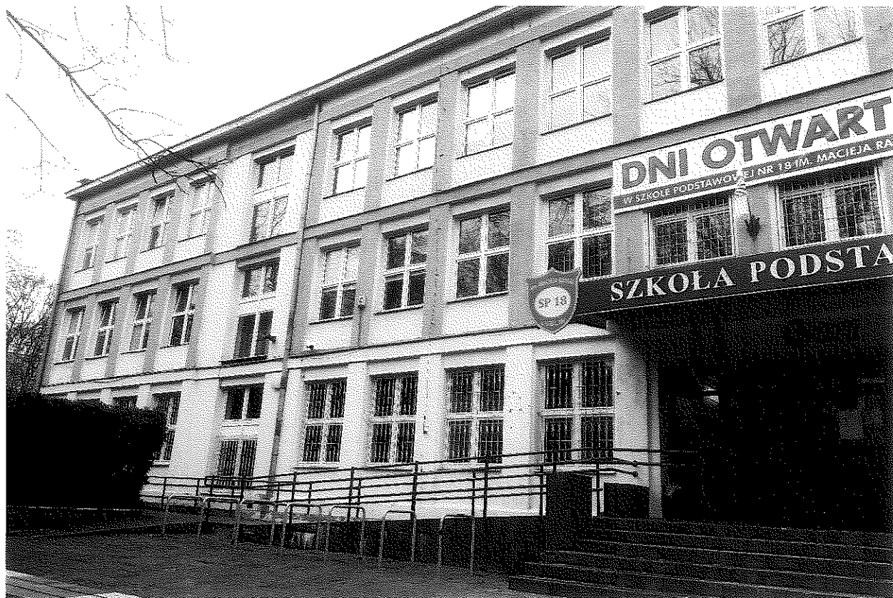
Fot. Część „główna” - wschodnia elewacja budynku.
