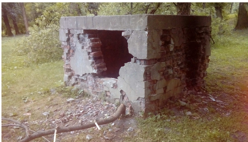
Rys.3. Obudowa studni przeznaczona do rozbiórki
