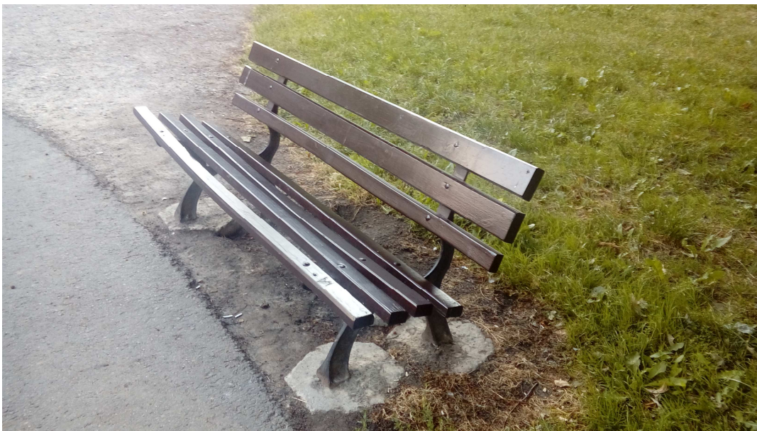
Rys.1. Ławka parkowa przeznaczona do rozbiórki
