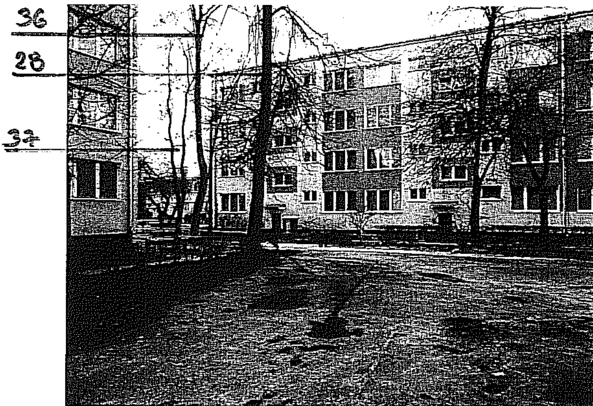
FOT. 8. WIDOK NA BLOK MOTOROWA 8, PO LEWEJ MOTOROWA 2
