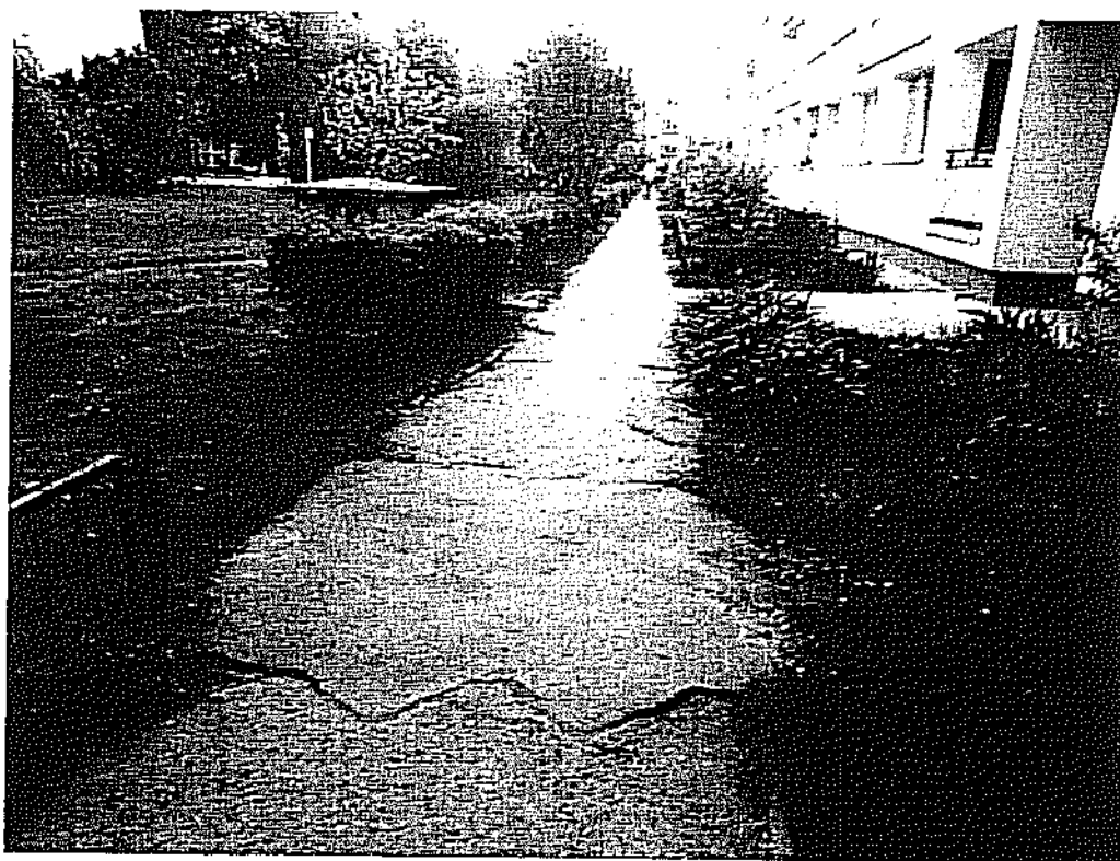
FOT. 6. WIDOK CIĄGU PIESZEGO WZDŁUŻ BLOKU MOTOROWA 6
