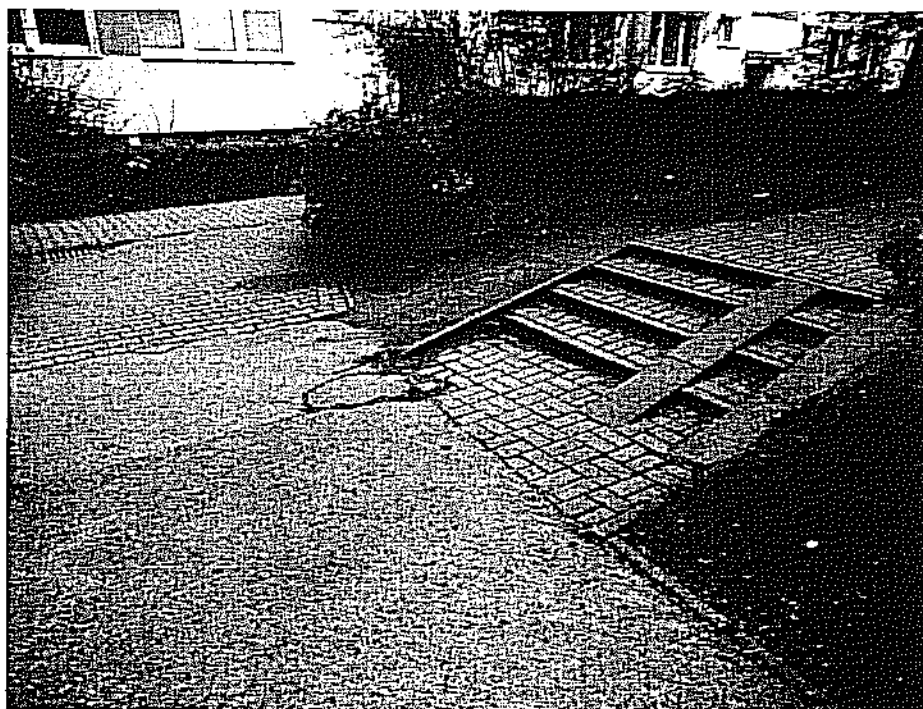
FOT. 12. SCHODY TERENOWE PRZY BLOKU MOTOROWA 2, PRZY MOTOROWA 8
