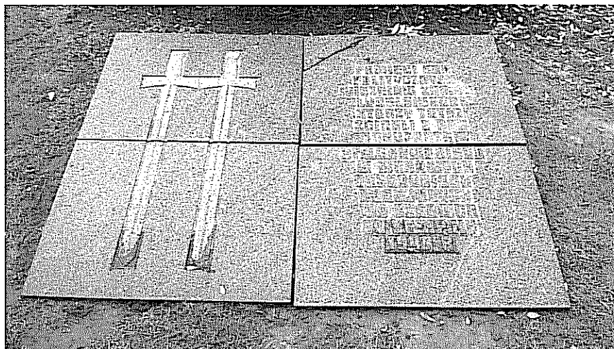
Fot.1.2 Tablica kamienna przeznaczona do usunięcia w ramach planowanego remontu.
