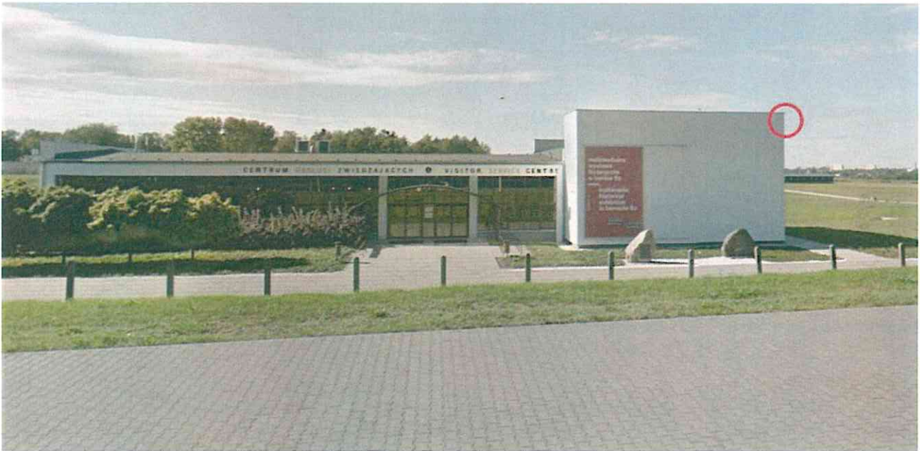
Rys. 9 Lokalizacja kamery, Lublin Droga Męczenników Majdanka 67
