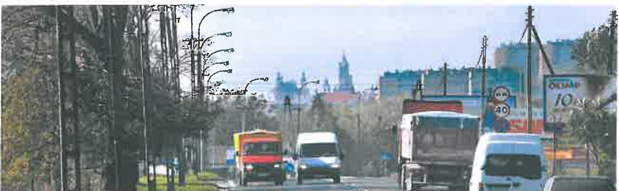
Ryc. 2.9. Widok osiowy z ulicy Turystycznej (DW-06)
