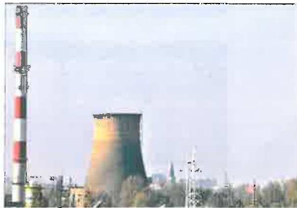
Ryc. 6.17. Infrastruktura przemysłowa – widok z ulicy Grygowej
