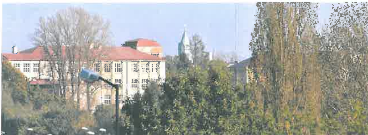
Ryc. 2.57. Widok z wiaduktu nad Aleją Solidarności (BW-40)
