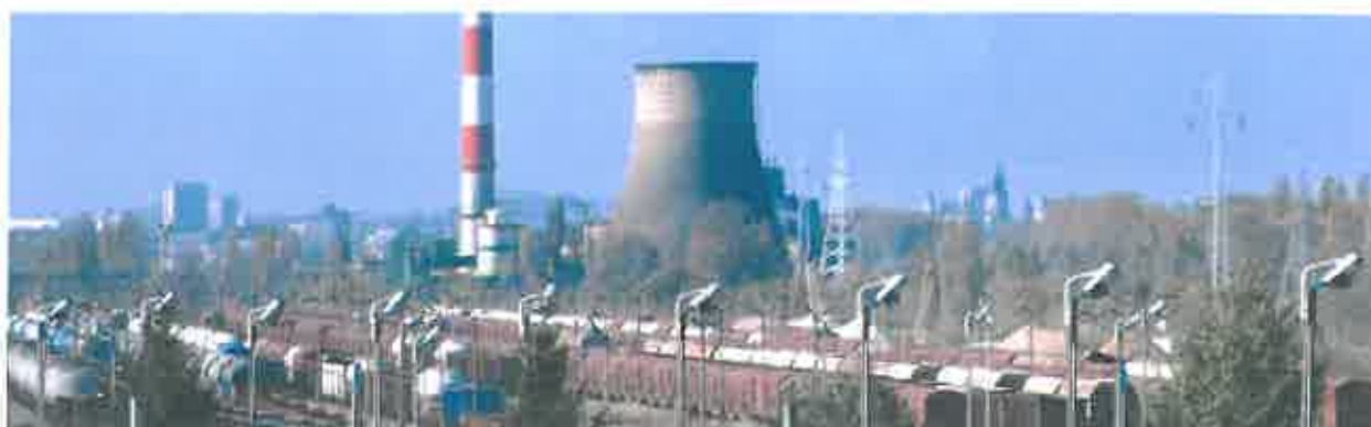
Ryc. 2.11. Widok z wiaduktu przy ulicy Grygowej (DW-08)
