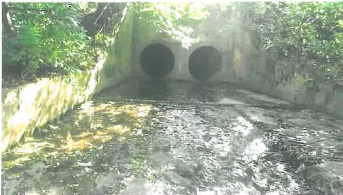
Widok od strony nurtu rzeki
