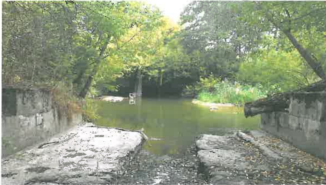
Widok od strony kanałów. W głębi podpora nieczynnego gazociągu.
