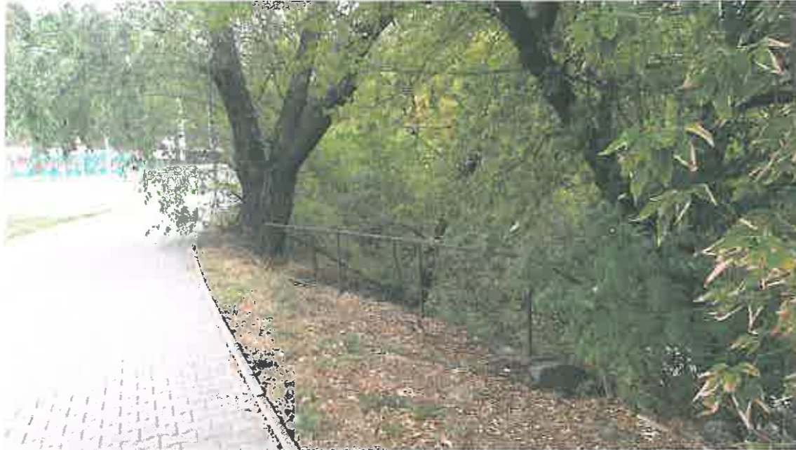
Bariierka z rur na ścianie czołowej wylotu – w pobliżu chodnik dla pieszych
