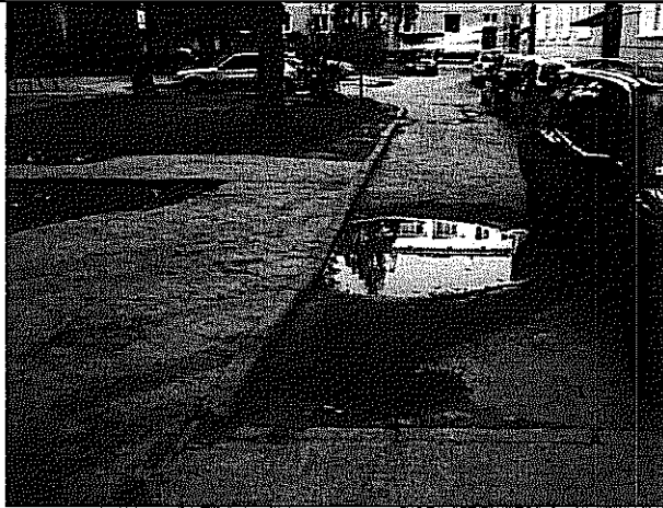
Fot. 19. Nierówności nawierzchni jezdni na odcinku C-D, w których gromadzi się woda opadowa. Koniec odcinka C-D
