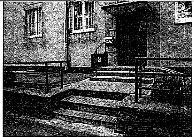
Fot. 8. Trzeci bieg schodowy - prowadzący do budynku nr 22
