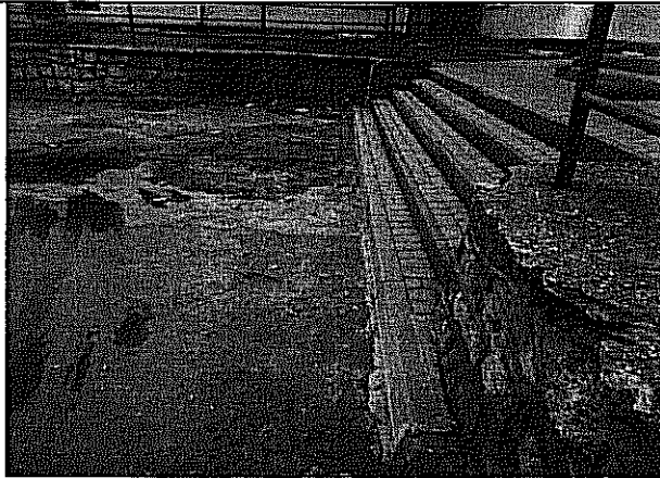
Fot. 7. Drugi bieg schodowy - prowadzący do budynku nr 22
