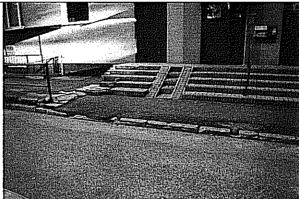
Fot. 11. Szósty bieg schodowy - prowadzący do budynku nr 22
