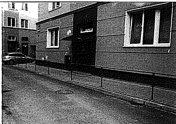
Fot. 16. Pierwsze wejście do budynku nr 22b
