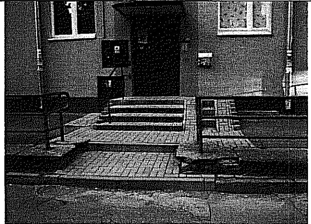
Fot. 10. Piąty bieg schodowy - prowadzący do budynku nr 22
