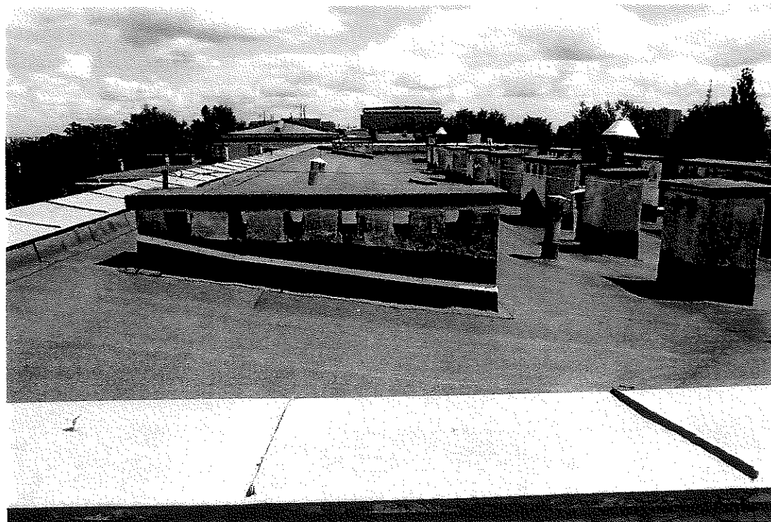
Fot. 2. Widok kominów wentylacyjnych na dachu szkoły
