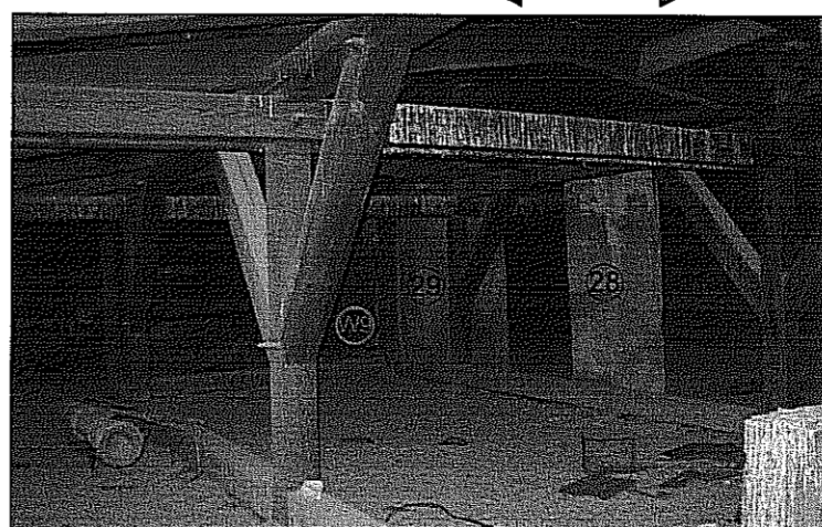
Oczyszczenie i zabezpieczenie konstrukcji dachu i deskowania pełnego przed działaniem ognia, grzybów domowych, grzybów pleśniowych oraz owadów – technicznych szkodników drewna.
