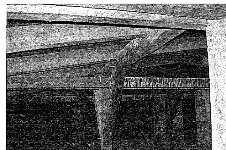
Oczyszczenie i zabezpieczenie konstrukcji dachu i deskowania pełnego przed działaniem ognia, grzybów domowych, grzybów pleśniowych oraz owadów – technicznych szkodników drewna.
