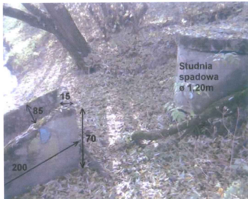
Teren wymaga podwyższenia do ok. 60cm (w tym umocnienie gabionami).
