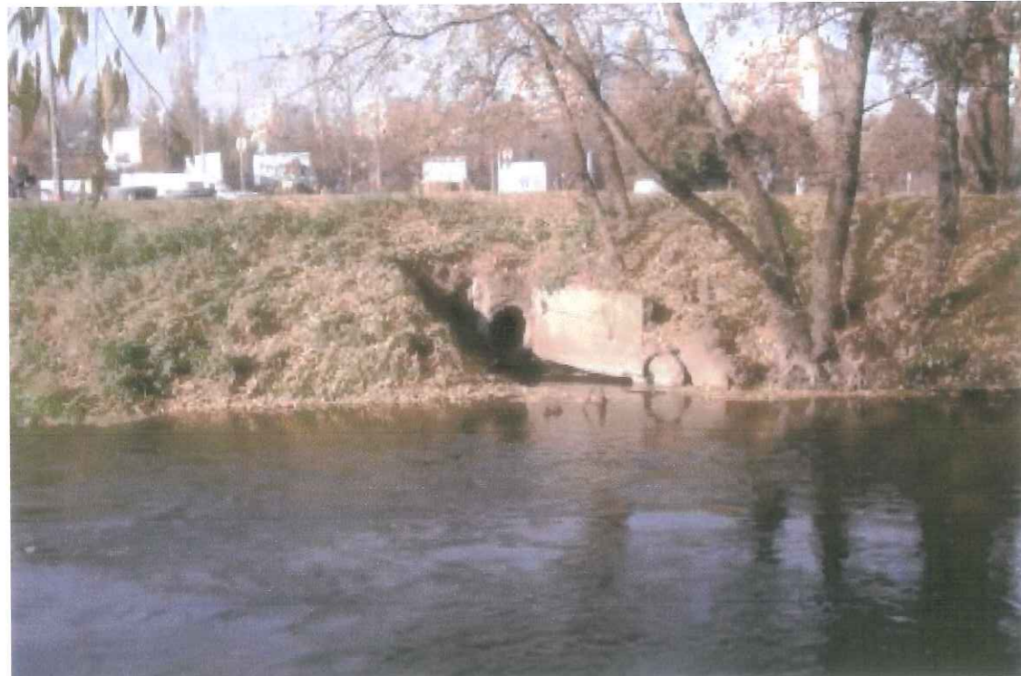
Widok ogólny wylotu.
