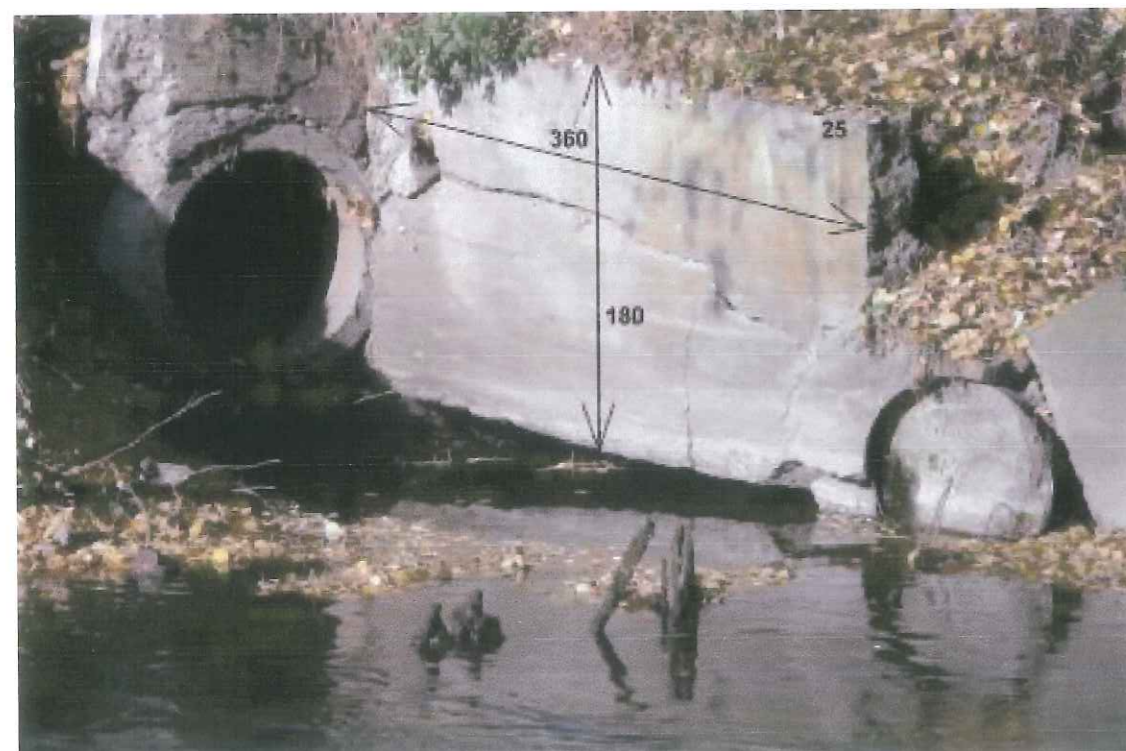
Stan techniczny i podstawowe wymiary ściany betonowej.
