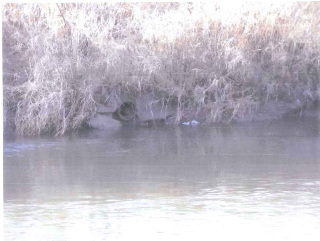
Widok ogólny wylotu.
