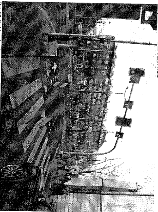
Rys. 23. Kraków. skrzyżowanie ul. Starowiśniej (na wprost) i Dietla (poprzecznej), widok w kierunku do Ryнку Głównego. Pas rowerowy po lewej stronie dwóch pasów ruchu ogólnego do prawoskrętu pozwala rowerzystom na przejazd skrzyżowania na wprost i skrócenie drogi. Lokalizacja przejazdu po lewej stronie pozwala osiągnąć dłuższe czasy zielonego światła dla rowerzystów niż w przypadku przejścia dla pieszych widocznego z prawej strony. Eliminuje również kolizje z prawoskrętem ogólnym. Zwraca uwagę zawieszony nad pasem rowerowym sygnalizator S-1 ze znakiem F-11. Fot. Marcin Hyla
