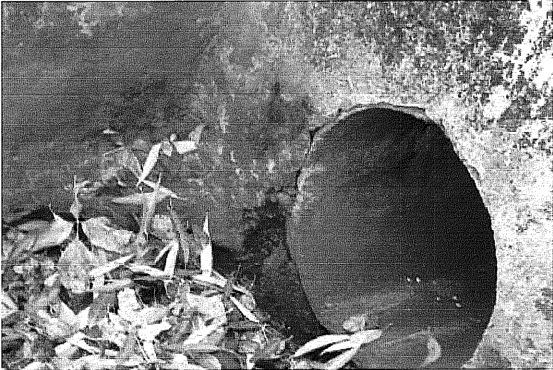
Połączenie rury DN 400 ze ścianką wylotu.
