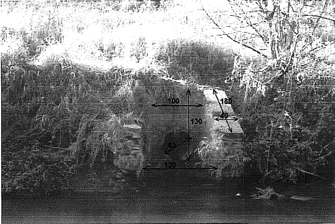
Podstawowe wymiary wylotu.
