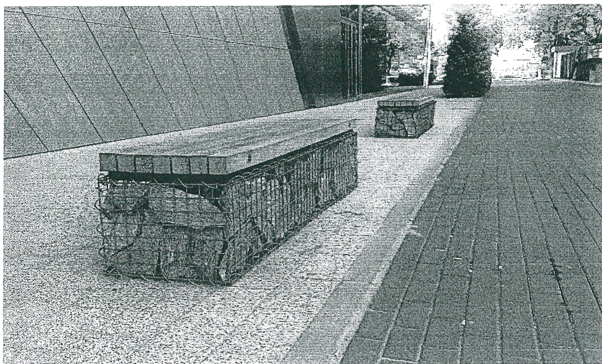
PRZYKŁADOWE ROZWIĄZANIE ŁAWEK NA GABIONACH
