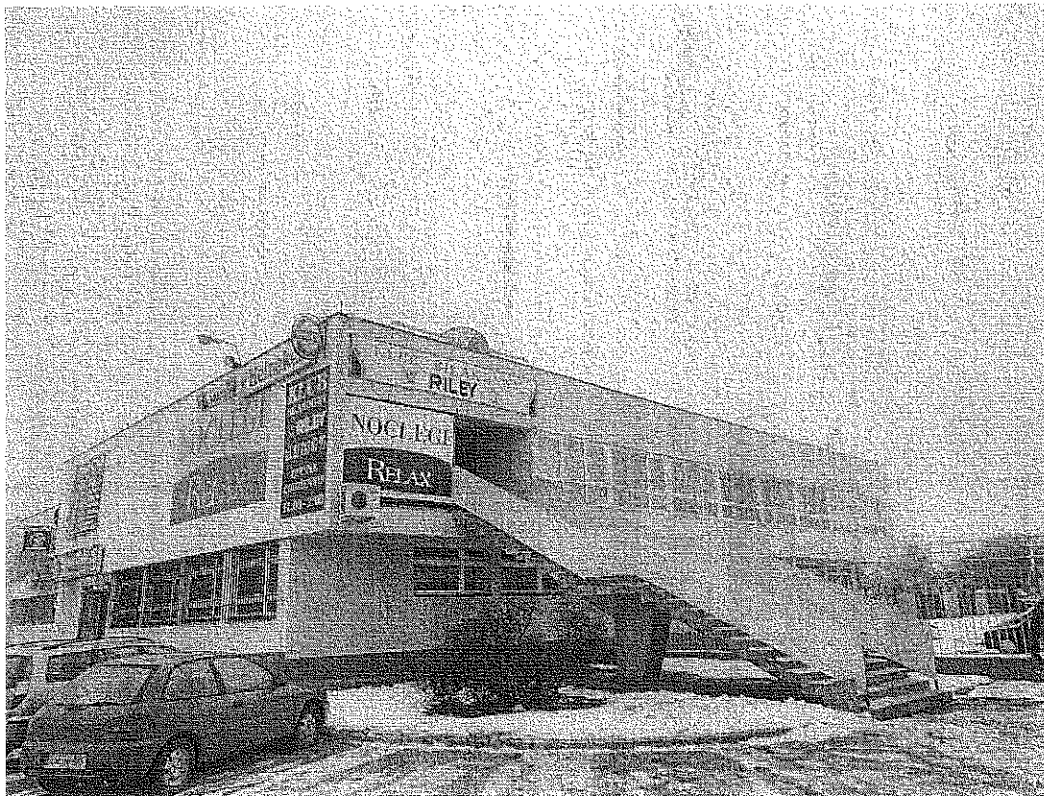
Budynek usługowo-hotelowy: Widok elewacji bocznej - schody wejściowe do hotelu
