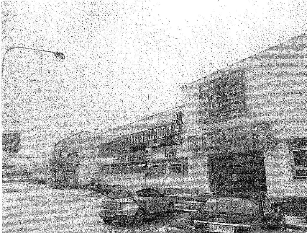
Budynek usługowo-hotelowy: Widok elewacji frontowej
