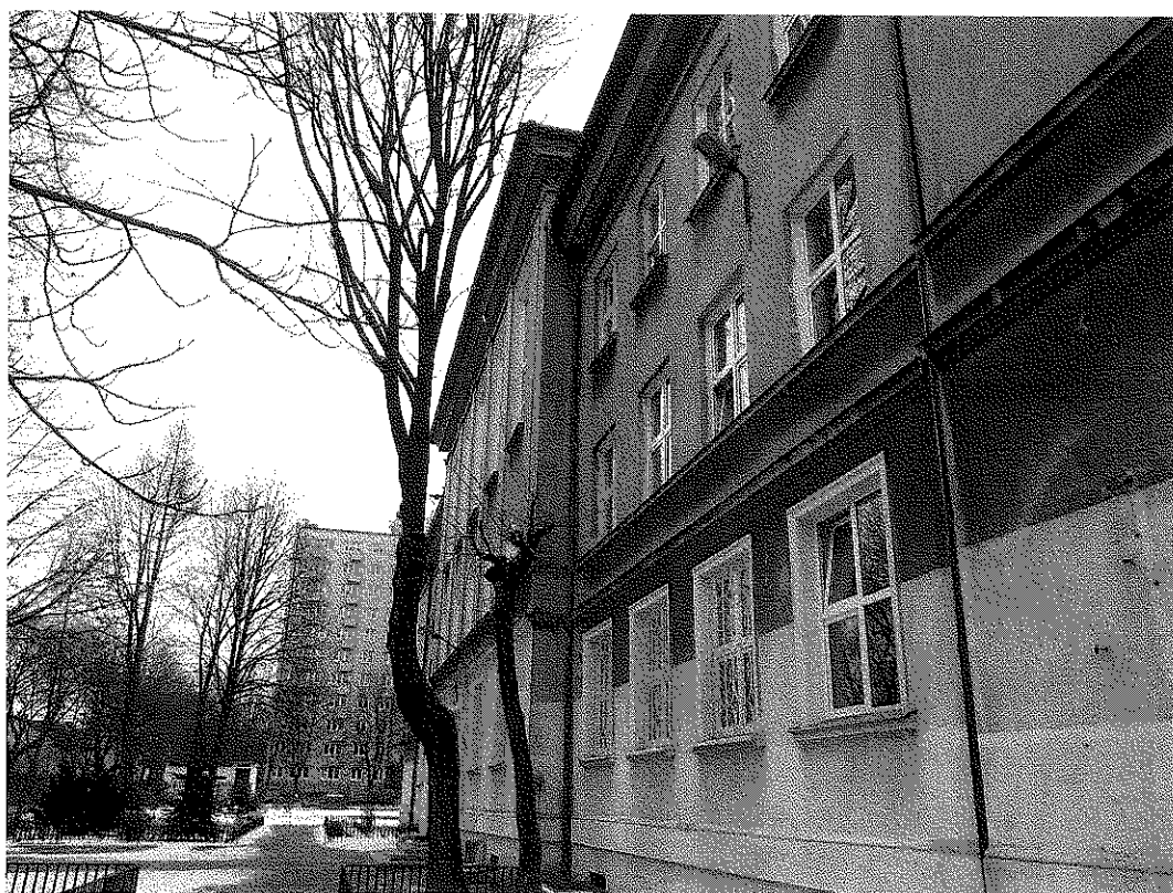
Fot. 1. Widok północnej części elewacji zewnętrznej Gimnazjum nr 15
