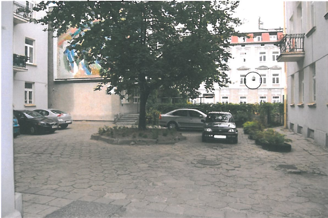
Ryc.1. Miejsca instalacji kamery obrotowej (okrąg czarny) na elewacji budynku.
