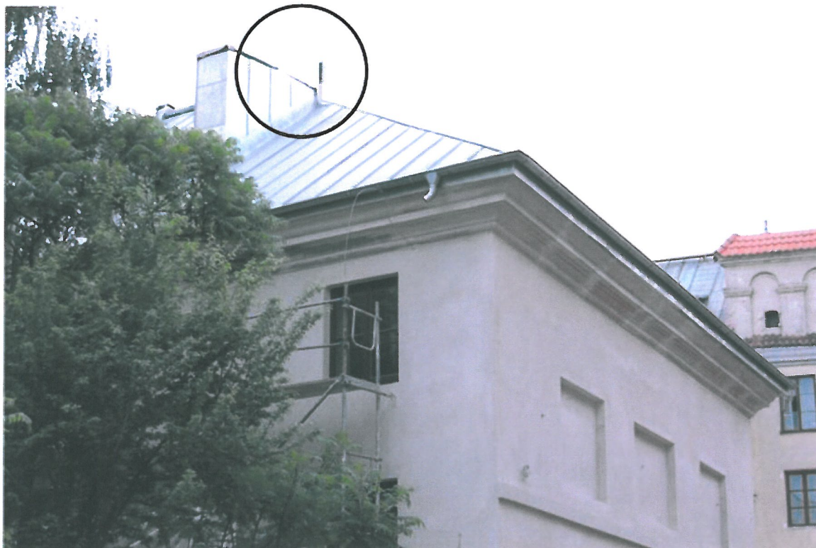
Miejsce instalacji urządzenia na dachu budynku przy ul. Jezuickiej 18 oznaczono czarnym okręgiem.
