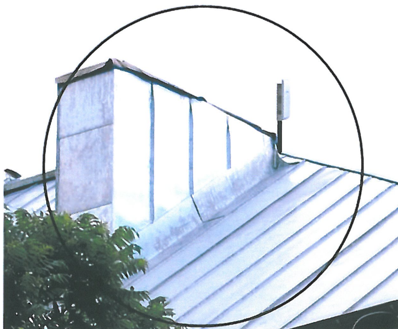
Wizualizacja instalowanego urządzenia Ubiquiti NanoStation M5. Wymiary urządzenia 294x80x30mm
