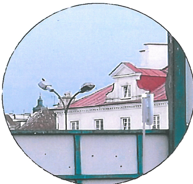
Wizualizacja instalowanego urządzenia Ubiquiti NanoStation M5. Wymiary urządzenia 294x80x30mm.
