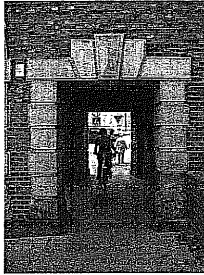
Fot. 2.53. Widok ściany przyczółka. Niejednolita faktura, obkruszenia cegieł, zanieczyszczenie muru konstrukcji.
