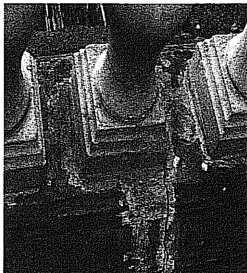
Zdj. 1.5. Uszkodzenia i odspojenia elementów kamiennych okładzin
