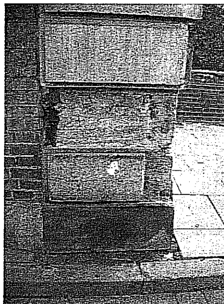
Fot. 2.57. Korozja płyt kamiennych filarze, obkruszenia cegieł, zanieczyszczenie muru. Fot. 2.58. Brak płyty oraz ubytki płytach i zniszczenie płyty kamiennej na słupie od Podwale.
