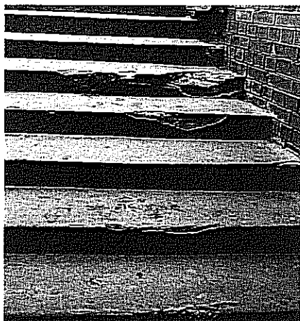
Zdj. 1.2., Zdj. 1.3. Ubytki i uszkodzenia elementów stopni schodów
