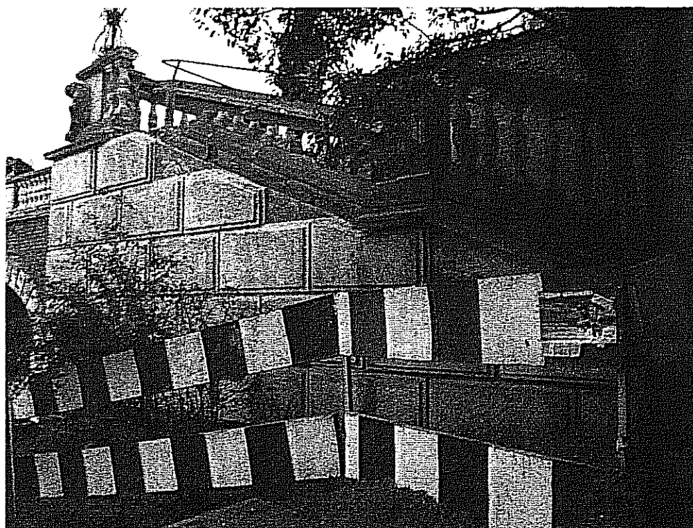
Fot. 2.65. Braki płyt licowych z kamienia, częściowe całkowite zniszczenie i degradacja balustrady. Odrywanie się płyt licowych wraz z betonową płytą, z którą są przytwierdzone do muru z cegły.
