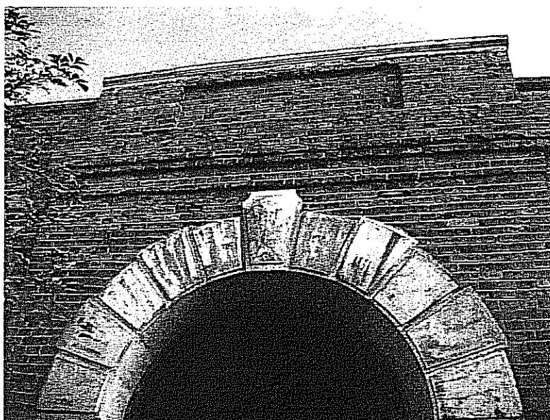
Fot. 2.47. Widok ściany czołowej i sklepienia od strony Placu Zamkowego. Ubytki cegieł, korozja biologiczna kamiennych płyt i cegieł.
