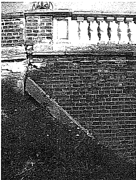
Fot. 2.61. Widok skrzydła po stronie Placu Zamkowego. Ubytki w murze, obkruszenia cegieł, odspajanie skrzydła od muru, osiadanie nasypu powodujące powstawanie kawerny pod skrzydłem.
