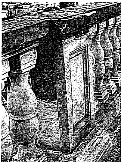
Zdj. 1.5. Uszkodzenia i odspojenia elementów kamiennych okładzin
