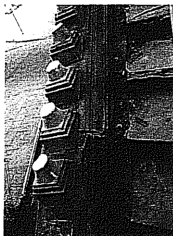
Zdj. 1.3. Odchylenie balustrady na skutek obsunięcia się nasypu
