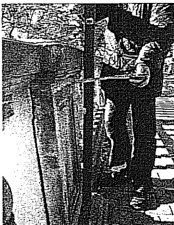
Fot. 2.26. Wychylenie słupka na zewnątrz o 5,7/67 cm Fot. 2.27. Wychylenie elementów na zewnątrz o 4,6/67 cm, zniszczenie dolnej powierzchni spocznika, pęknięcie płyty balustrady
