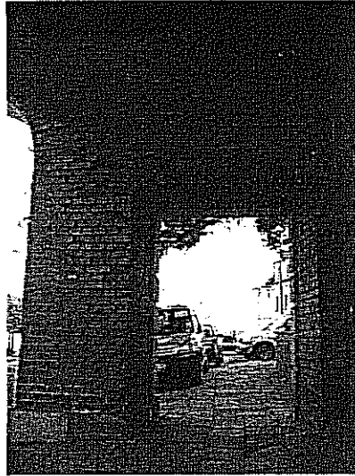
Fot. 2.55. Korozja i brak płyt kamiennych nad przejściem dla pieszych, po stronie Placu Zamkowego.
