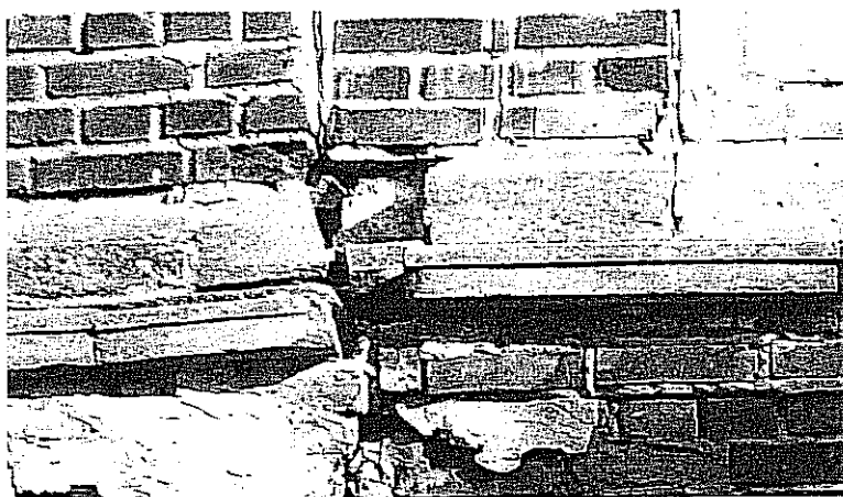
Fot. 2.16. Uszkodzenia gzymsów na stykach oraz przesuwanie ich względem siebie z powodu osiadania muru.
