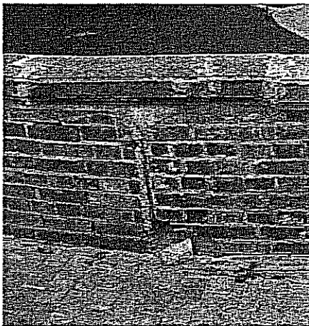
Fot. 2.37. Pęknięcie muru w poziomie w miejscu styku ze skrzydłem przenoszące się ze styku pionowego Fot. 2.38. Ubytki w licach cegieł
