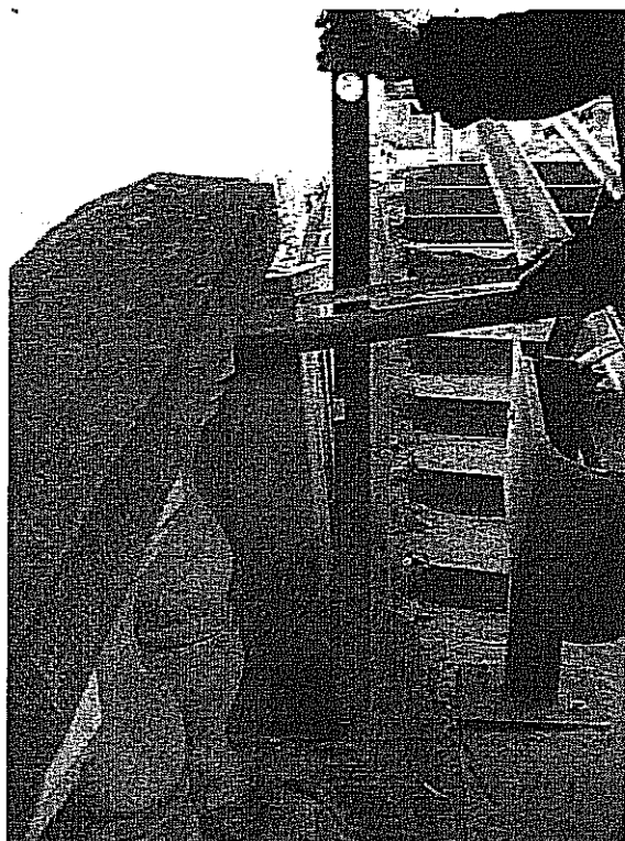
Fot. 2.66. Odchylenie balustrady schodów od pionu o 5cm/70cm!
