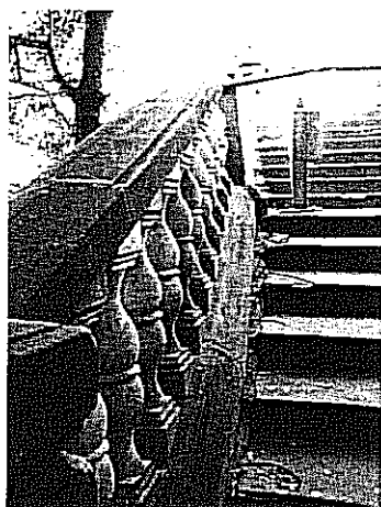
Zdj. 1.3. Odchylenie balustrady na skutek obsunięcia się nasypu
