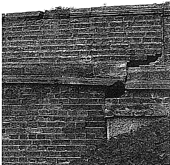
Fot. 2.49. Skrzydło. Ubytki cegieł, korozja biologiczna i zniszczenia mechaniczne elementów murku, osiadanie muru mogące mieć wpływ na odrywanie skrzydła.
