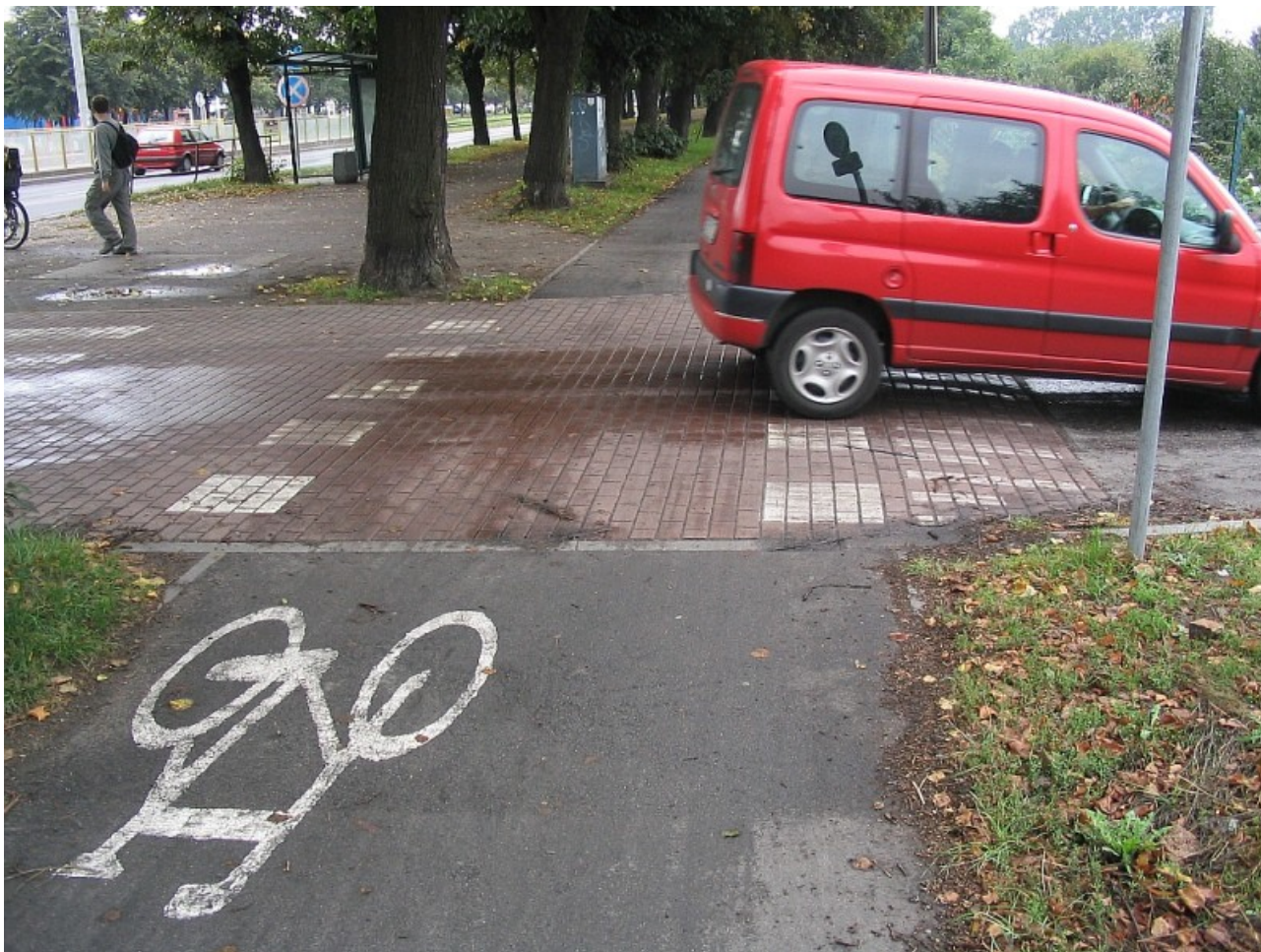
Rys. 13. Droga rowerowa w al. gen. Hallera, Gdańsk. Płytkowy próg zwalniający z przejazdem rowerowym podkreśla pierwszeństwo rowerzysty w tym miejscu. Fot. Marcin Hyła.
