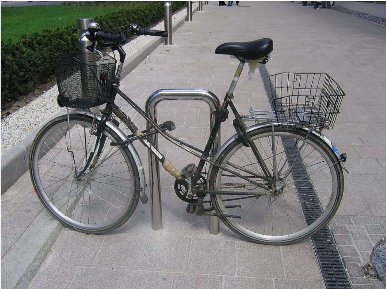
Rys. 6. Przykładowe rozwiązanie poprawnego stojaka rowerowego: forma "odwróconego U" pozwala na bezpieczne i wygodne spięcie ramy roweru, przedniego koła i stojaka kłódką rowerową typu U-lock. Zwraca uwagę odpowiednia odległość stojaka od krawężnika i łatwy dostęp. Stojak jest dwustronny, mogą być do niego przypięte niezależnie dwa rowery. Fot. Marcin Hyła.
