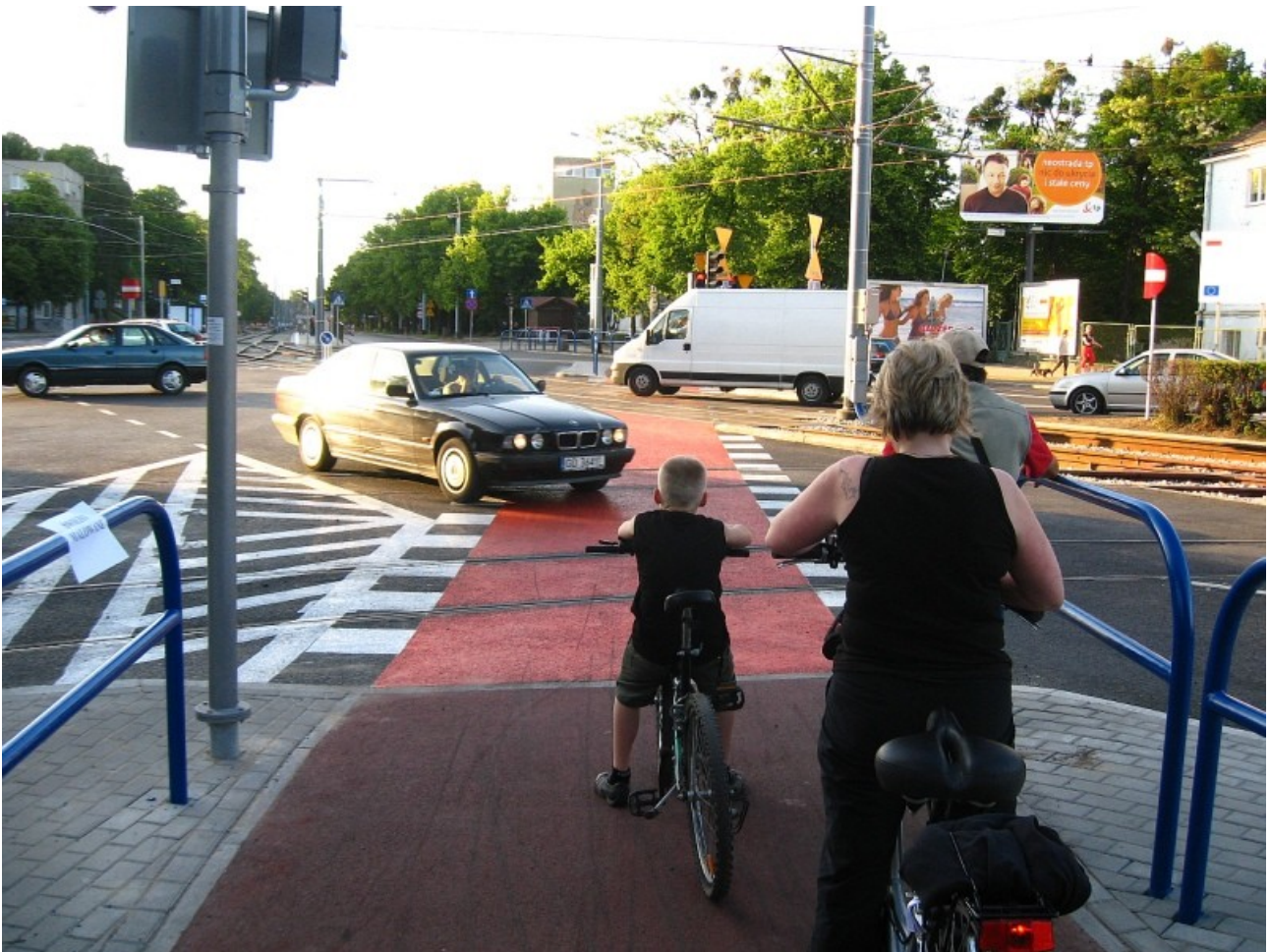
Rys. 14. Gdańsk, al. gen. Hallera, przejazd rowerowy przez skrzyżowanie (Węzeł Kliniczna). Zwraca uwagę szeroki przekrój przejazdu rowerowego, czerwona nawierzchnia oraz duży obszar akumulacji przed przejazdem, pozwalający bezpiecznie oczekiwać na zielone światło większej grupie rowerzystów. Bariereki z boków segregują ruch pieszy i rowerowy i pozwalają oprzeć się rowerzystom. To ostatnie jest istotne w przypadku części użytkowników, korzystających z tzw. SPD zamiast klasycznych pedałów lub z tzw. nosków w pedałach roweru. Fot. Marcin Hyła.
