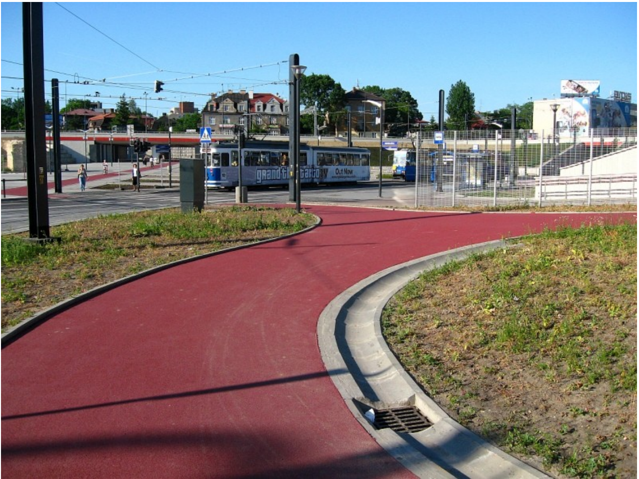
Rys. 21. Kraków, rondo Mogiła. Droga rowowa o nawierzchni bitumicznej, pokryta czerwoną emulsją. Zwracają uwagę szerokie przekroje i duże promienie łuków poziomych. W tym miejscu przecinają się główne trasy rowerowe miasta. Fot. Marcin Hyla
