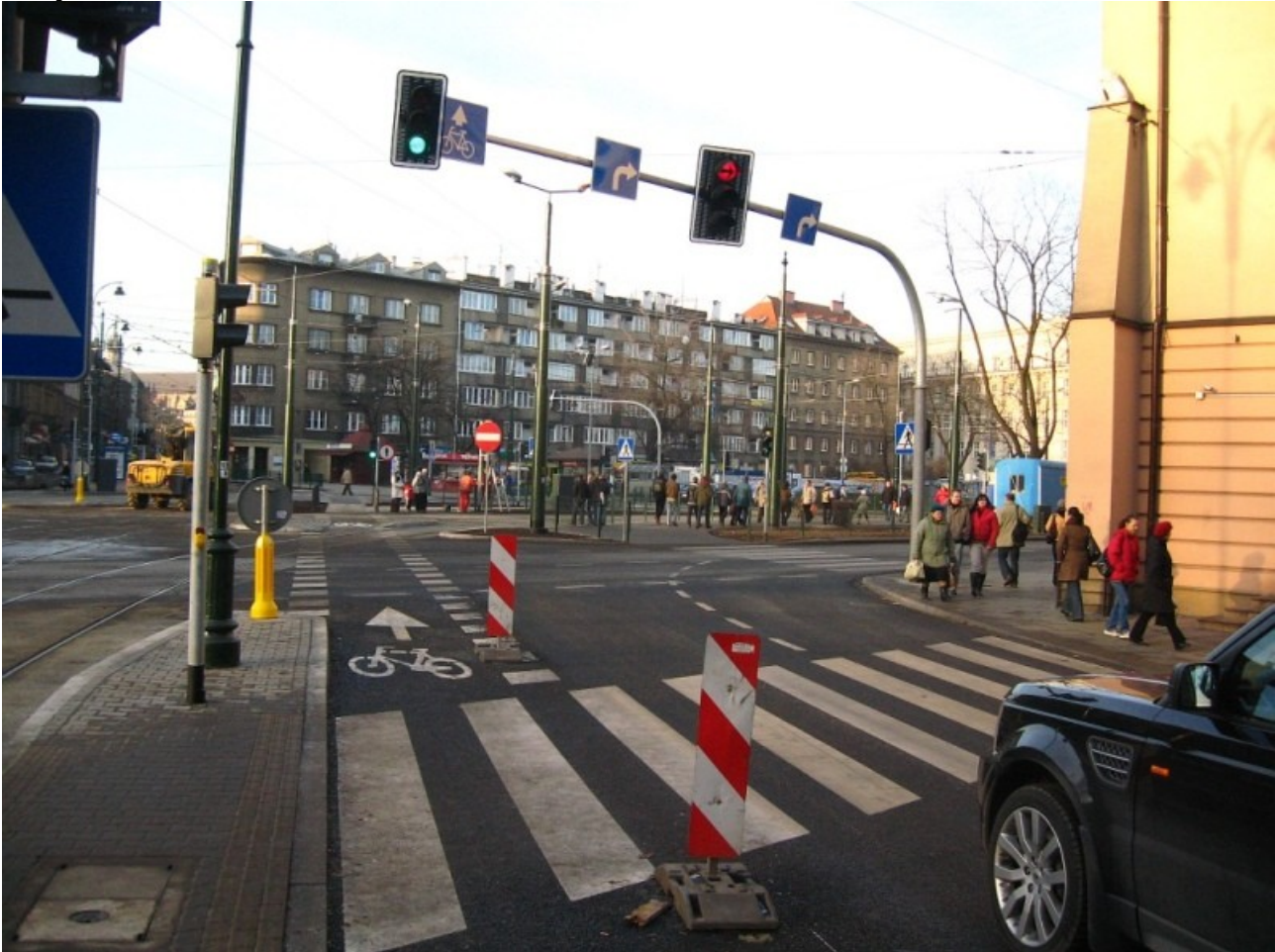
Rys. 23. Kraków: skrzyżowanie ul. Starowiślnej (na wprost) i Dietla (poprzeczna), widok w kierunku do Rynku Głównego. Pas rowerowy po lewej stronie dwóch pasów ruchu ogólnego do prawoskrętu pozwala rowerzystom na przejazd skrzyżowania na wprost i skrócenie drogi. Lokalizacja przejazdu po lewej stronie pozwala osiągnąć dłuższe czasy zielonego światła dla rowerzystów niż w przypadku przejścia dla pieszych widocznego z prawej strony. Eliminuje również kolizję z prawoskrętem ogólnym. Zwraca uwagę zawieszony nad pasem rowerowym sygnalizator S-1 ze znakiem F-11. Fot. Marcin Hyła
