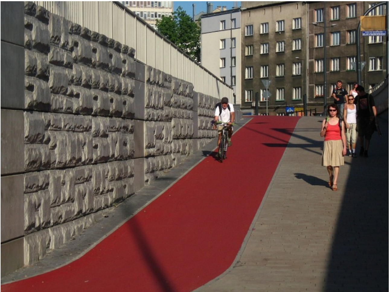
Rys. 22. Kraków, Rondo Mogiłskie. Czytelne zróżnicowanie nawierzchni (czerwony asfalt dla rowerzystów, bruk dla pieszych) oraz odpowiednie położenie wzajemne dróg rowerowych i chodników minimalizuje kolizje rowerzystów z pieszymi. Zwraca uwagę skrajnia drogi rowerowej, odsuniętej od lica ściany ok. 0,5 m (nie udało się tego dochować we wszystkich miejscach Ronda Mogiłskiego). Fot. Marcin Hyła.
