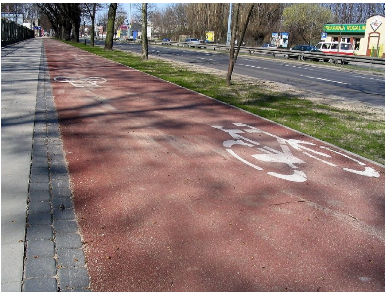
Rys. 11. Gdańsk, ul. Grunwaldzka. Widoczne obniżenie bitumicznej nawierzchni drogi rowerowej w stosunku do chodnika z płyt betonowych. Rozwiązanie jest czytelne dla wszystkich użytkowników, w tym niepełnosprawnych. Nawierzchnia drogi rowerowej z barwionego czerwonym pigmentem mastyksu grysowego (SMA). Fot. Marcin Hyla
