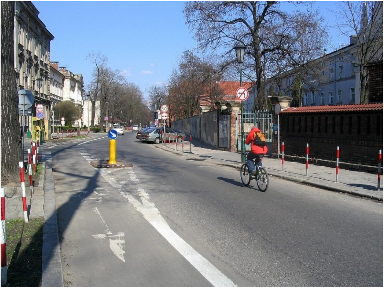
Rys. 18. Kraków, kontrapas w ul. Kopernika. Kontrapas jest jednokierunkowy. Rowerzyści poruszający się zgodnie z ogólną organizacją ruchu nie korzystają z kontrapasa, tylko stosują się do oznakowania pionowego. Widoczny znak C-9 na słupku przeszkodowym U-5b, dla tego kierunku stosuje się też znaki D-3 z tabliczką T-22 oraz znak F-19. Fot. Marcin Hyła.
