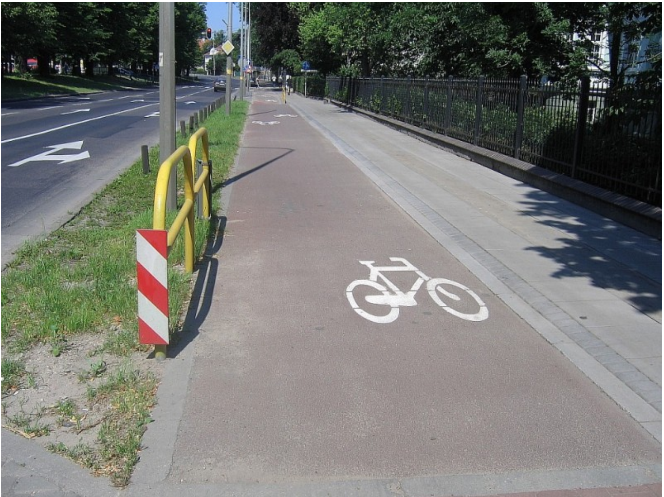
Rys. 12. Gdańsk, ul. Grunwaldzka: nawierzchnia bitumiczna drogi rowerowej (SMA), chodnik z płyt betonowych. Ze względu na ograniczoną skrajnię zastosowano tabliczkę U-6c. Fot. Marcin Hyla
