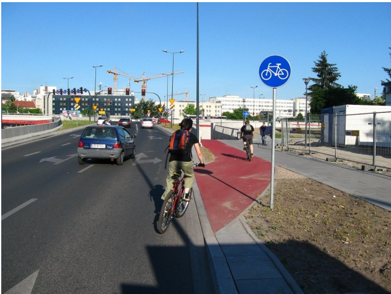
Rys. 19. Kraków, rondo Mogiłskie. Jadący ul. Lubicz w jezdni na zasadach ogólnych rowerzyści mogą z dużą prędkością (nawet 40 km/godz) wjechać na drogę rowerową w dolnym poziomie ronda. Wjazd z prawej strony jezdni jest bezkolizyjny i naturalny. Uskok podłużny między jezdnią a czerwoną nawierzchnią drogi rowerowej ma mniej niż 1 cm wysokości. Fot. Marcin Hyła.
