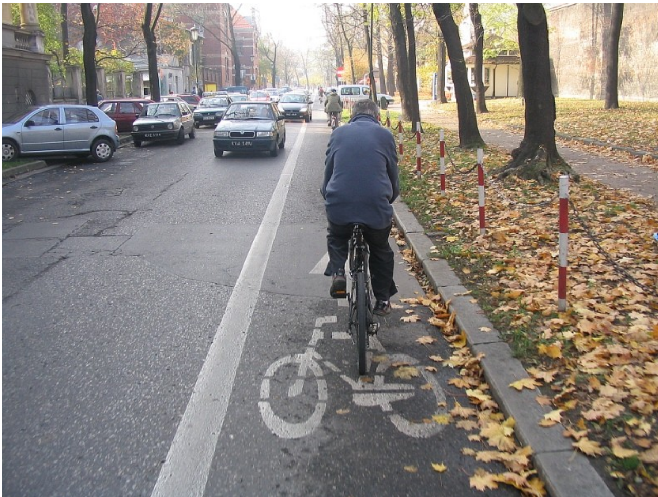
Rys. 15. Kraków, kontrapas w ul. Kopernika: rowerzyści mogą legalnie jechać pod prąd. Bezpieczeństwo zapewnia doskonała i niczym nie zakłócona wzajemna widoczność kierujących. Fot. Marcin Hyla.
