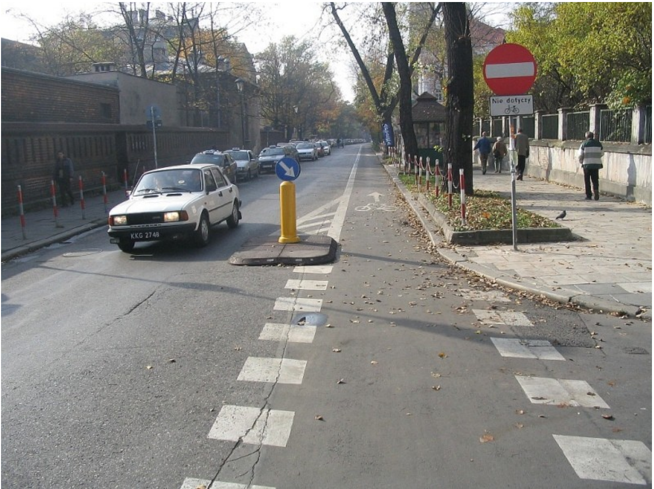
Rys. 16. Kraków, kontrapas w ul. Kopernika. W punktach potencjalnej kolizji samochód - rowerzysta kierunki są rozdzielone fizycznie przy pomocy wysp dzielących ze słupkiem U-5b. W tym miejscu skręcające w prawo samochody mogą mieć tendencję do zajeżdżania drogi rowerzyście jadącemu po kontrapasie. Widoczne oznakowanie pionowe B-2 z tabliczką T-22. Fot. Marcin Hyła.
