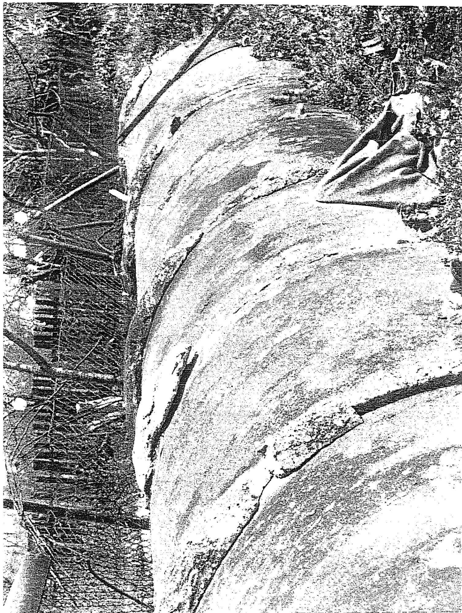
BETONOWE OPASKI NA POŁĄCZENIACH RUR BETONOWYCH
