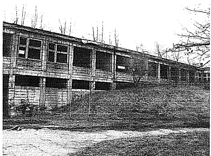
Elewacja zachodnia - widok z dziedzińca
