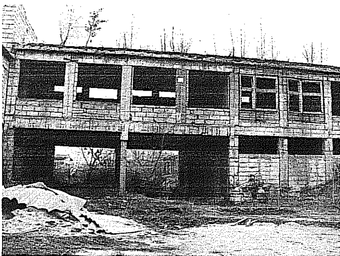
Elewacja zachodnia - widok z dziedzińca
