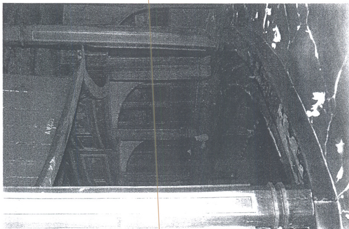
Fot. Nr 14 Teatr Stary w Lublinie, ul. Jezuicka18, drewniane loże, stan zachowania przed rozpoczęciem prac rozbiórkowych. II kondygnacja -balkony, widok od zaplecza.
