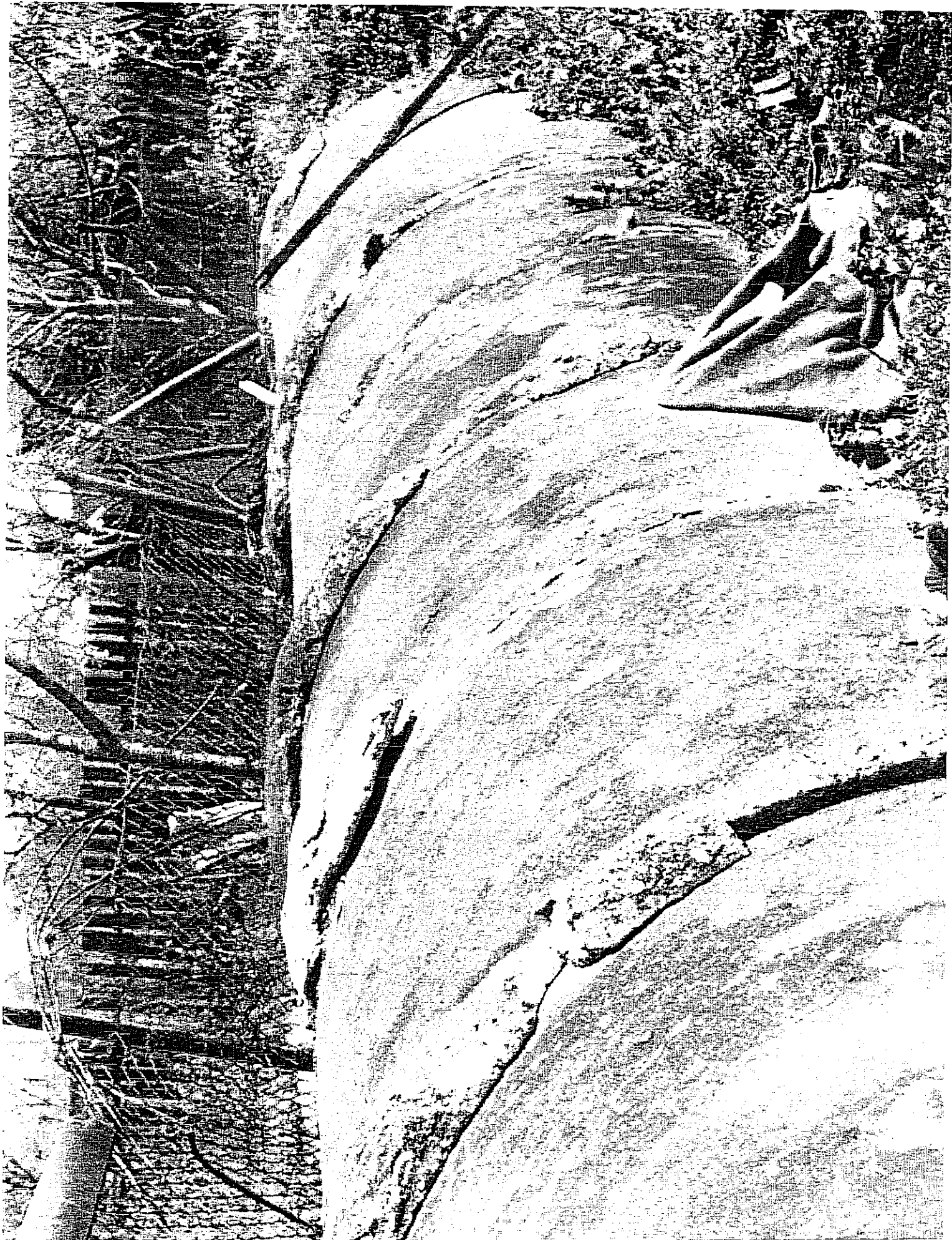
BETONOWE OPASKI NA POŁĄCZENIACH RUR BETONOWYCH
