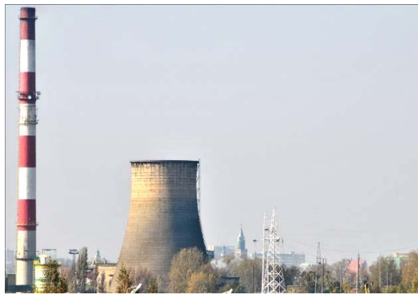
Ryc. 6.17. Infrastruktura przemysłowa – widok z ulicy Grygowej
