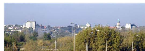
DW-14 – Widok z wiaduktu kolejowego nad ulicą Diamentową
