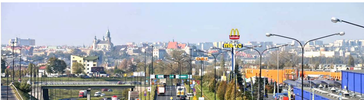
Ryc. 2.13. Widok osiowy z wiaduktu nad Aleją Wincentego Witosa (DW-10)
