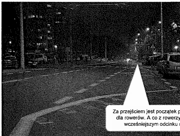
Zdj. 1. Zanikający prawy pas ruchu kończy się wątpliwą powierzchnią wyłączoną z ruchu z zatartym oznakowaniem poziomym - w zamyśle miała ona pewnie „zabezpieczać” zjazd na parking i wyjazd z niego. Tuż za przejściem ma swój początek pas ruchu dla rowerów, którego wcześniej brak – na najbardziej niebezpiecznym odcinku ulicy Wileńskiej (m.in. w rejonie targowiska). Jednostronne oświetlenie uliczne.
