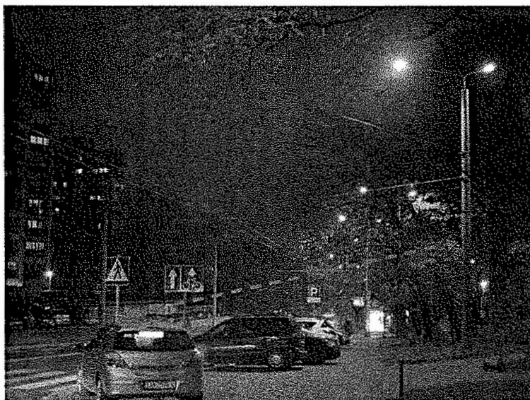
Zdj. 2. Latarnia jednostronnego oświetlenia ulicznego w znacznym oddaleniu od przejścia, w dodatku zlokalizowana z tyłu przejścia. W konsekwencji pieszy na przejściu jest słabo widoczny.
