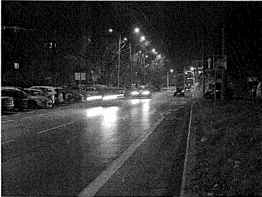
Zdj.5. Na tym zdjęciu jednoznacznie widać różnicę w oświetleniu obu stron dojścia do przejścia i samego przejścia.
