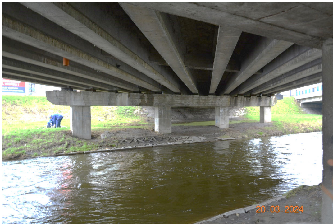
Fot. 17. Ustrój od spodu i przestrzeń podmostowa w kierunku P3
