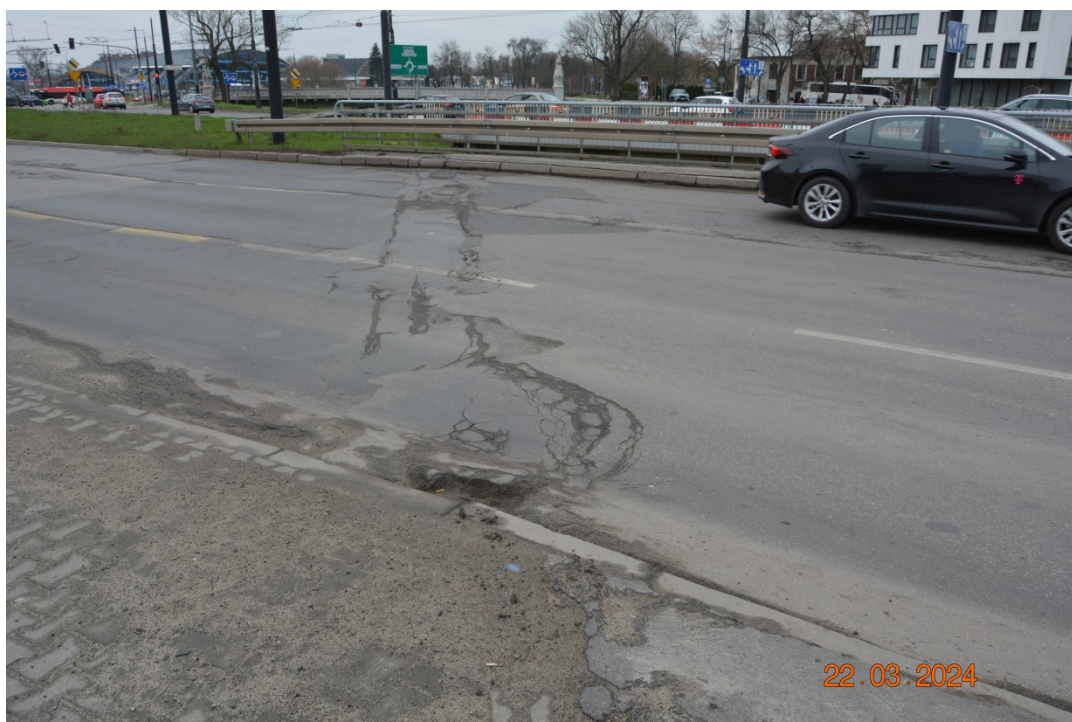
Fot. 12. Obszar dylatacyjny nad P4
