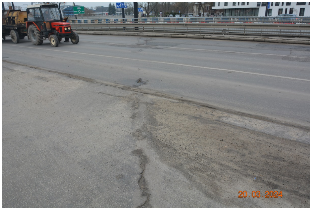
Fot. 11. Obszar dylatacyjny nad P3
