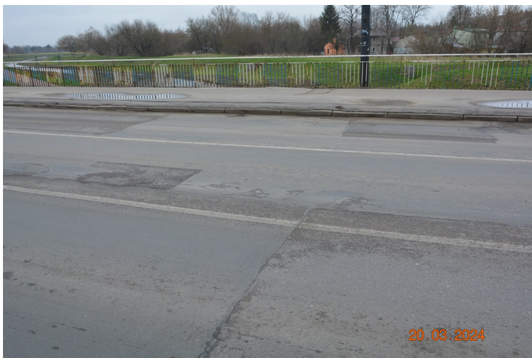
Fot. 10. Obszar dylatacyjny nad P2
