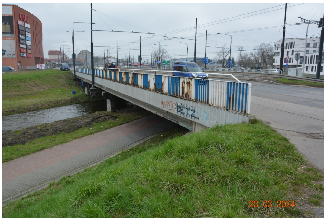
Fot. 2. Widok od strony DW
