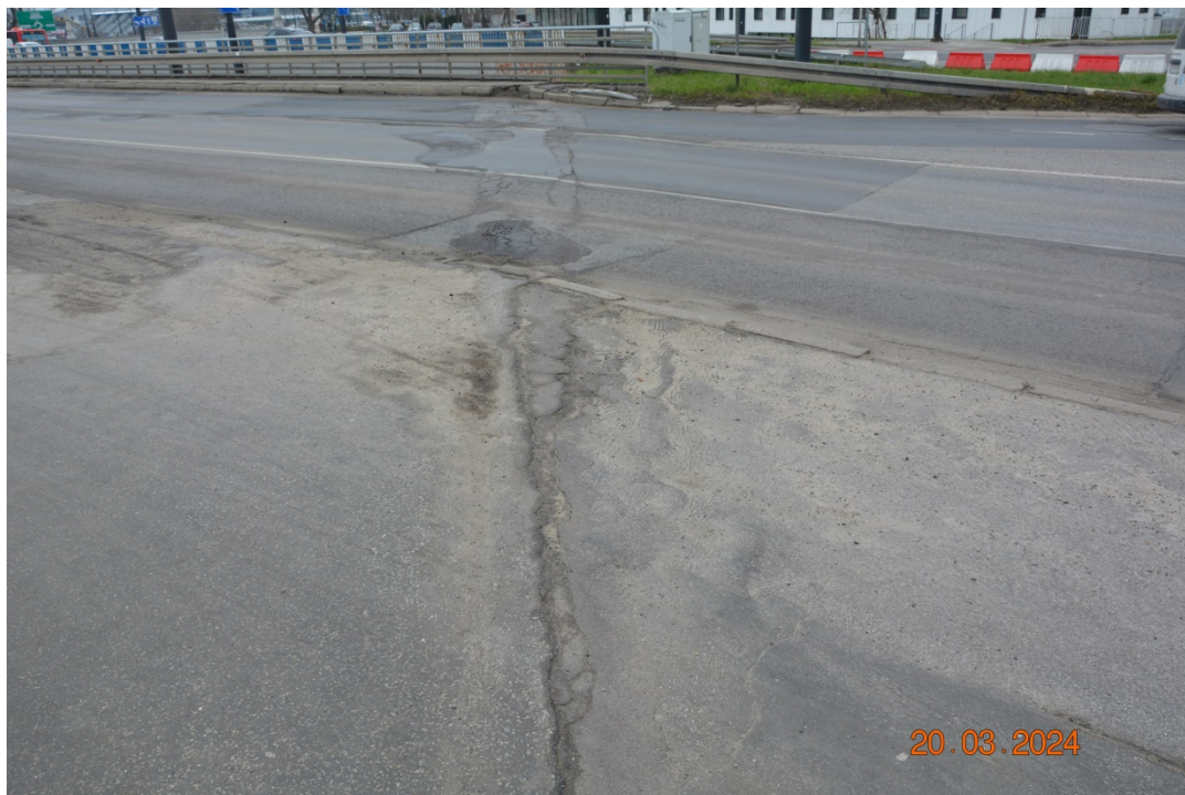
Fot. 9. Obszar dylatacyjny nad P1
