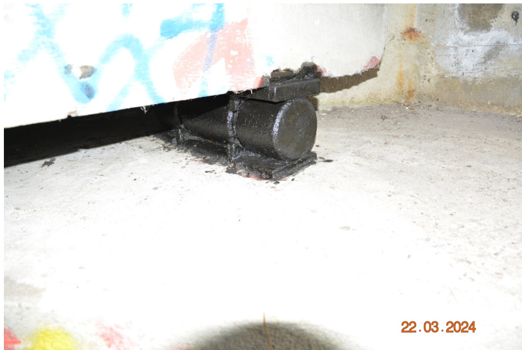
Fot. 13. Łożysko nad P1
