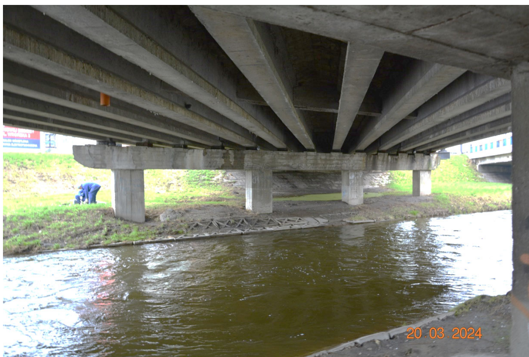
Fot. 8. Widok na podporę pośrednią P3
