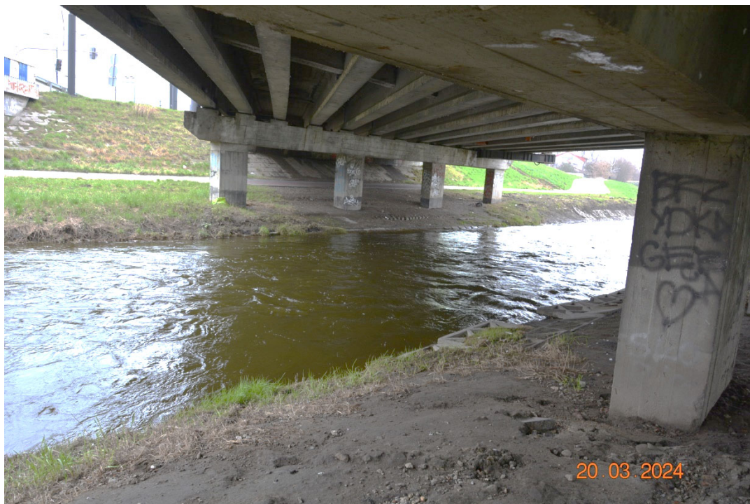
Fot. 7. Widok na podporę pośrednią P2
