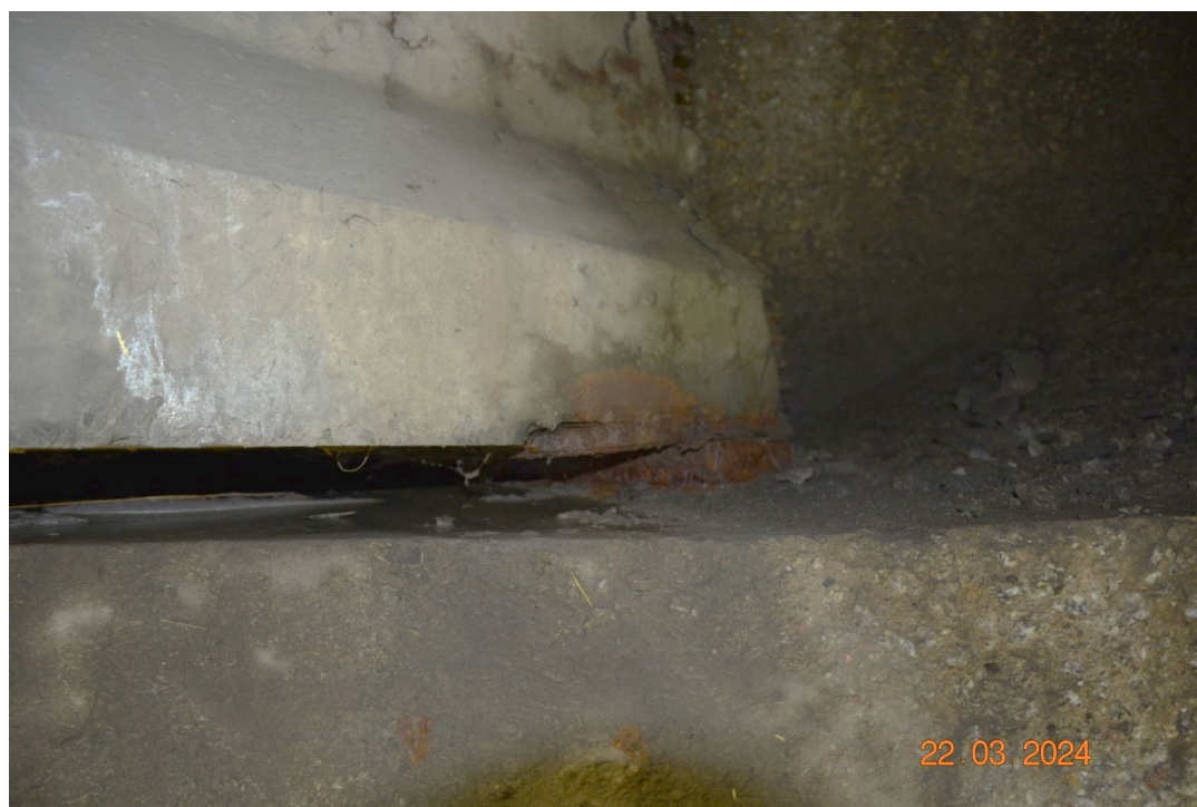
Fot. 14. Łożysko nad P4
