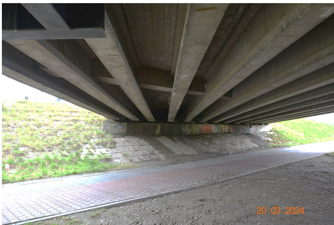
Fot. 18. Ustrój od spodu i przestrzeń podmostowa w kierunku P1
