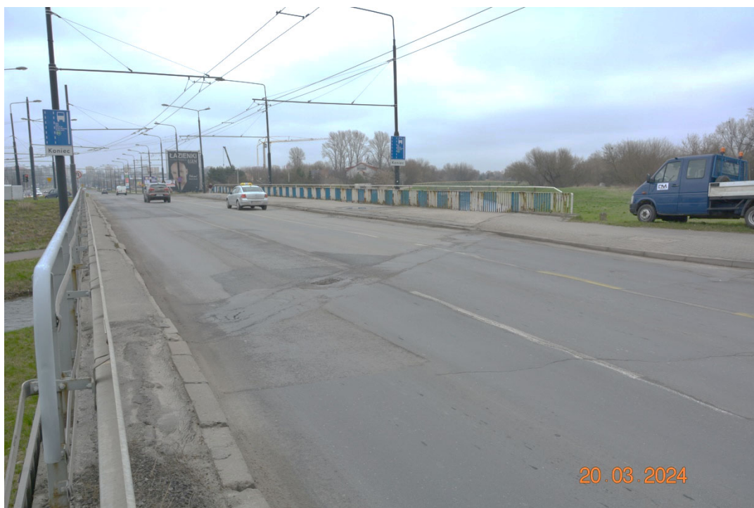
Fot. 4. Widok na jezdnię od ul. Lubelskiego Lipca 80
