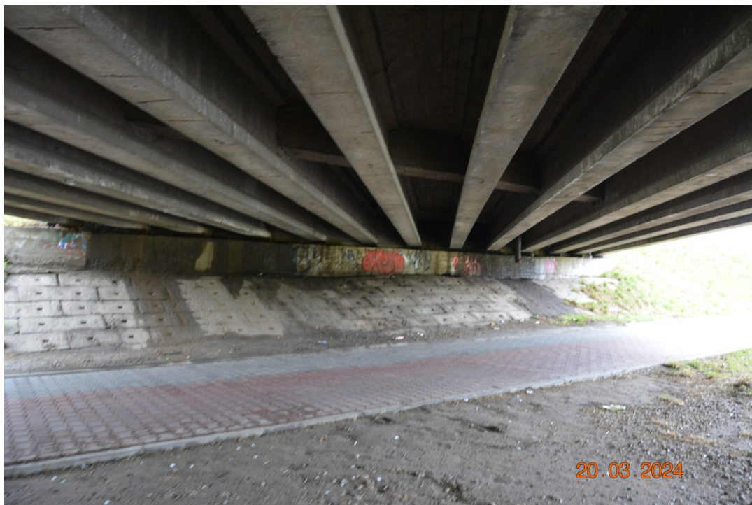
Fot. 5. Widok na podporę skrajną P1
