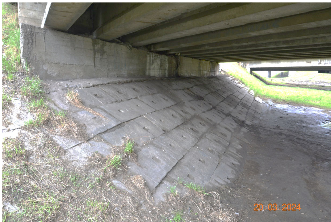
Fot. 6. Widok na podporę skrajną P4
