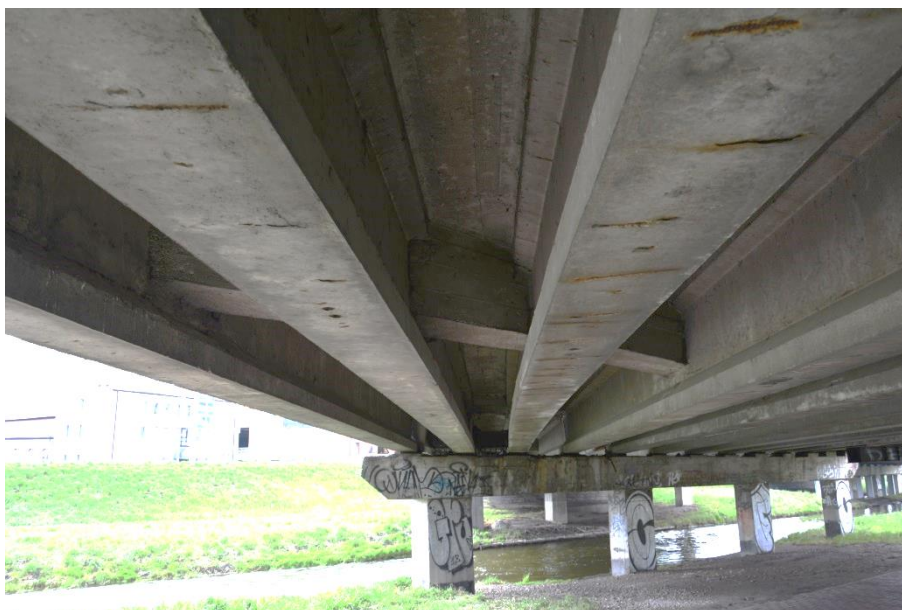
Fot. 4. Widok na ustrój i przestrzeń podmostową
