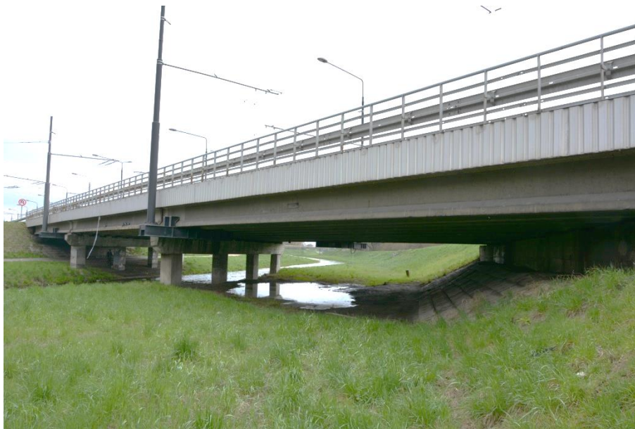
Fot. 1. Widok od strony górnej wody
