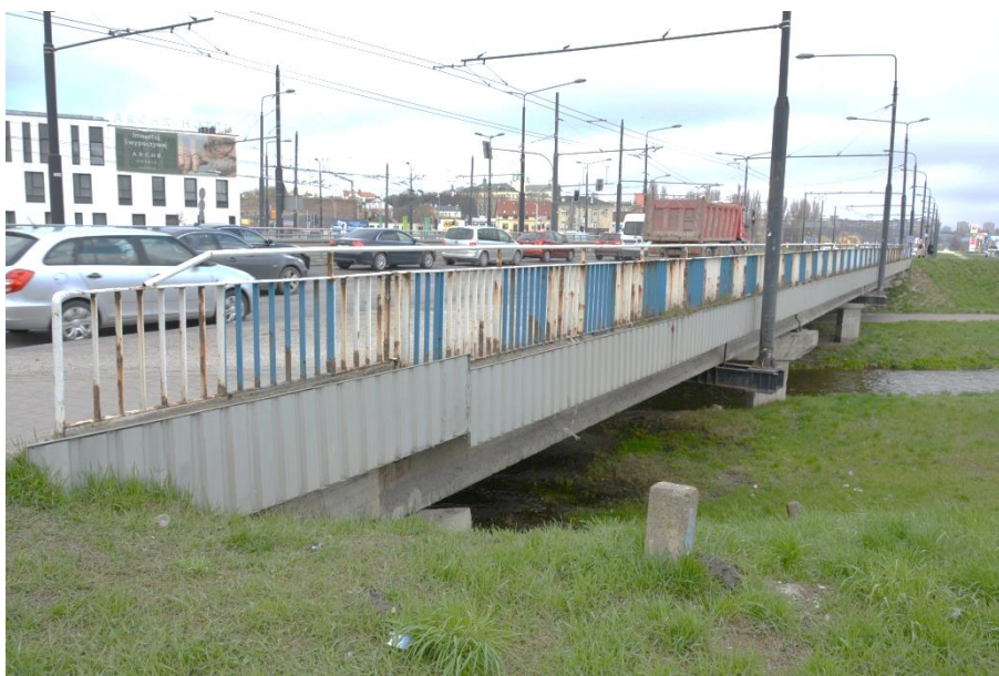
Fot. 2. Widok od strony dolnej wody
