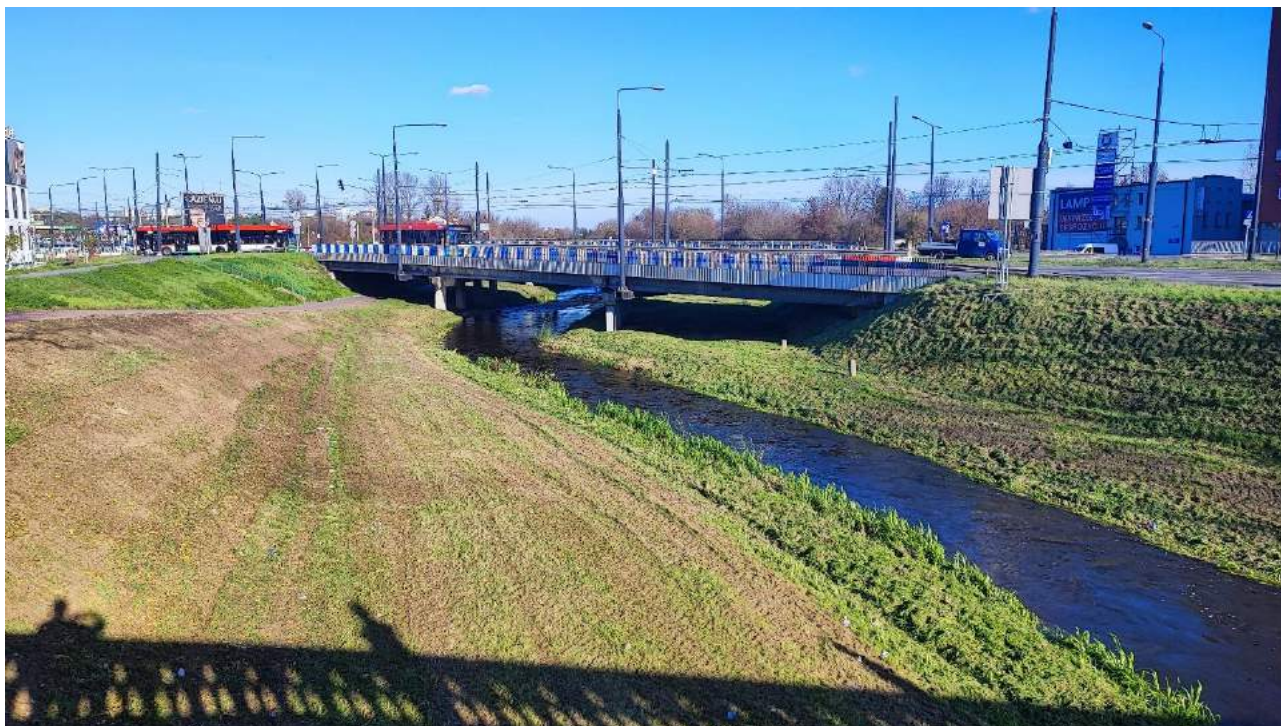
Fot. 1. Widok mostu od strony górnej wody
