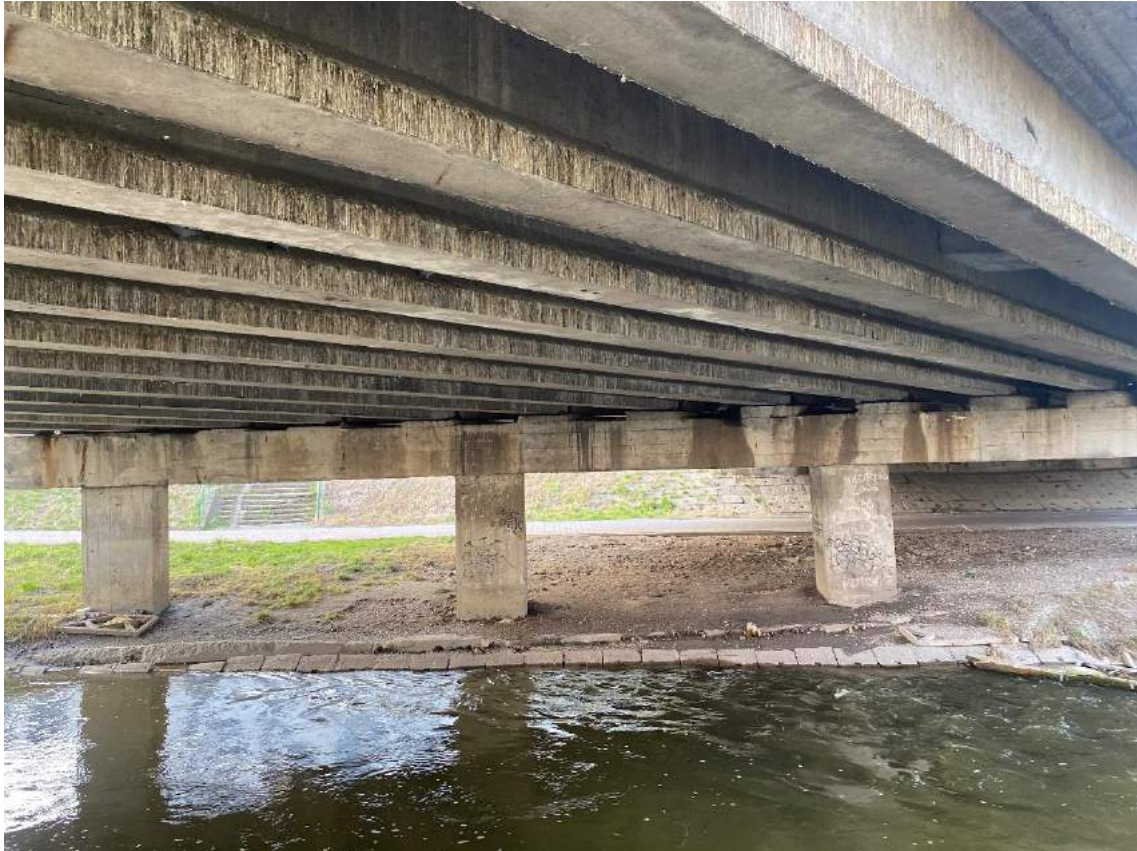
Fot. 9. Widok na podporę P2 od strony podpory P3.
