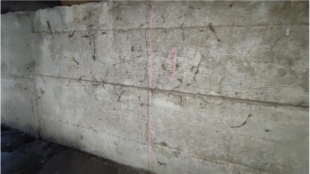
Fot. 43. Miejsce pomiarowe nr 1 na podporze P4.
