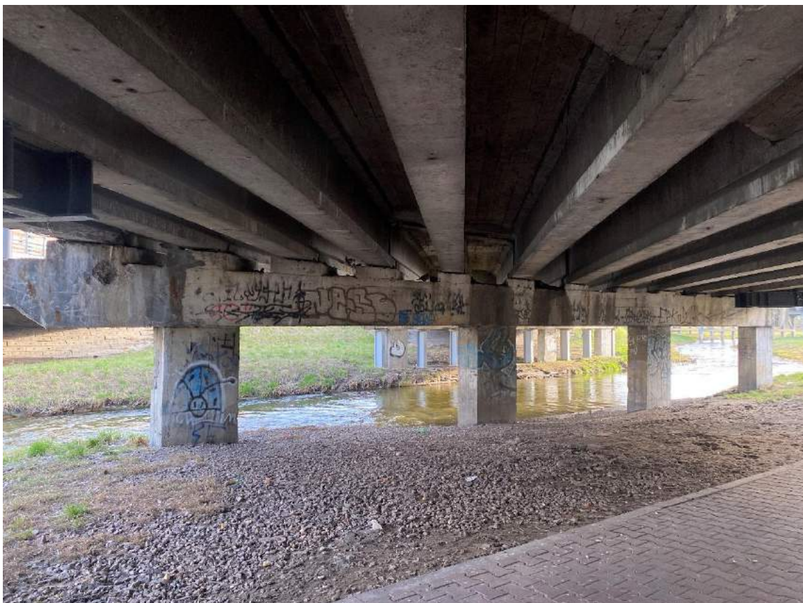
Fot. 8. Widok na podporę P2 od strony podpory P1.
