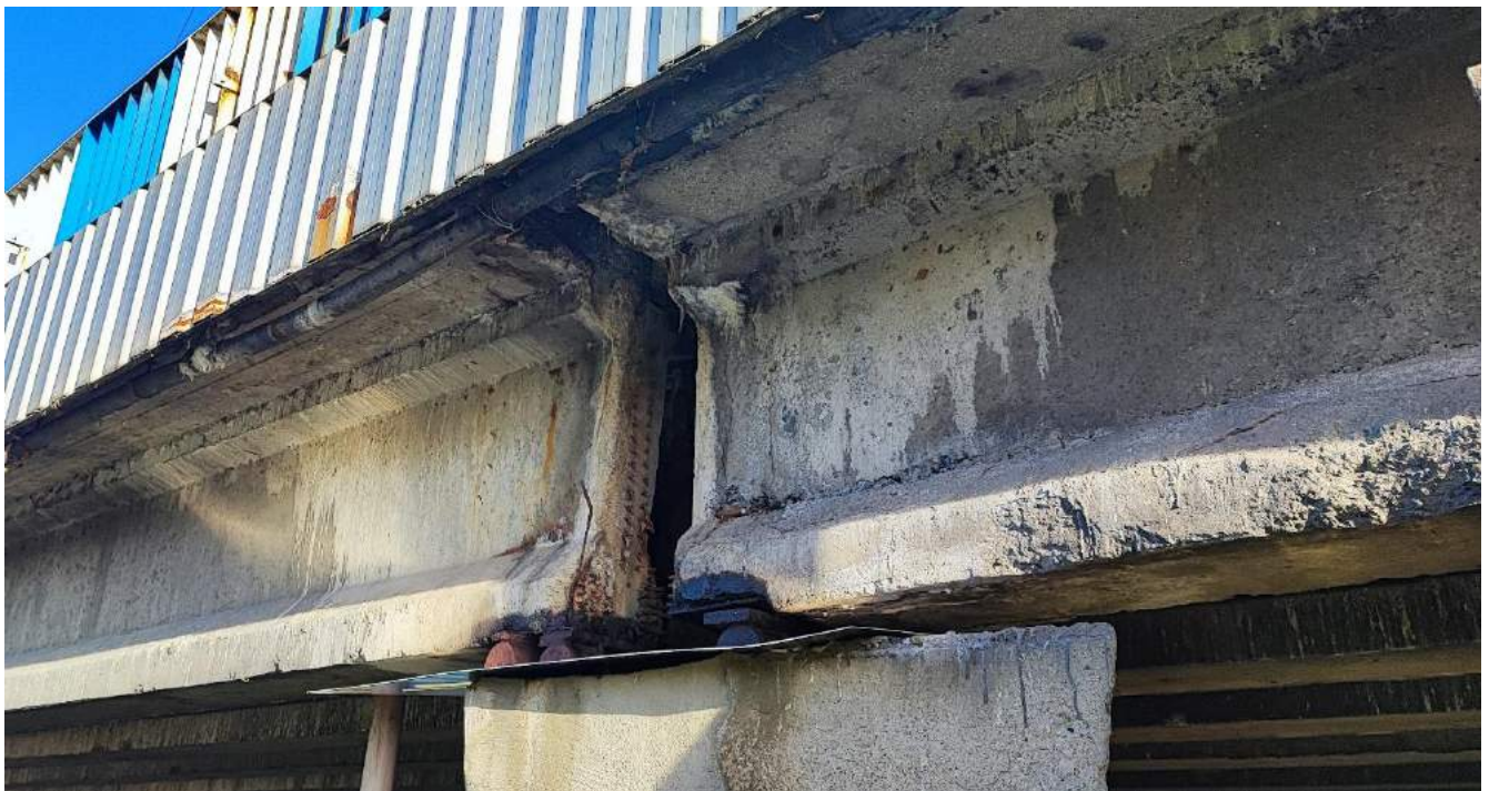
Fot. 38. Podpora P3. Belki od strony górnej wody
