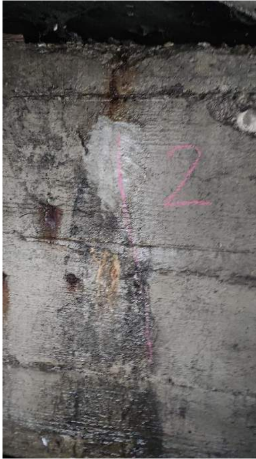
Fot. 45. Miejsce pomiarowe nr 2 na podporze P4.
