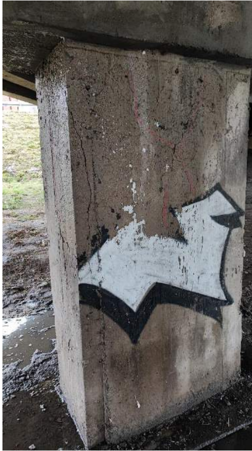
Fot. 31. Miejsce pomiarowe podpora P3.
