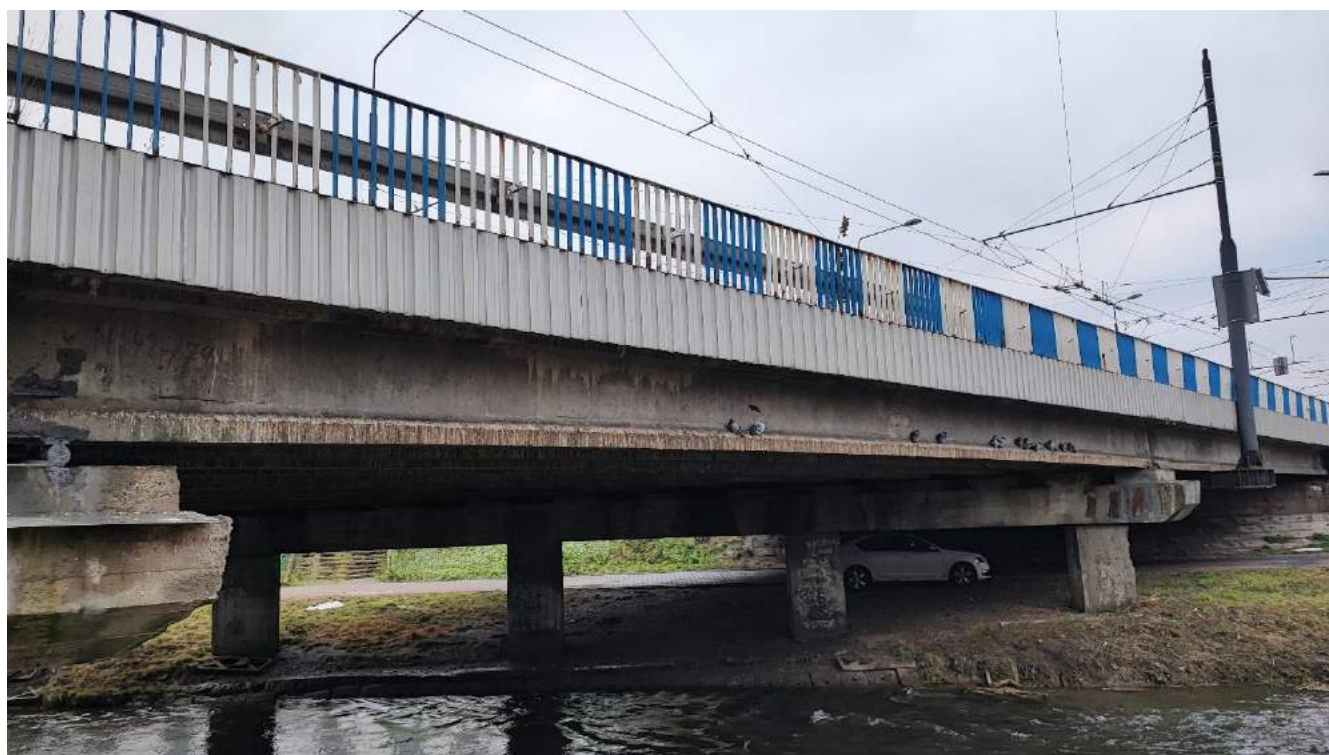
Fot. 4. Widok mostu od strony dolnej wody
