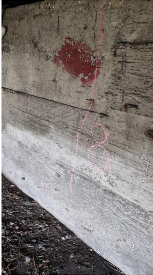
Fot. 55. Miejsce pomiarowe nr 8 na podporze P4.
