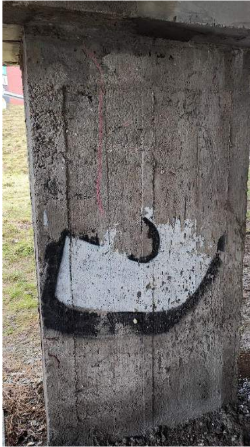
Fot. 35. Miejsce pomiarowe podpora P3.
