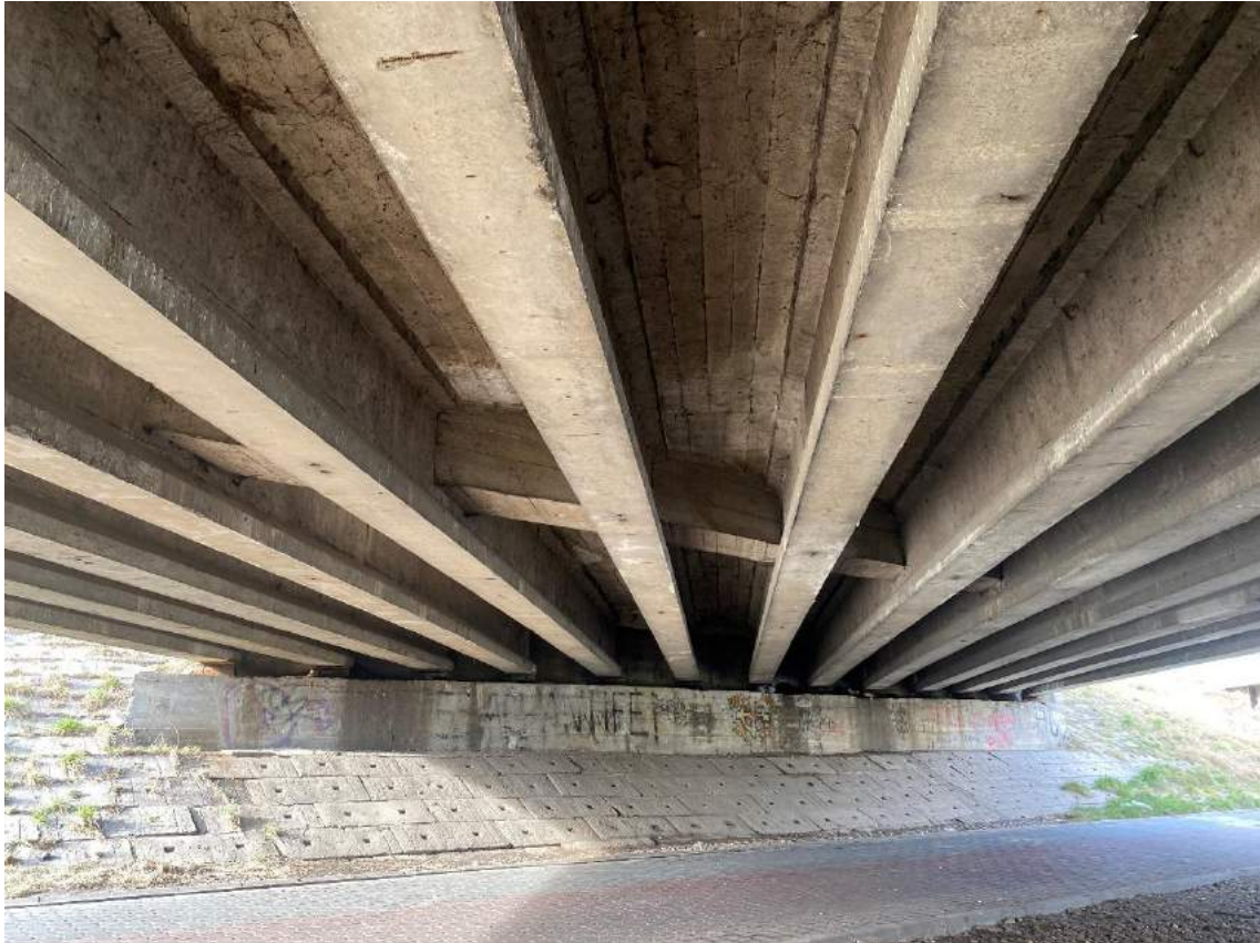
Fot. 7. Widok na podporę P1.
