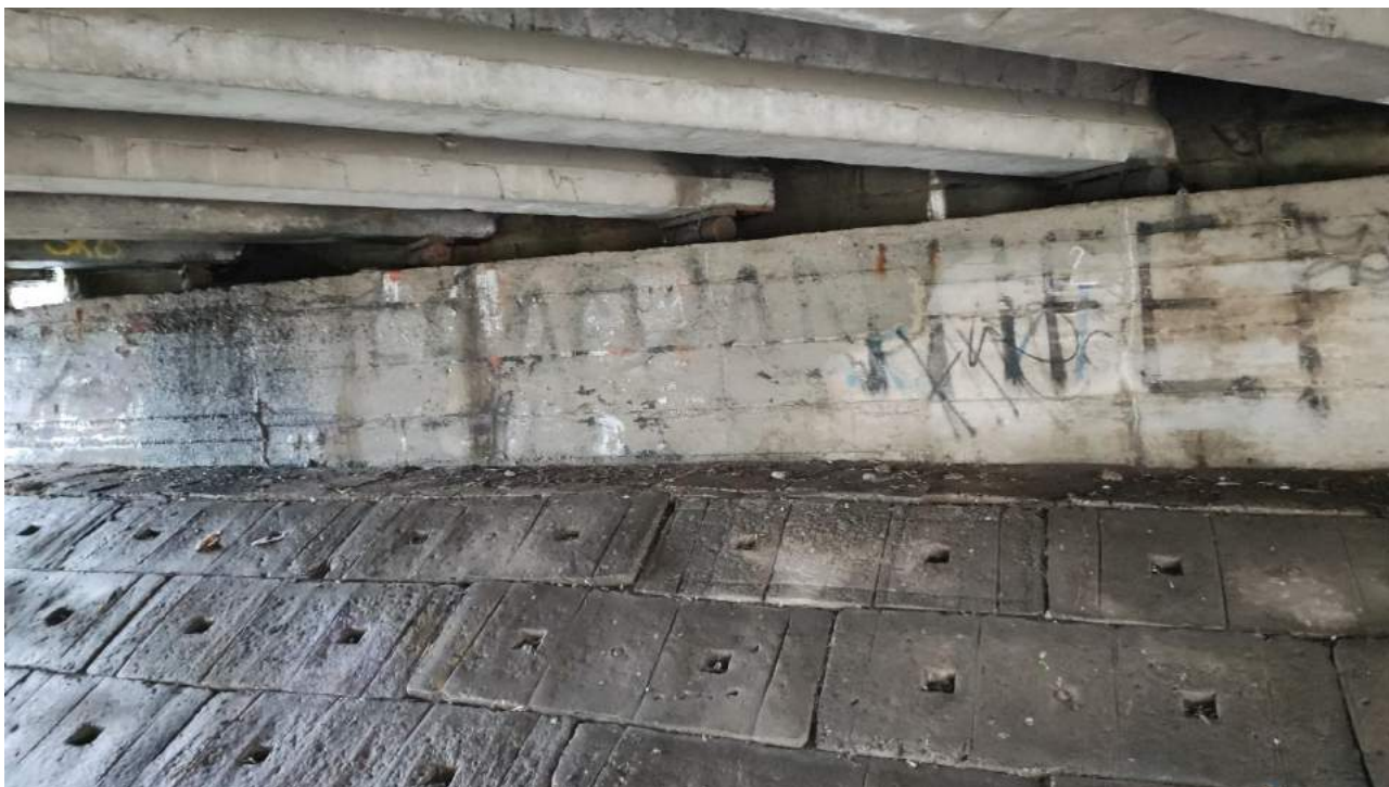
Fot. 2. Widok na rysy pionowe. Miejsca pomiarowe nr 1,2,3.
