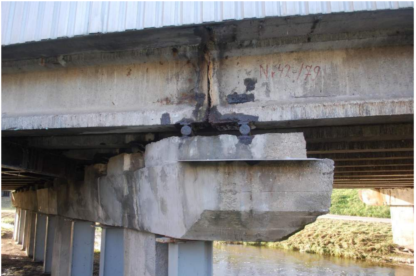
Fot. 37. Podpora P3. Belki od strony dolnej wody
