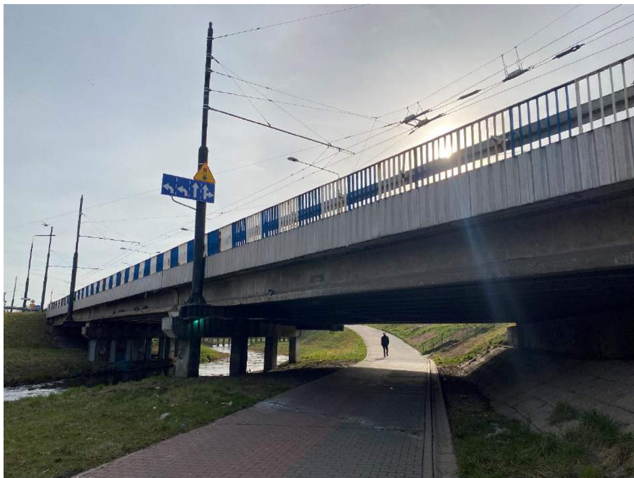
Fot. 3. Widok mostu od strony dolnej wody
