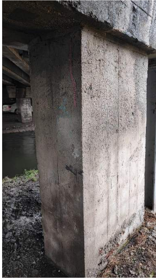
Fot. 33. Miejsce pomiarowe podpora P3.
