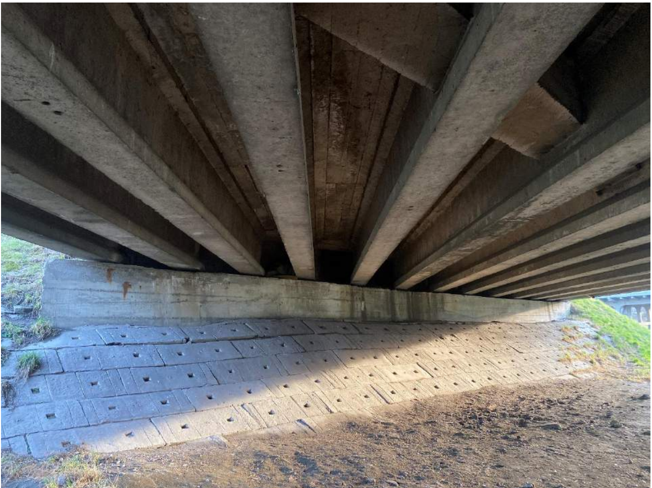
Fot. 12. Widok na podporę P4.
