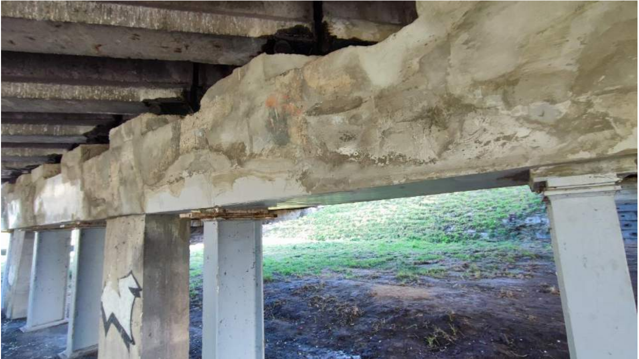
Fot. 11. Widok na podporę P3 od strony podpory P4.
