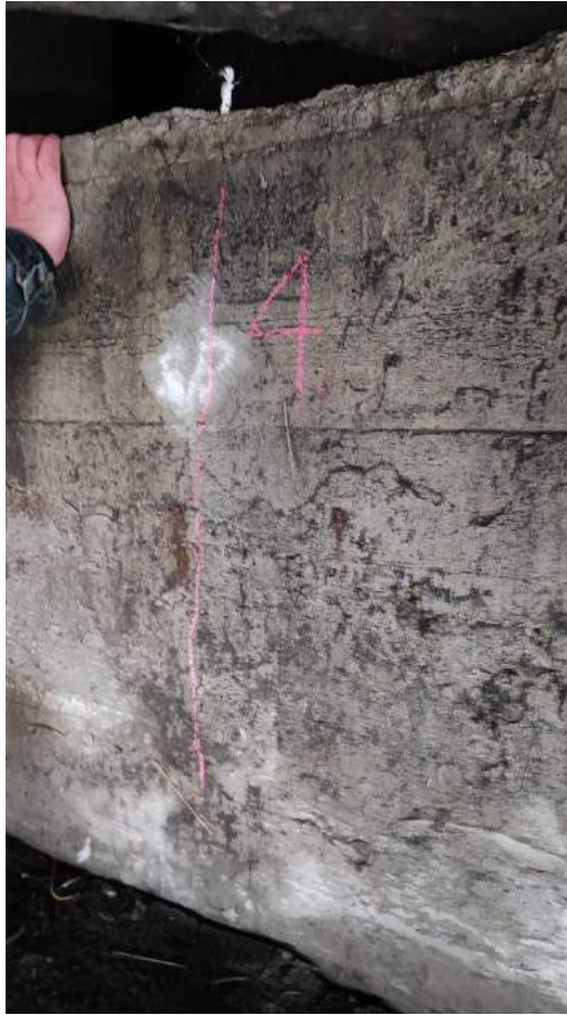
Fot. 49. Miejsce pomiarowe nr 4 na podporze P4.
