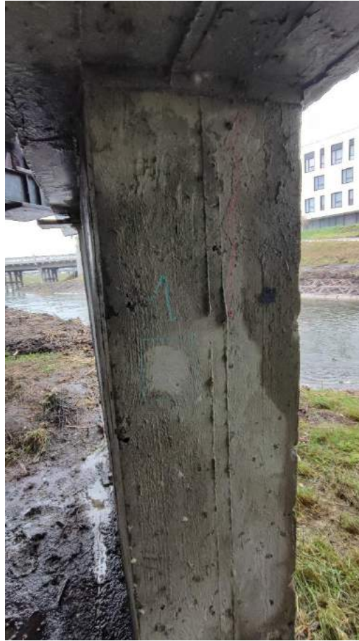
Fot. 21. Miejsce pomiarowe podpora P3.
