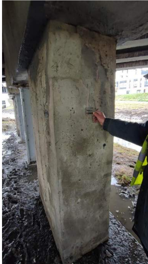
Fot. 25. Miejsce pomiarowe podpora P3.
