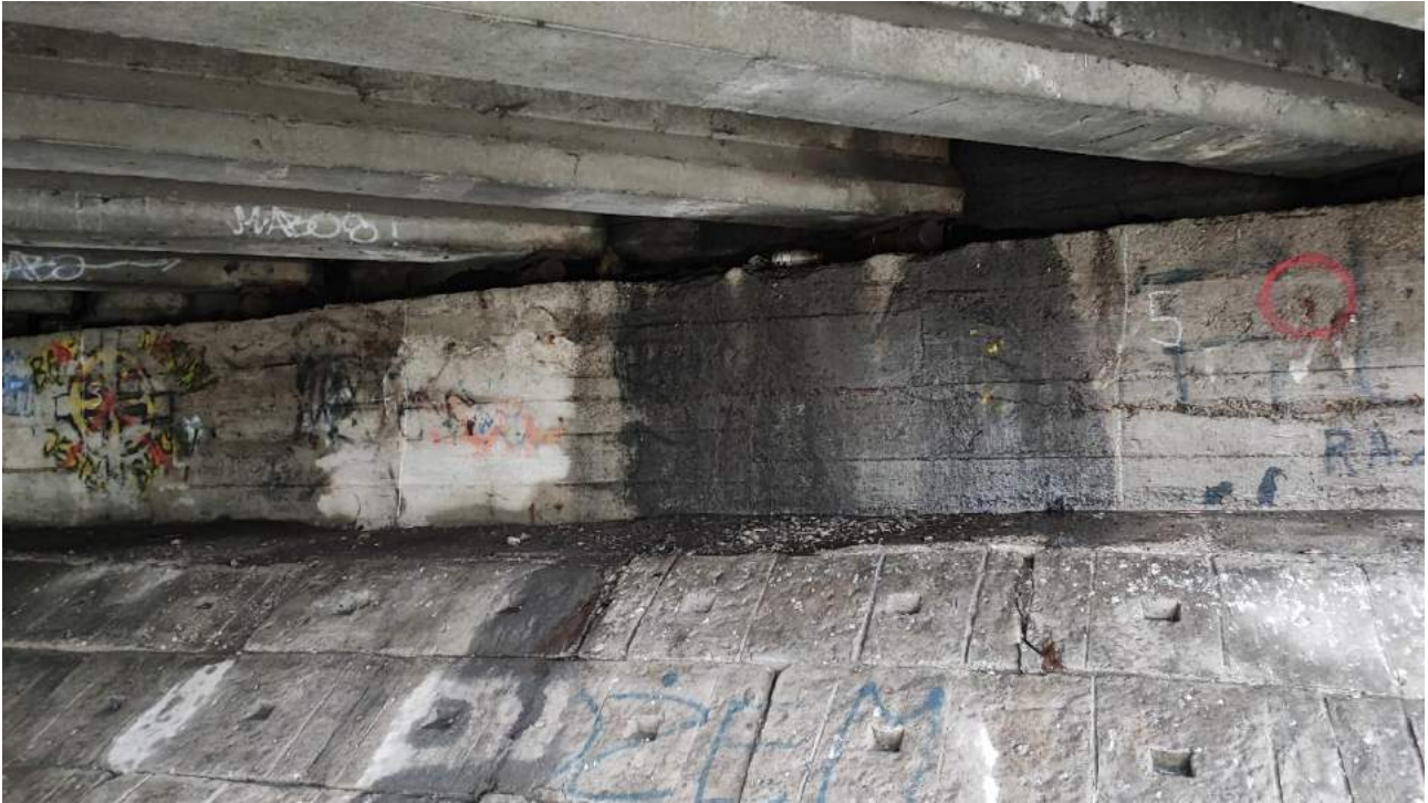
Fot. 3. Widok na rysy pionowe. Miejsca pomiarowe nr 4,5.
