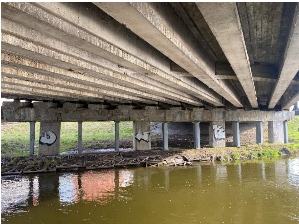
Fot. 10. Widok na podporę P3 od strony podpory P2.
