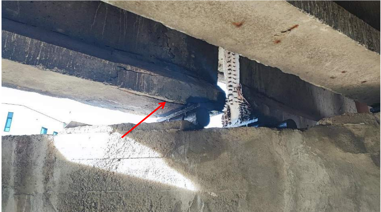
Fot. 39 Podpora P3. Belki od strony górnej wody
