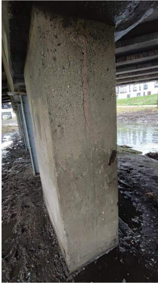
Fot. 29. Miejsce pomiarowe podpora P3.
