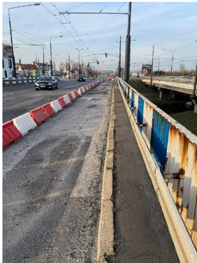
Fot. 6. Widok mostu od strony ul. Fabrycznej
