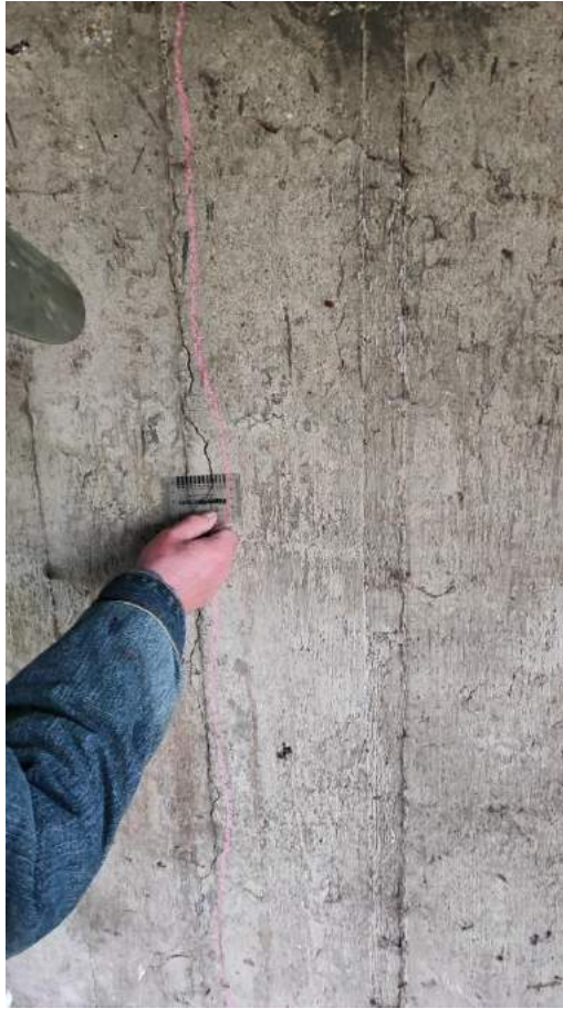
Fot. 23. . Miejsce pomiarowe podpora P3.
