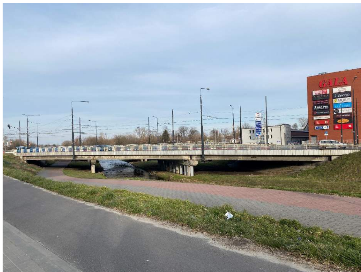
Fot. 2. Widok mostu od strony górnej wody
