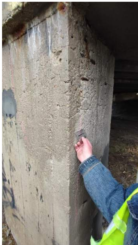
Fot. 18. Miejsce pomiarowe podpora P3.
