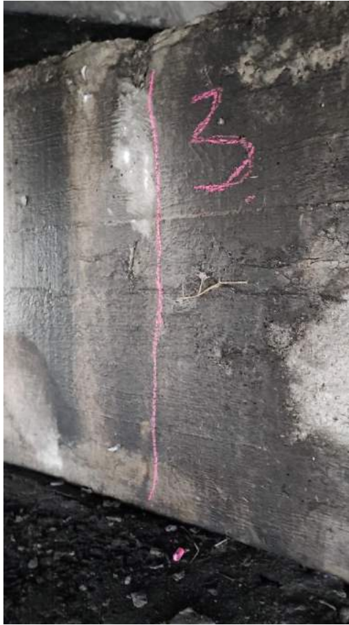
Fot. 47. Miejsce pomiarowe nr 3 na podporze P4.
