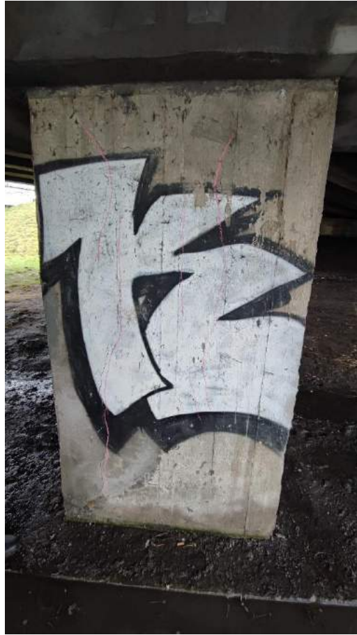
Fot. 27. Miejsce pomiarowe podpora P3.
