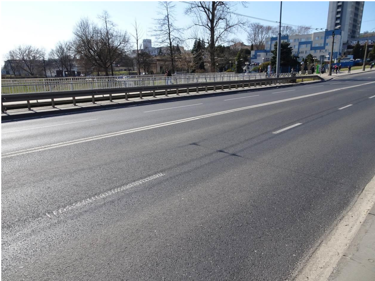
Fot. 7. Nawierzchnia jezdni na moście bez uszkodzeń.
