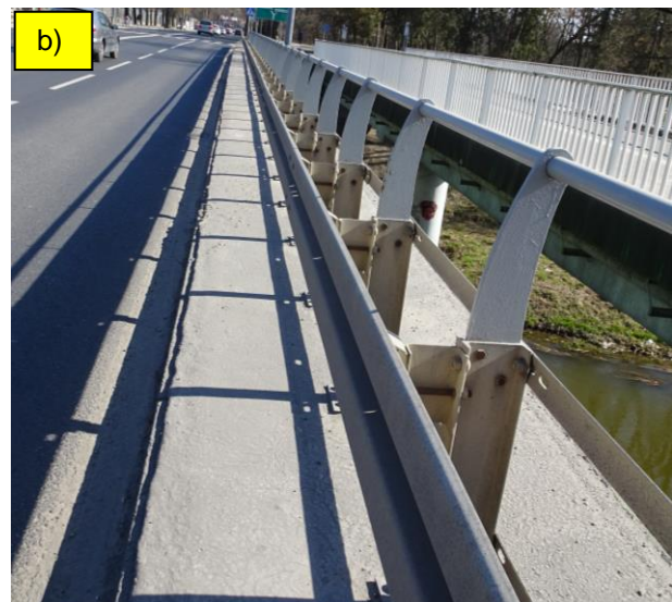
Fot. 8. Chodnik od str. DW (a) i GW (b). Nawierzchnia bez większych uszkodzeń. W barieroporęczach korozja łączników śrubowych i przekładek (fot. 9).
