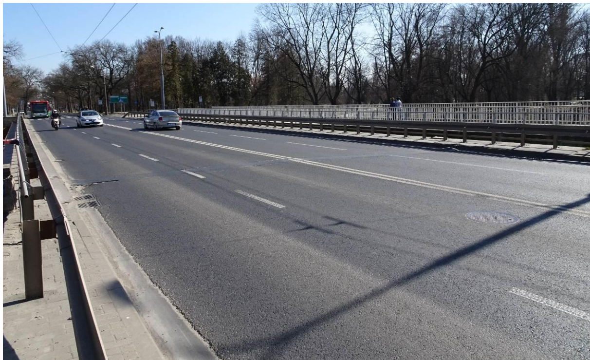
Fot. 1. Widok mostu z dojazdu od str. zachodniej
