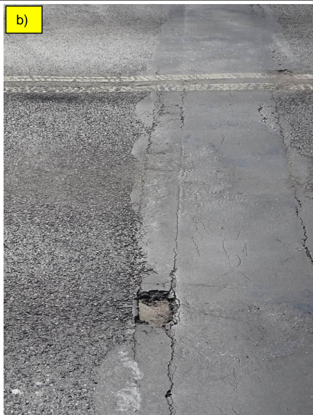
Fot. 10. Dylatacja bitumiczna jezdni nad przyczółkiem prawobrzeżnym. Liczne spękania dylatacji oraz spękania i niewielkie ubytki nawierzchni jezdni.
