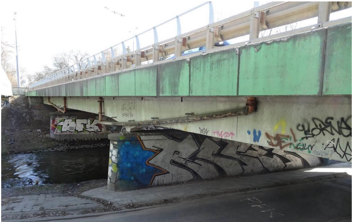
Fot. 3. Widok ogólny mostu od strony dolnej wody (DW)
