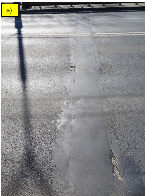
Fot. 10. Dylatacja bitumiczna jezdni nad przyczółkiem prawobrzeżnym. Liczne spękania dylatacji oraz spękania i niewielkie ubytki nawierzchni jezdni.
