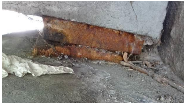
Fot. 26. Typowy stan łożysk przesuwnych na przyczółku lewobrzeżnym. Położenie łożysk nie odpowiada temperaturze konstrukcji, co może świadczyć o przemieszczeniu poziomym przyczółka w kierunku przeszkody. Intensywna korozja powierzchniowa łożysk.
