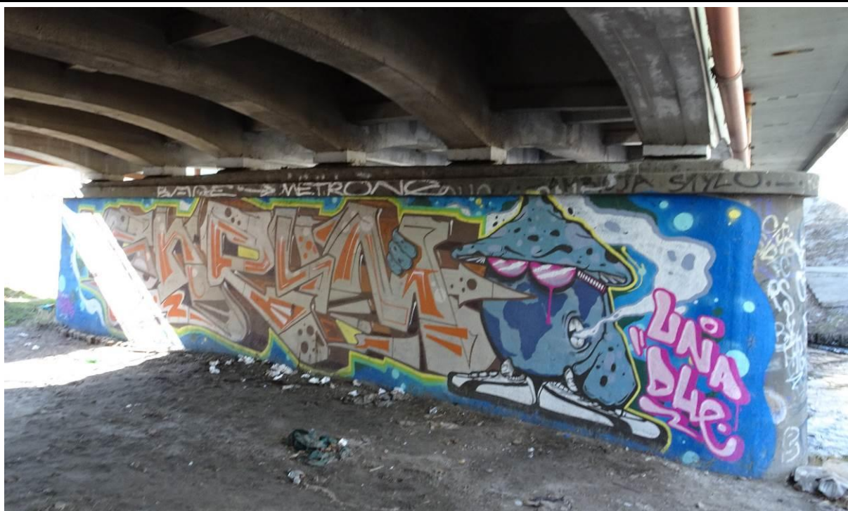
Fot. 24. Filar prawobrzeżny. Brak uszkodzeń.
