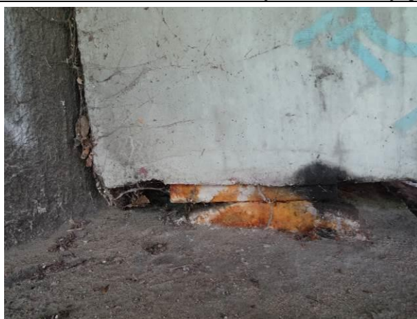
Fot. 28. Typowy stan łożysk przesuwnych na filarze prawobrzeżnym. Położenie łożysk odpowiada temperaturze konstrukcji. Lokalna korozja powierzchniowa elementów łożysk.
