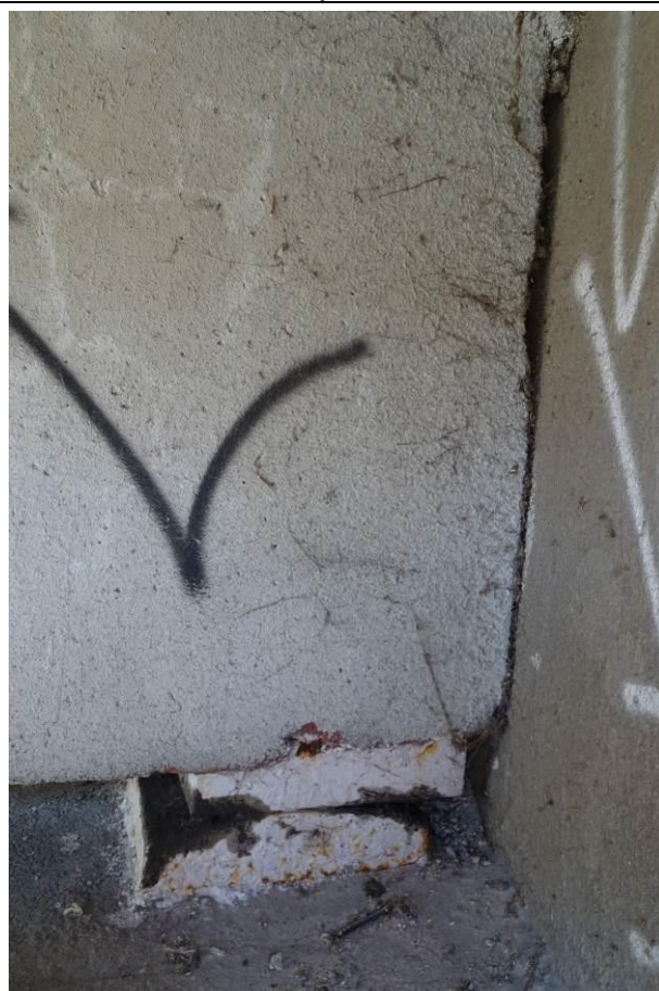
Fot. 29. Stan łożysk przesuwnych na przyczółku prawobrzeżnym. Położenie łożysk nie odpowiada temperaturze konstrukcji, co może świadczyć o przemieszczeniu poziomym przyczółka w kierunku przeszkody, o czym może też świadczyć zaciśnięta szczelina dylatacyjna pomiędzy dźwigarem a ścianką zapleczną przyczółka. Lokalna korozja powierzchniowa łożysk.
