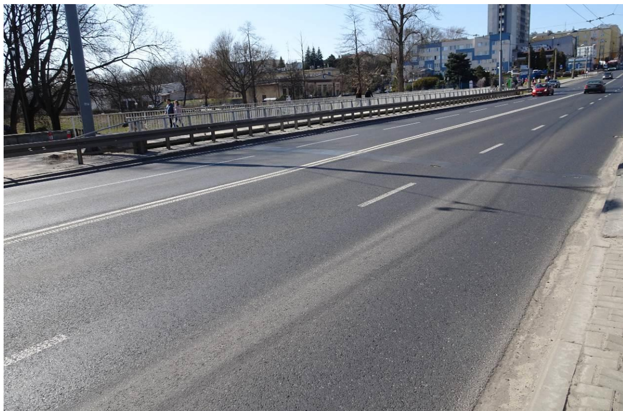
Fot. 2. Widok mostu z dojazdu od str. wschodniej
