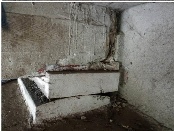
Fot. 29. Stan łożysk przesuwnych na przyczółku prawobrzeżnym. Położenie łożysk nie odpowiada temperaturze konstrukcji, co może świadczyć o przemieszczeniu poziomym przyczółka w kierunku przeszkody, o czym może też świadczyć zaciśnięta szczelina dylatacyjna pomiędzy dźwigarem a ścianką zapleczną przyczółka. Lokalna korozja powierzchniowa łożysk.
