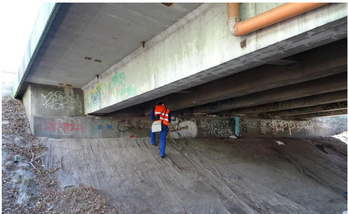
Fot. 6. Widok konstrukcji przęsła skrajnego od przyczółka prawobrzeżnego.
