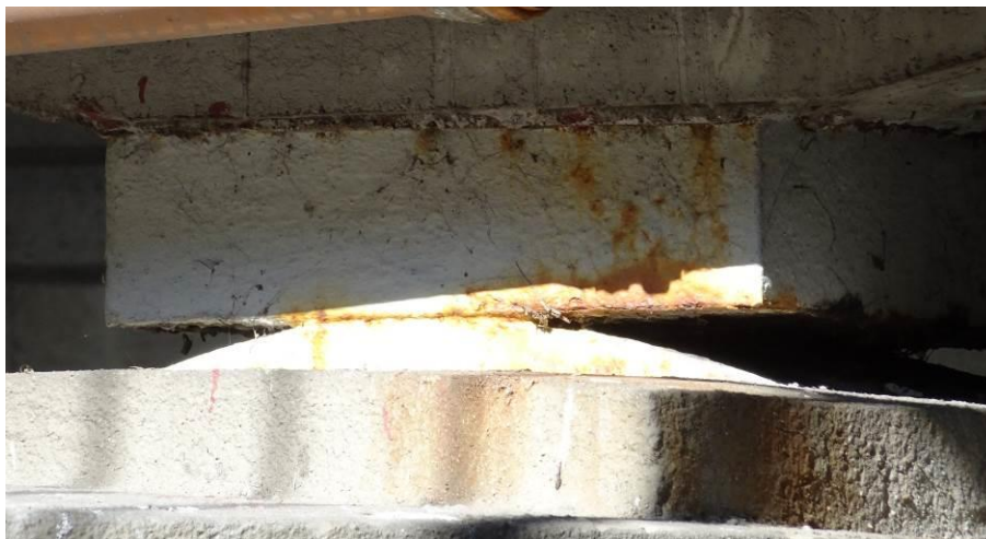
Fot. 28. Typowy stan łożysk przesuwnych na filarze prawobrzeżnym. Położenie łożysk odpowiada temperaturze konstrukcji. Lokalna korozja powierzchniowa elementów łożysk.
