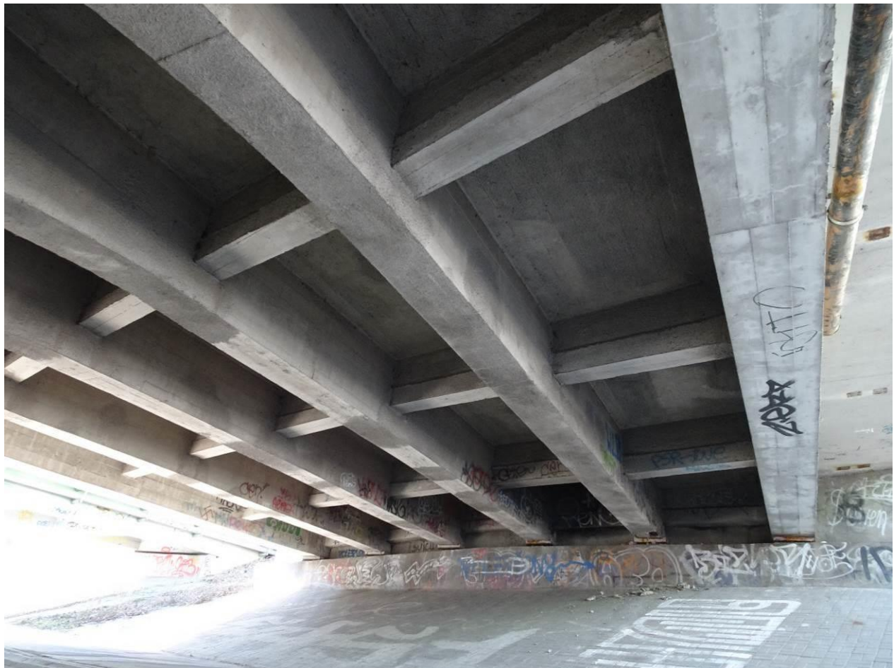
Fot. 4. Widok konstrukcji przęsła skrajnego od przyczółka lewobrzeżnego.
