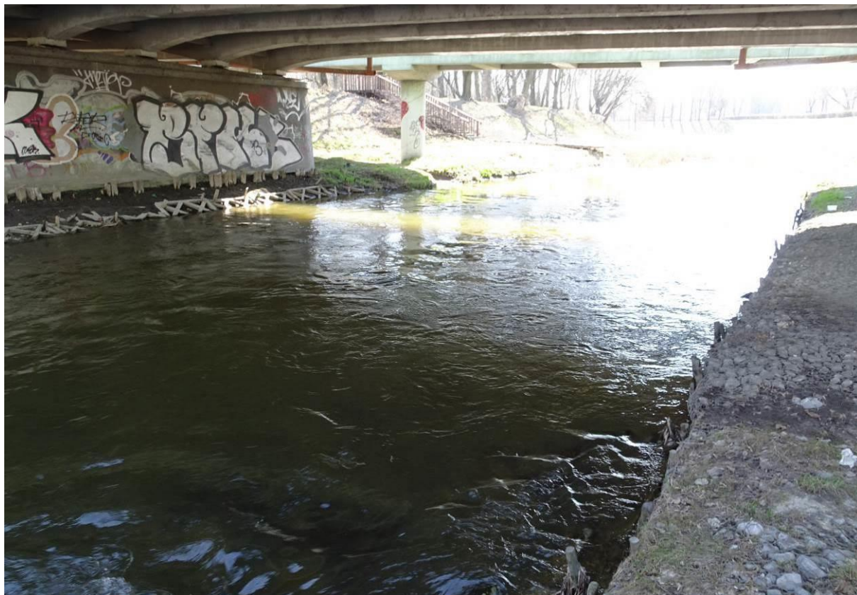
Fot. 30. Koryto rzeki pod mostem. Poza niewielkimi deformacjami umocnienia betonowego na prawym brzegu nie stwierdzono uszkodzeń.
