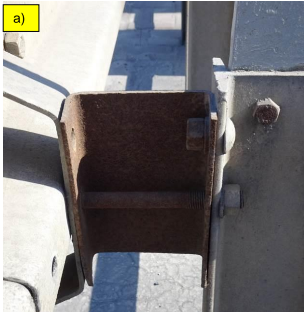
Fot. 9. Typowe uszkodzenia barieroporeczy – korozja powierzchniowa przekładek ceowych i łączników śrubowych.
