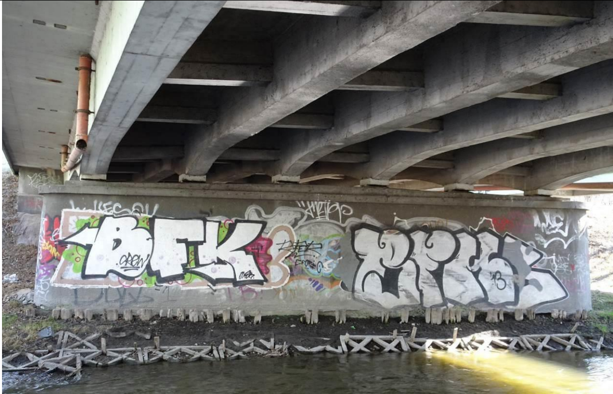
Fot. 5. Widok konstrukcji przęsła środkowego od filara prawobrzeżnego.
