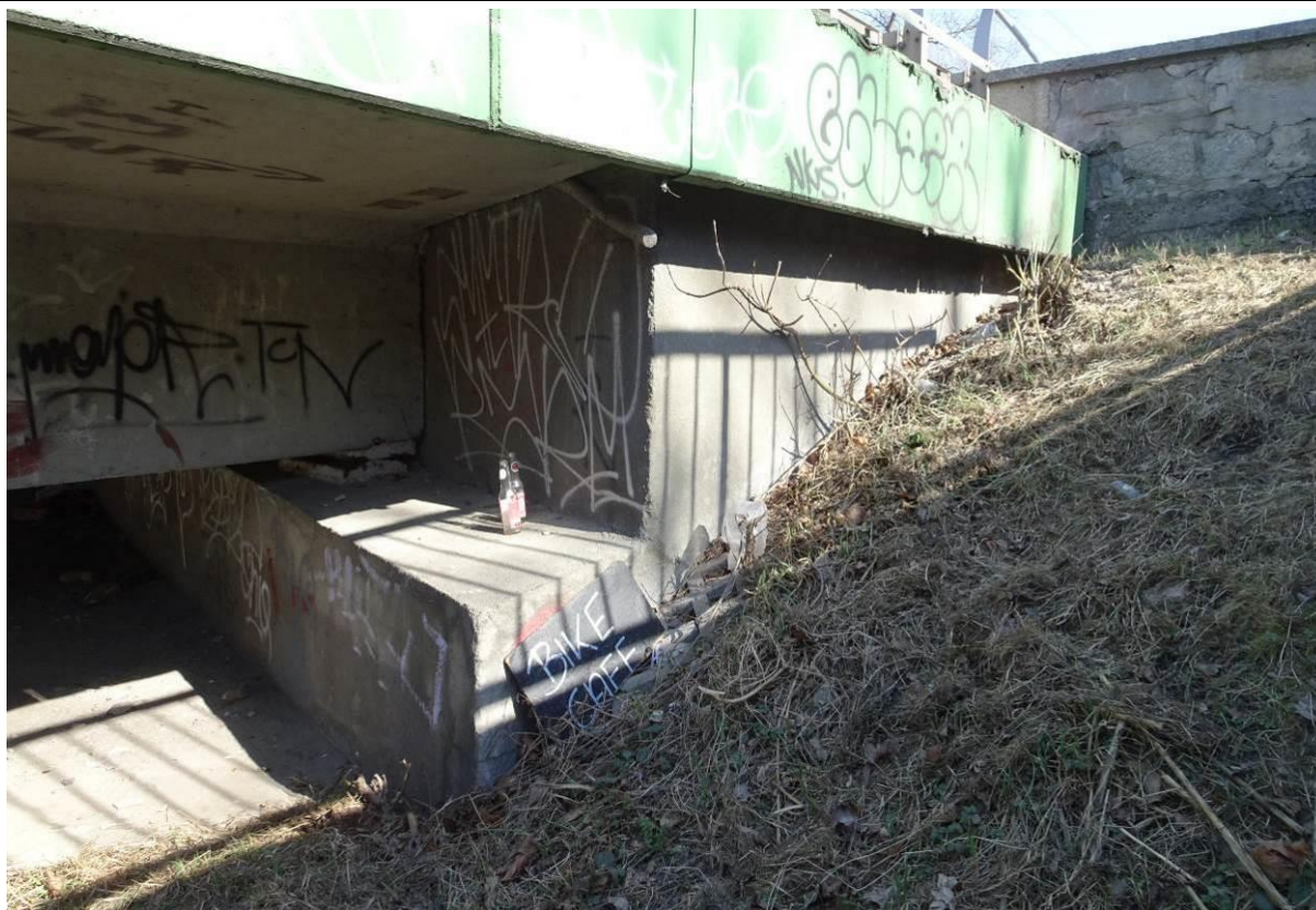
Fot. 23. Przyczółek prawobrzeżny, widok od str. DW. Korpus i skrzydło bez uszkodzeń.
