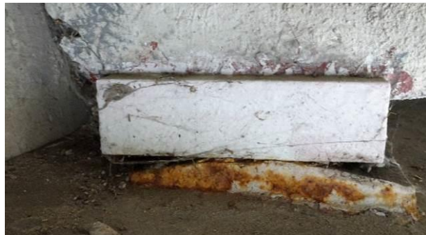
Fot. 26. Typowy stan łożysk przesuwnych na przyczółku lewobrzeżnym. Położenie łożysk nie odpowiada temperaturze konstrukcji, co może świadczyć o przemieszczeniu poziomym przyczółka w kierunku przeszkody. Intensywna korozja powierzchniowa łożysk.
