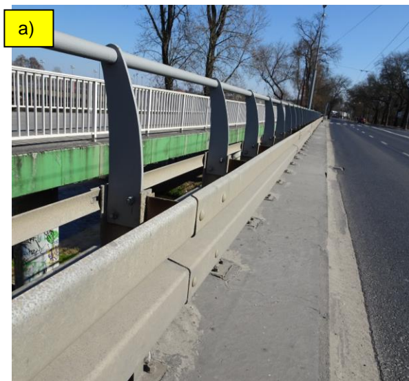
Fot. 8. Chodnik od str. DW (a) i GW (b). Nawierzchnia bez większych uszkodzeń. W barieroporęczach korozja łączników śrubowych i przekładek (fot. 9).
