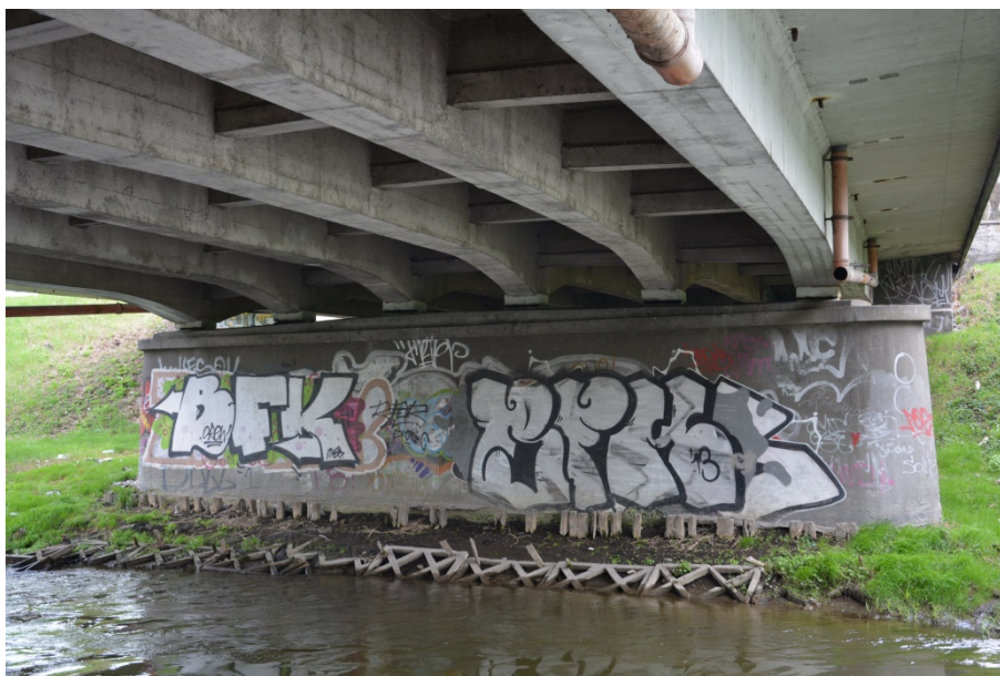
Fot. 4. Widok na ustrój i przestrzeń podmostową
