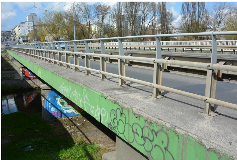
Fot. 1. Widok od strony górnej wody
