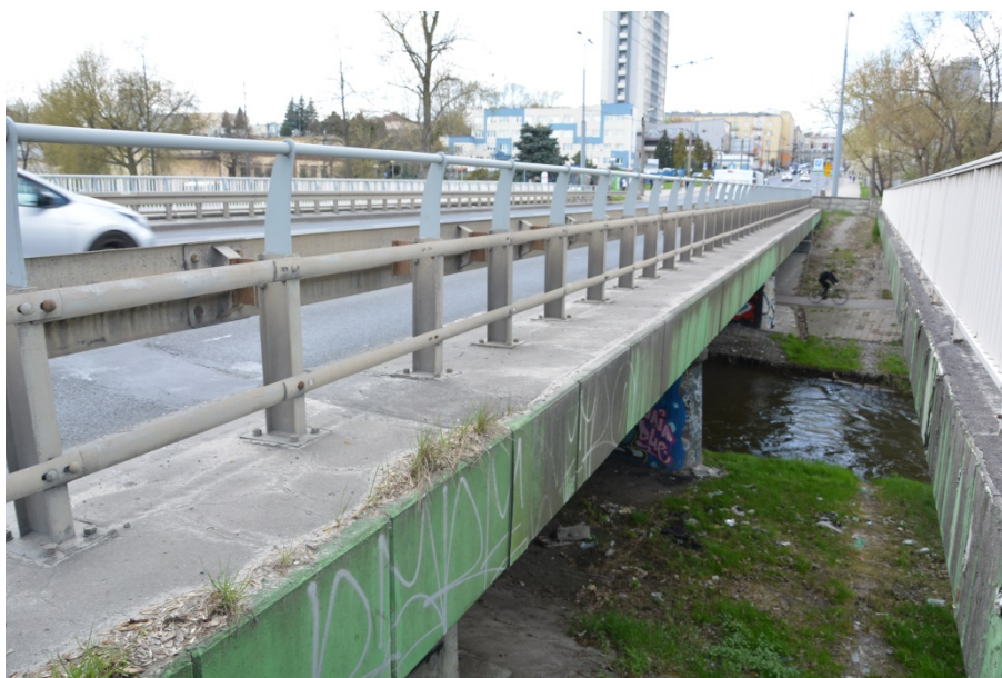
Fot. 2. Widok od strony dolnej wody
