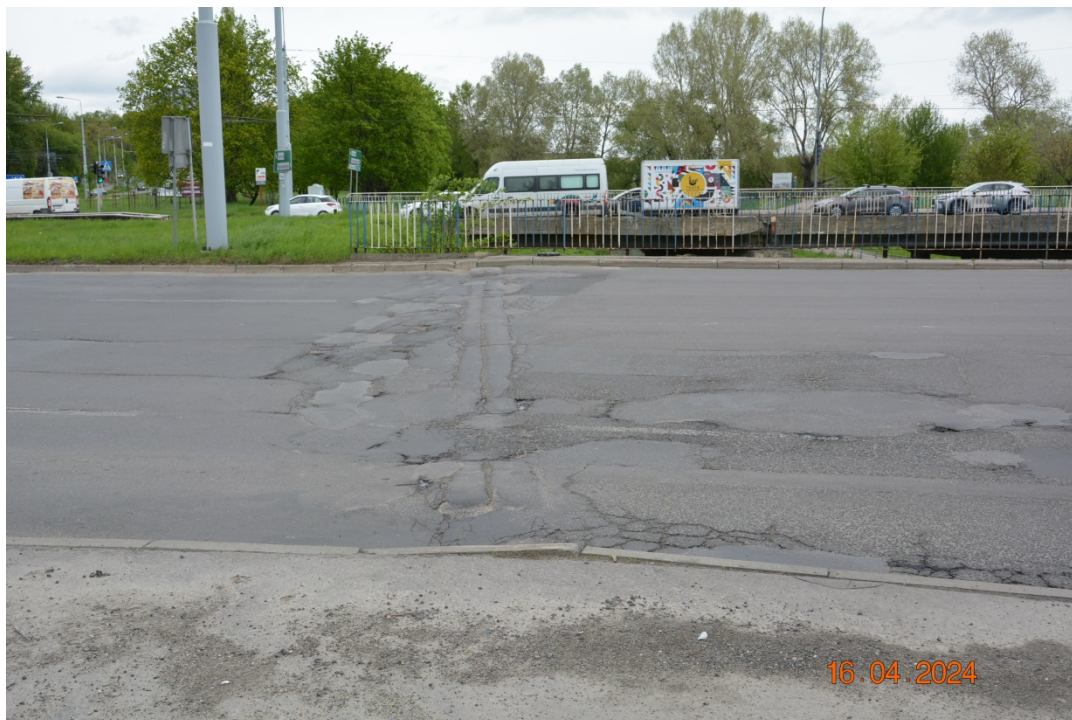
Fot. 9. Obszar dylatacyjny nad P1
