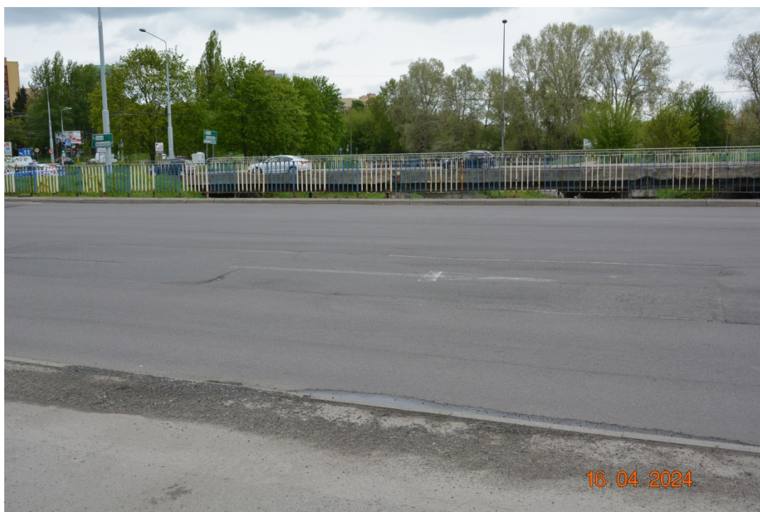
Fot. 10. Obszar dylatacyjny nad P2
