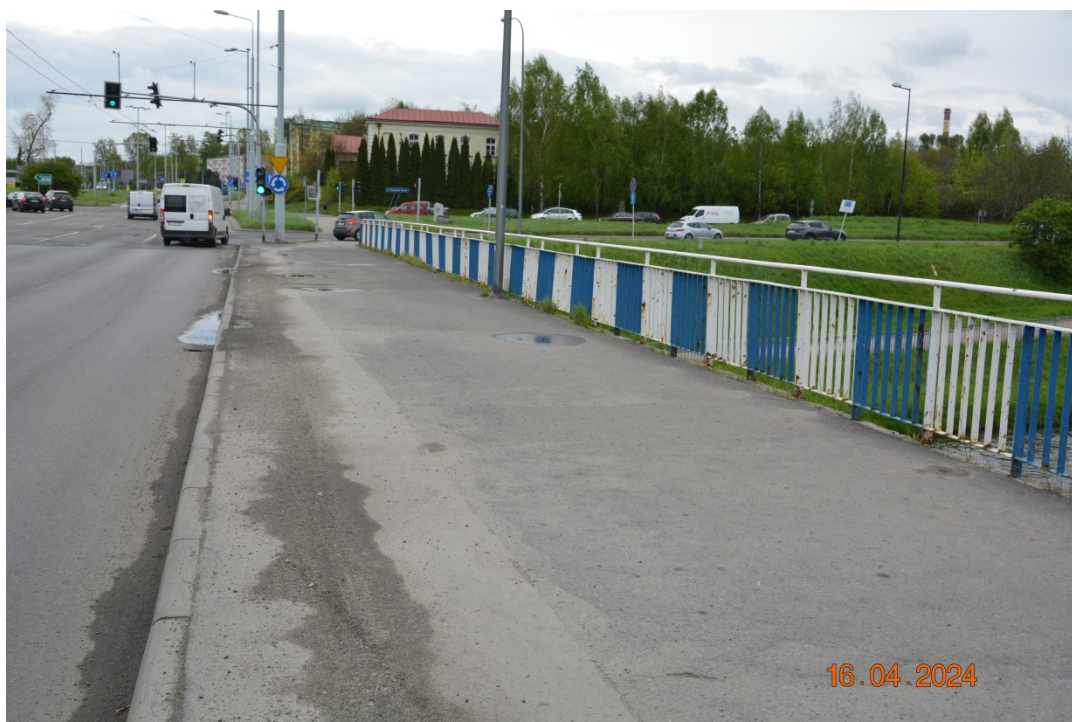
Fot. 4. Widok na chodnik od ul. Andersa
