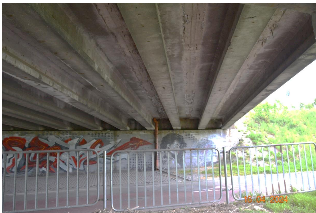
Fot. 18. Ustrój od spodu i przestrzeń podmostowa w kierunku P4
