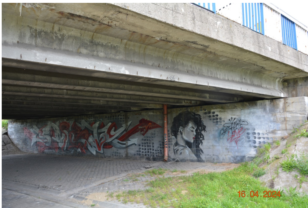
Fot. 6. Widok na podporę skrajną P4
