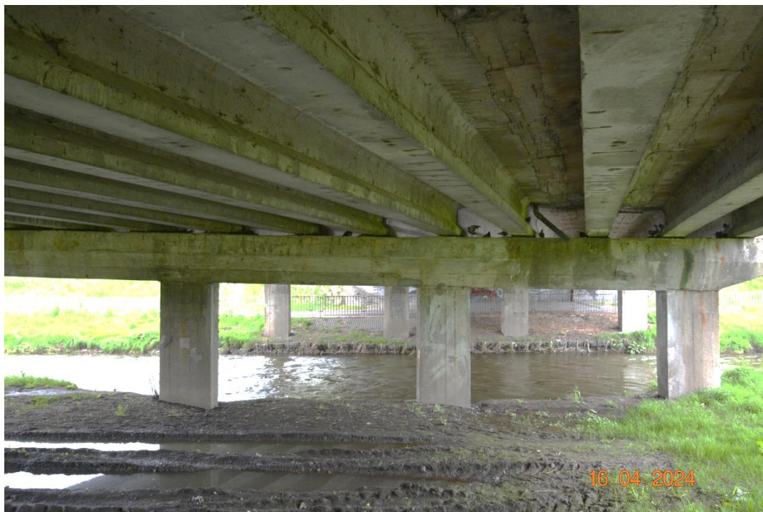
Fot. 17. Ustrój od spodu i przestrzeń podmostowa w kierunku P2
