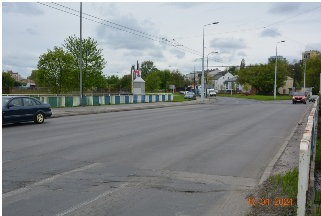
Fot. 3. Widok jezdnię od ul. Turystycznej
