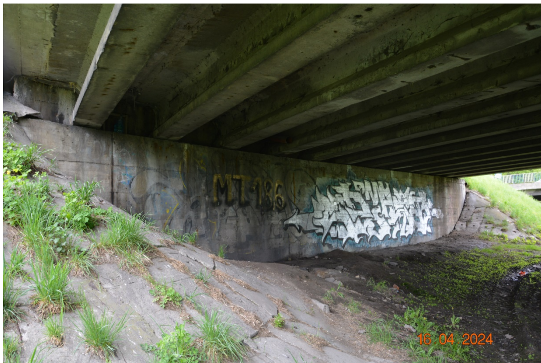
Fot. 5. Widok na podporę skrajną P1
