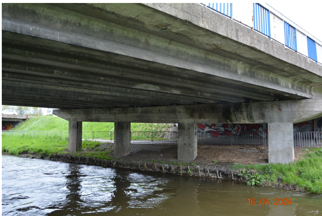
Fot. 8. Widok na podporę pośrednią P3
