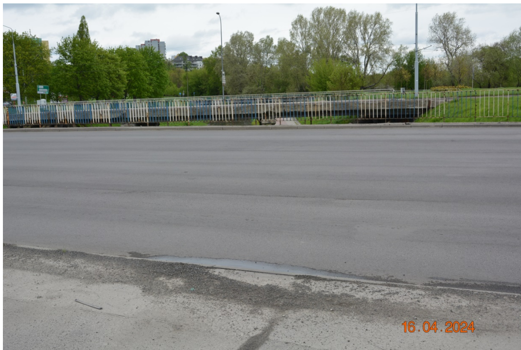
Fot. 11. Obszar dylatacyjny nad P3
