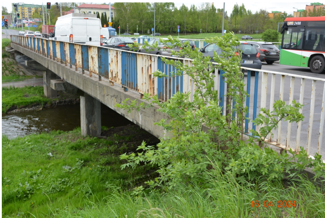
Fot. 2. Widok od strony DW
