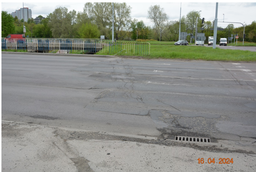
Fot. 12. Obszar dylatacyjny nad P4
