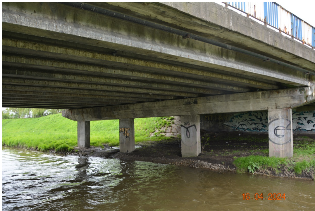
Fot. 7. Widok na podporę pośrednią P2
