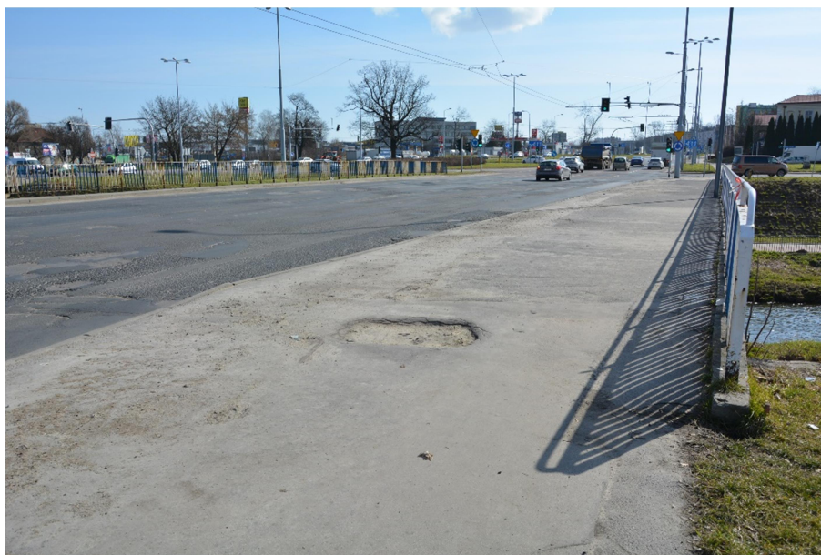
Fot. 2. Widok na chodnik
