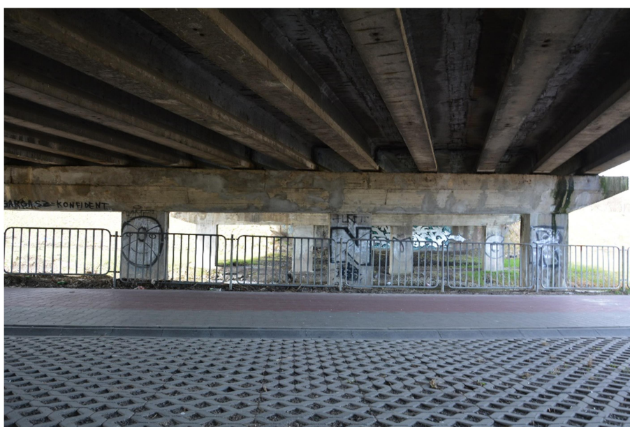
Fot. 4. Widok na ustrój i przestrzeń podmostową
